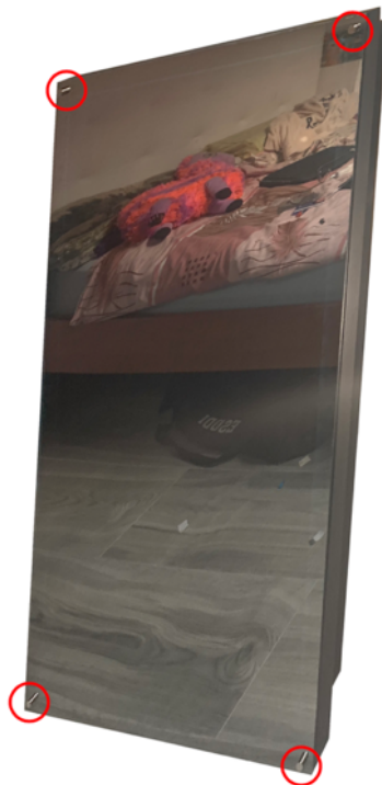
Figura 19. Espejo atornillado al marco con embellecedores (rodeados de rojo).
