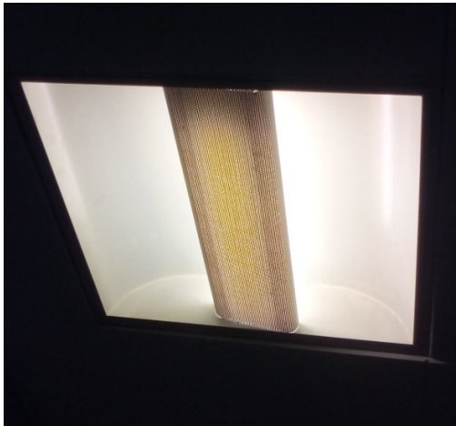
Ilustración 8: Luminaria fluorescencia compacta 60x60 actual y luminaria led 60x60 propuesta
