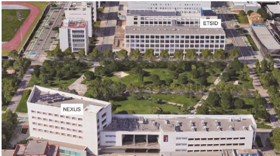
Figura 4.1: Localización de las plantas fotovoltaicas en el campus Vera (UPV) [35].
