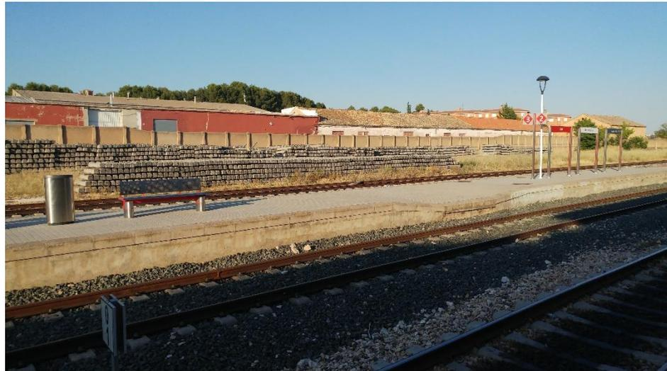
Figura 54. Acopio traviesas monobloque estación de Utiel [imagen capturada en visita a vía]
