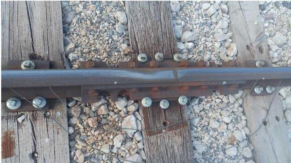
Figura 24. Junta desgastada por el paso de convoyes [imagen tomada en visita a vía]
