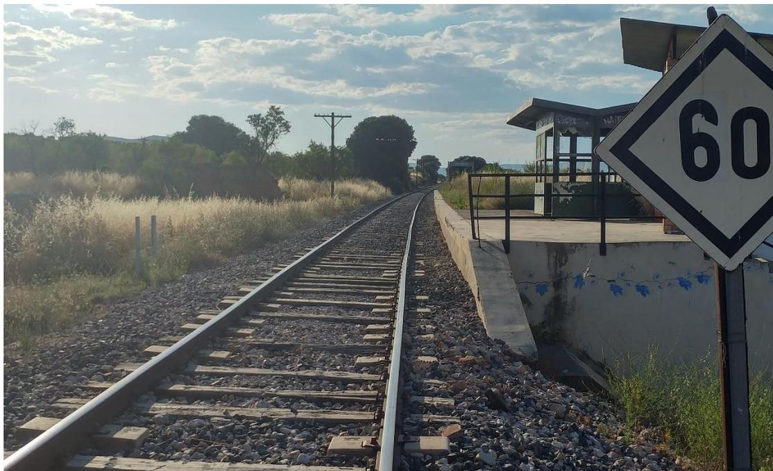
*Figura 20. Defecto de alineación horizontal del carril apeadero de Las Cuevas
