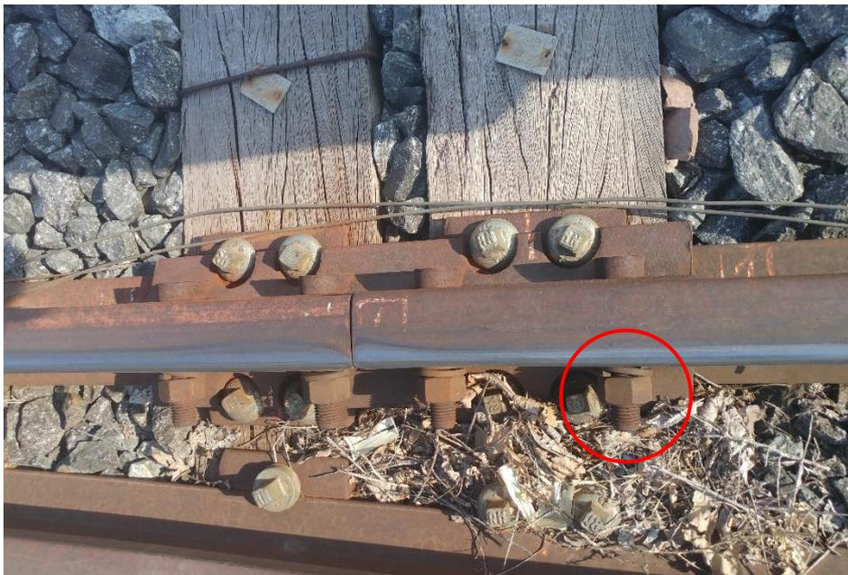
Figura 23. Ejemplo de sujeción de brida deficiente [imagen tomada en visita a vía]
