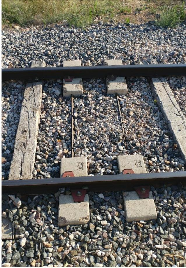
*Figura 27. Travesas sustituidas por bloque de hormigón prefabricado [imagen tomada en visita a vía]*
