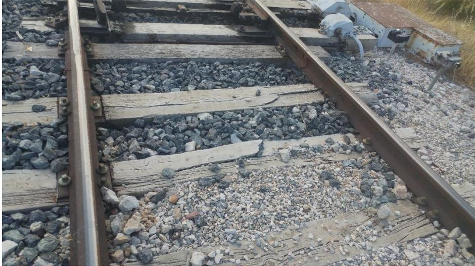
*Figura 33. Ejemplo de traviesas fisuradas estación de Camporrobles
