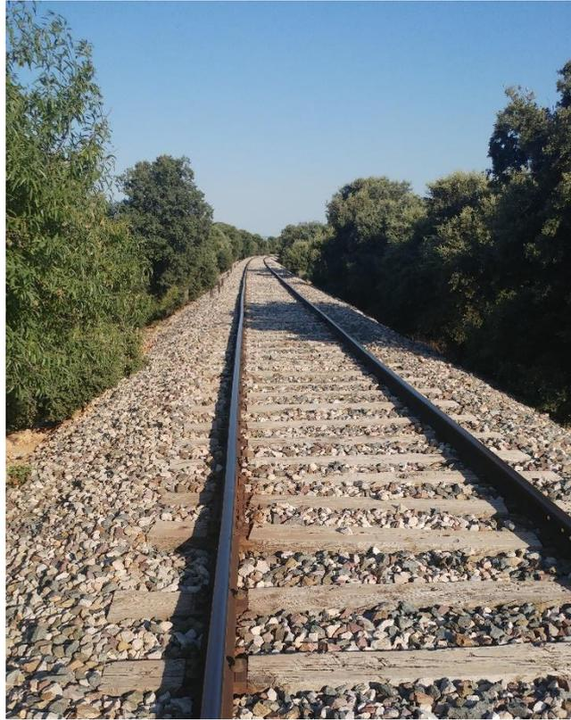
*Figura 19. Defecto de alineación horizontal del carril
