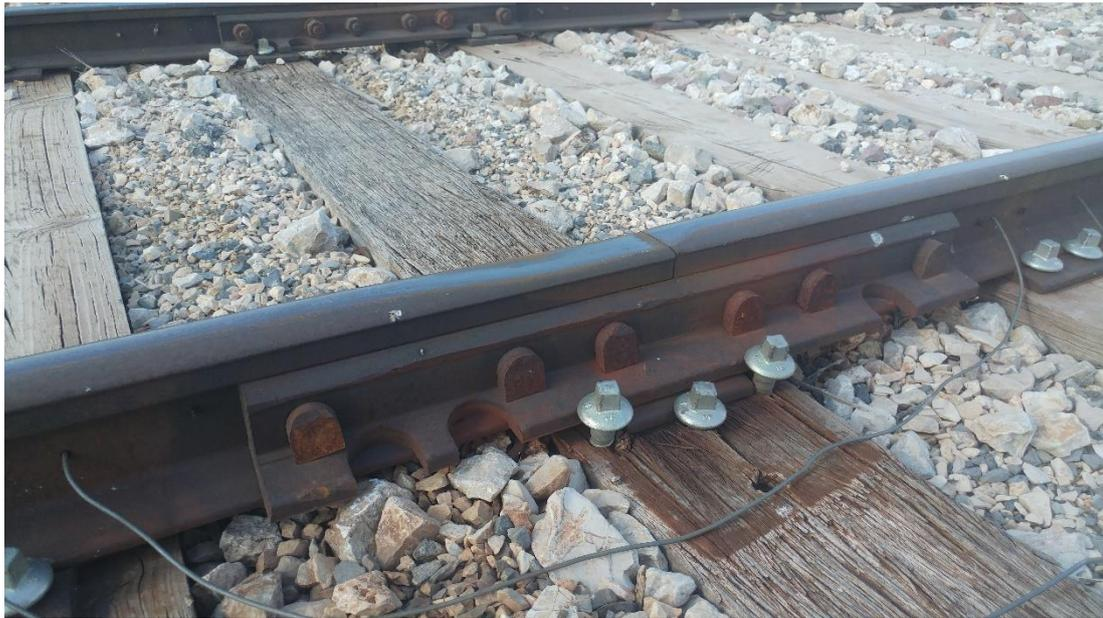
Figura 11. Ejemplo de brida de unión incorrectamente sujeta a la traviesa [imagen tomada en visita a vía]
