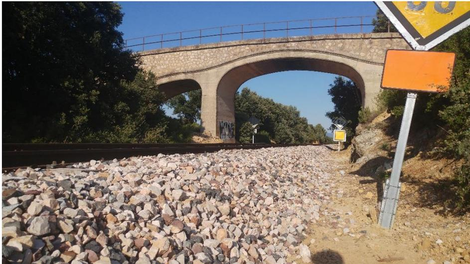
*Figura 46. Posibles recrecidos en banqueta de balasto por acumulación de agua de lluvia [imagen tomada en visita a vía]*
