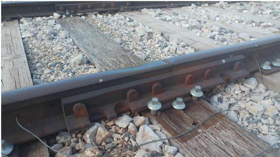
Figura 25. Junta desgastada por el paso de convoyes [imagen tomada en visita a vía]
