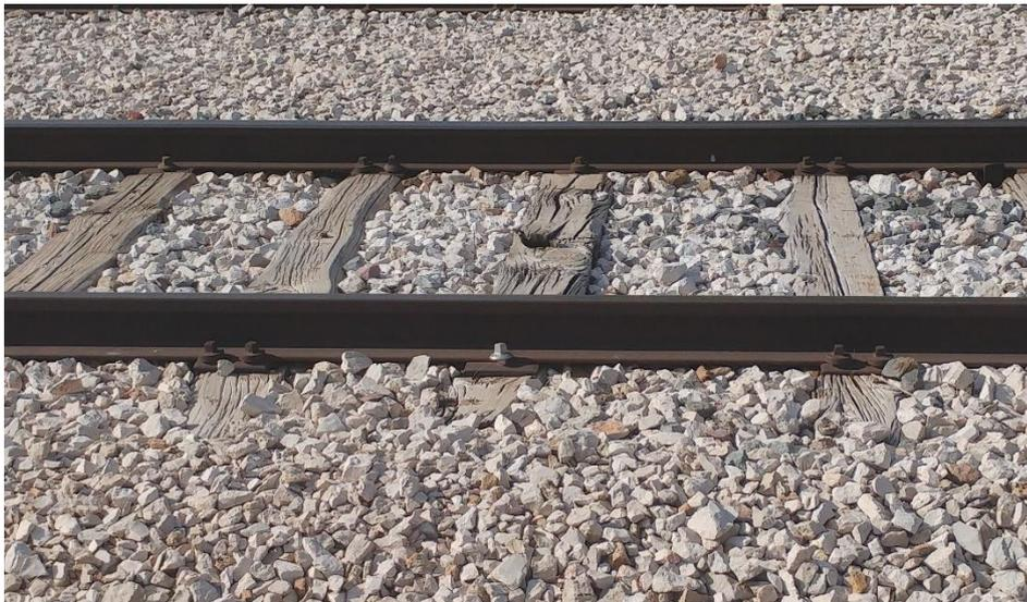
*Figura 42. Traviesas potencialmente inservibles [imagen tomada en visita a vía]*
