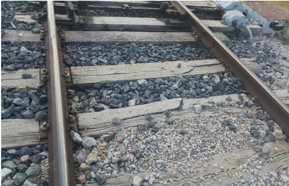
Figura 15. Ejemplo desgaste cara superior carril [imagen tomada en visita a vía]
