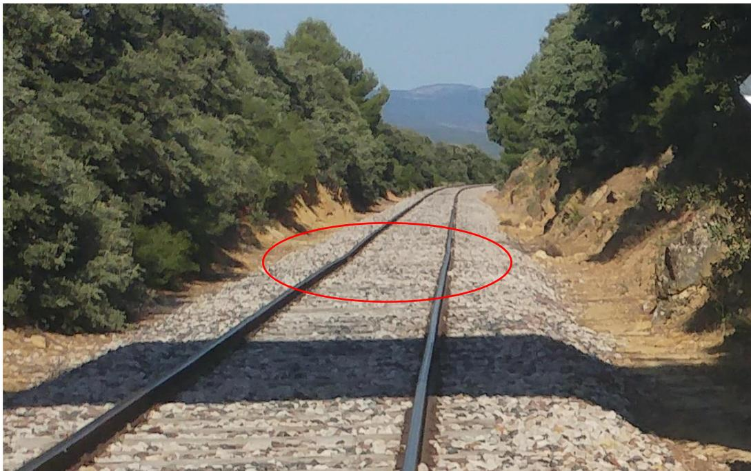
Figura 22. Defecto de alineación vertical del carril [imagen tomada en visita a vía]
