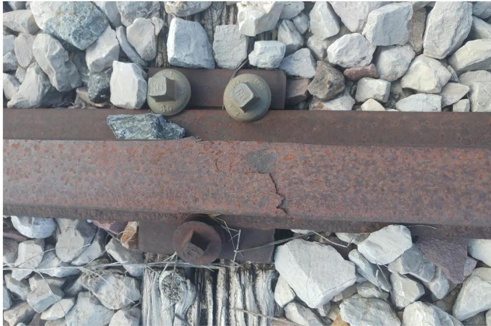
Figura 16. Descascarillado de carril [imagen tomada en visita a vía]
