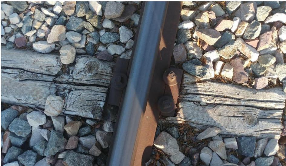
*Figura 45. Placa base mal ubicada en traviesa [imagen tomada en visita a vía]*
