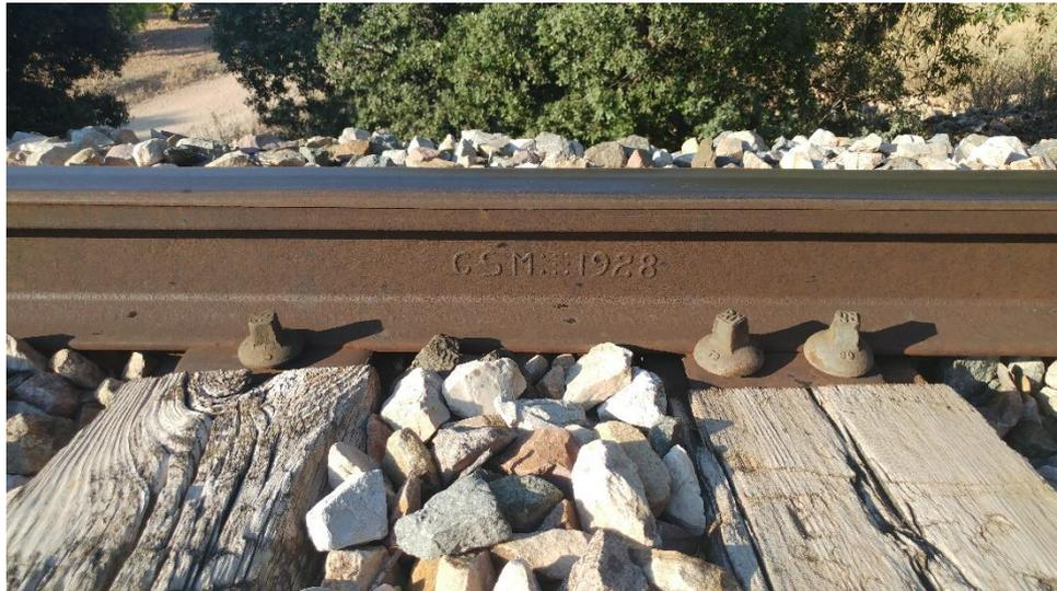
Figura 13. Carril de CSM 42,5 kg/m (año fabricación 1.928) [imagen tomada en visita a vía]
