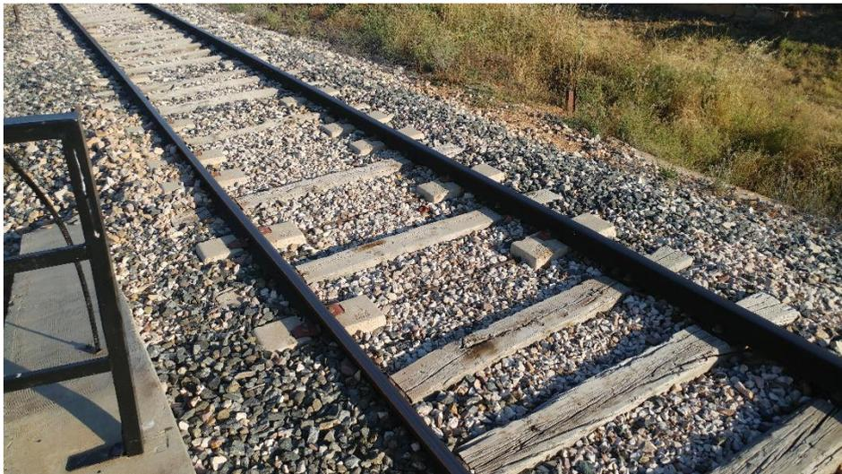
*Figura 28. Travesas sustituidas por bloque de hormigón prefabricado [imagen tomada en visita a vía]*
