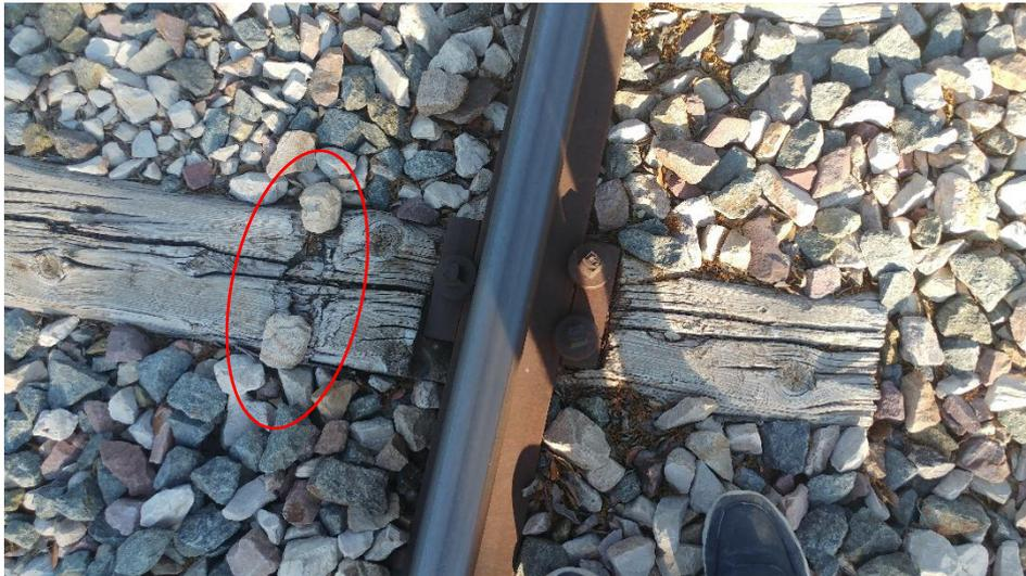
Figura 37. Ejemplo de hendidura por descarrilo en traviesas [imagen tomada en visita a vía]
