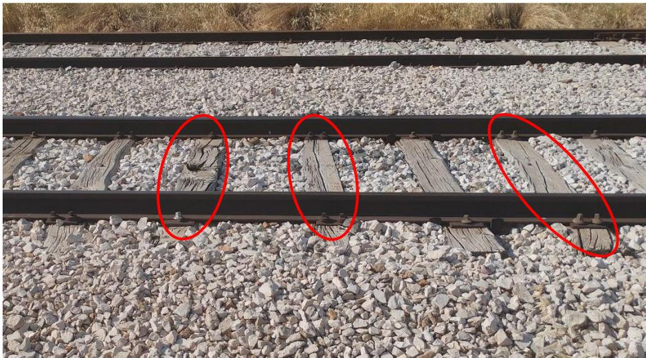
*Figura 34. Ejemplo de traviesas fisuradas estación de Camporrobles
