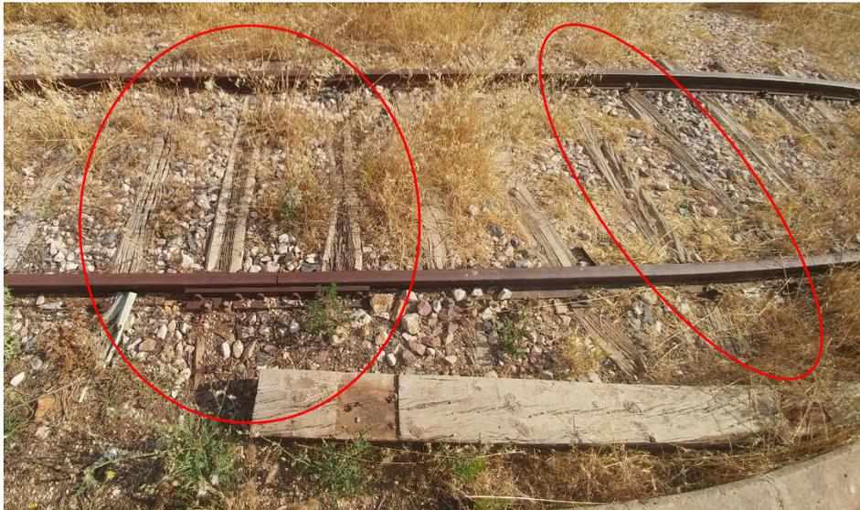
*Figura 41. Traviesas potencialmente inservibles [imagen tomada en visita a vía]*
