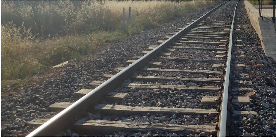
Figura 29. Alternancia traviesas madera con bloque [imagen tomada en visita a vía]
