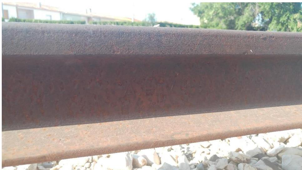
Figura 12. Carril de AHV 42,5 kg/m (año fabricación (1.929) [imagen tomada en visita a vía]
