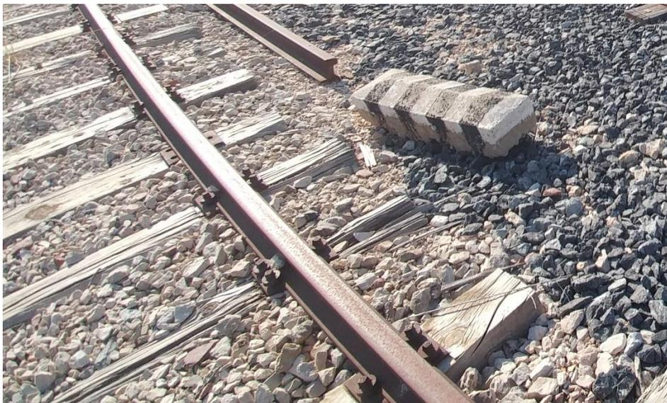
Figura 44. Travesías potencialmente inservibles [imagen tomada en visita a vía]
