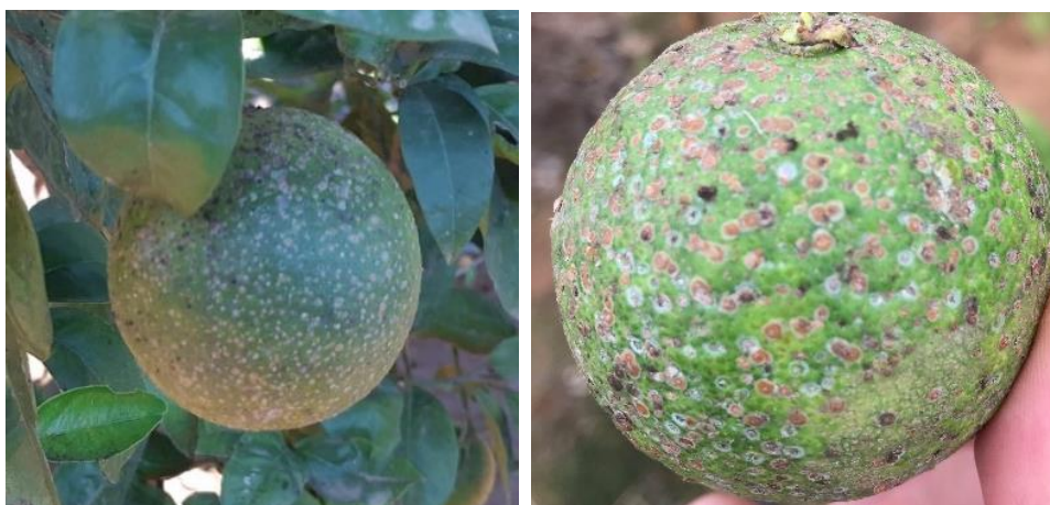
Figura 6. Presencia de daños en la piel.
