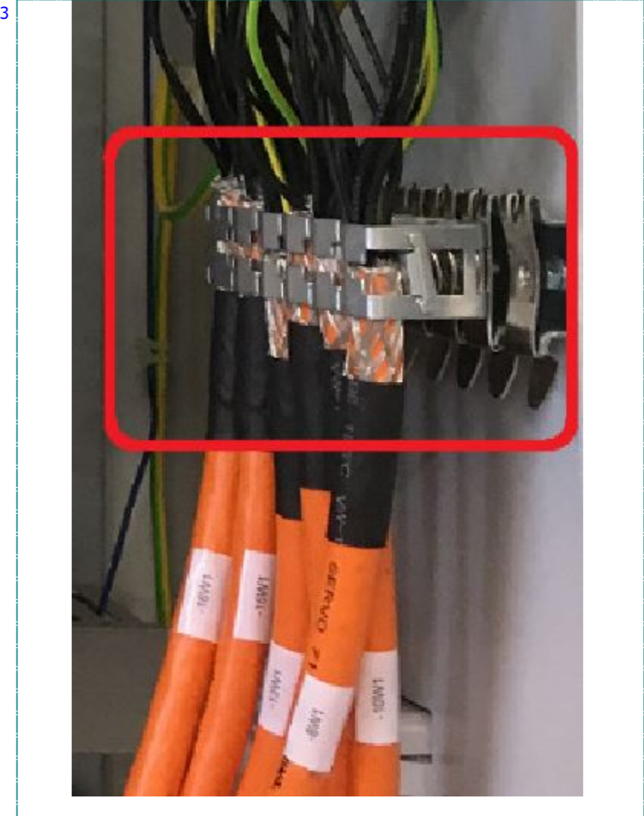
DETALLE ENTRADA MOTORES
