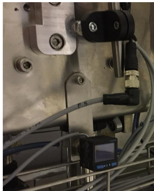
Figura 12. Detalle del montaje del vacuostato.
