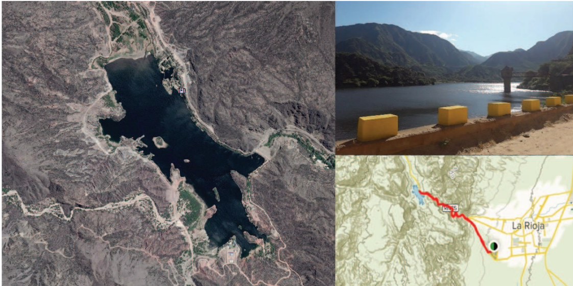
Figura 13 - Dique "Los Sauces" Fuente: Google Earth 2020.
