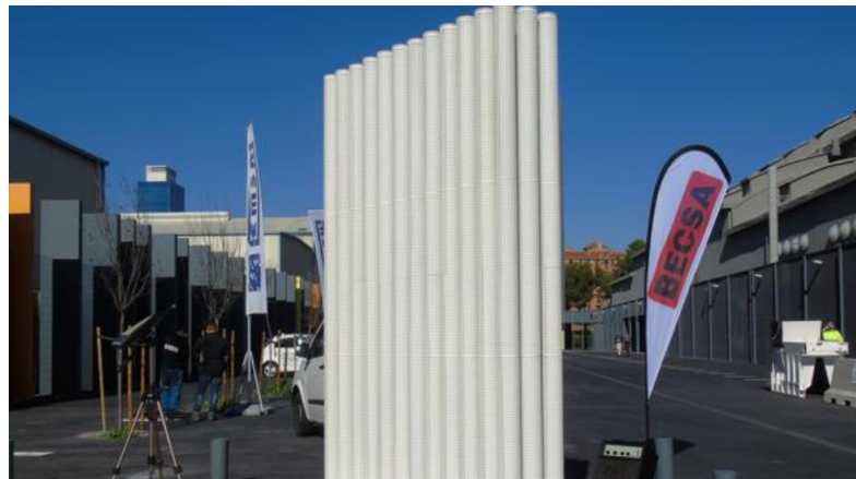
FIGURA 2: EJEMPLO DE BARRERA ACÚSTICA BASADA EN CRISTALES (DISEÑO DE UPV Y BECSA)
