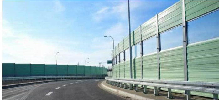
FIGURA 1: PANTALLA ACÚSTICA DE METACRILATO
