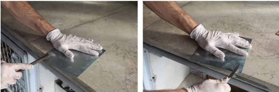
**Imágenes 6.23 y 6.24.** Limado del borde de la plancha a 45° (izquierda) y eliminación de rebabas con el rascador (derecha). Fotografías del autor.
