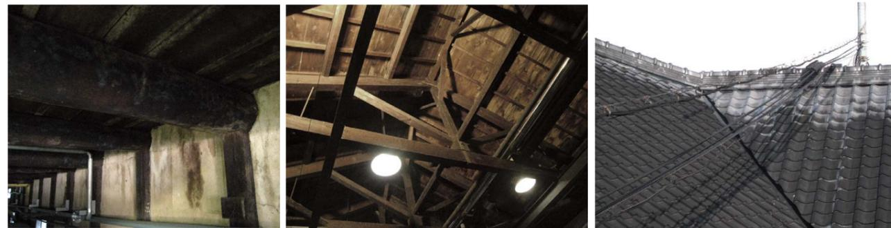
Humedades en elementos de entramado estructural y en paramentos verticales, necesidad de realizar un mantenimiento de la cubierta
