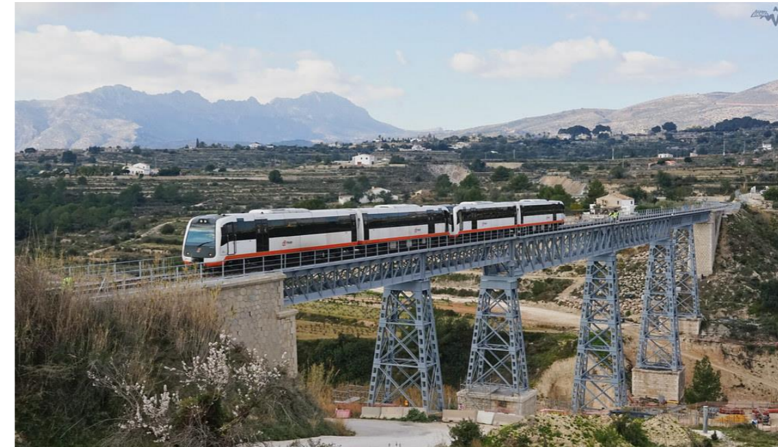
Ilustración 1.1.4. Estado actual del Viaducto de Santa Ana.
