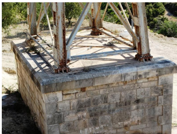
Ilustración 1.1.2. Detalle de las cimentaciones del Viaducto de Santa Ana (Fuente: periódico Información de Alicante).
