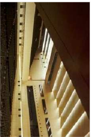
3. Falso de paneles de madera de arce para la sala multiusos.
