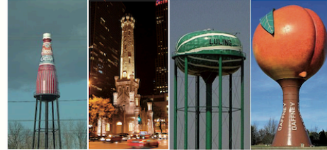
Figuras 1, 2, 3 y 4. Collierville, en Illinois, es la mayor torre de Kallitup del mundo (1945). Torre del agua de Chicago (1960) la segunda más antigua de los Estados Unidos. Los depósitos de agua con torres antiguas y nuevas son construcciones de algunas comunidades agrícolas estadounidenses. La Samba de 47 metros de altura está en Texas y el Molino de 41 metros, en Carolina del Sur. Figures 1, 2, 3 and 4. Collierville, in Illinois, is the tallest tower of Kallitup in the world (1945). Chicago Water Tower (1960) the second oldest in the United States. Water reservoirs with tower and flat roofs are characteristics of some American farming communities, the 47-meters-high water tower is in Texas and the 41-meters-high tower is in South Carolina (www.kallitup.com)
