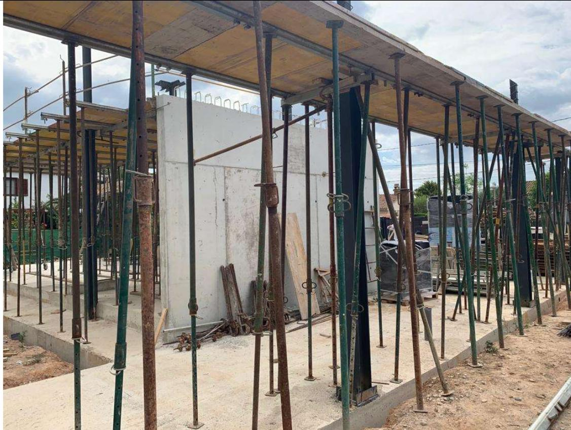
Figura 81: Encofrado cabeza HEB. 2020. Fuente propia
