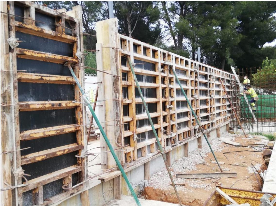
Figura 14: Encofrado de muro tipo 1 garaje. 2020. Fuente propia
