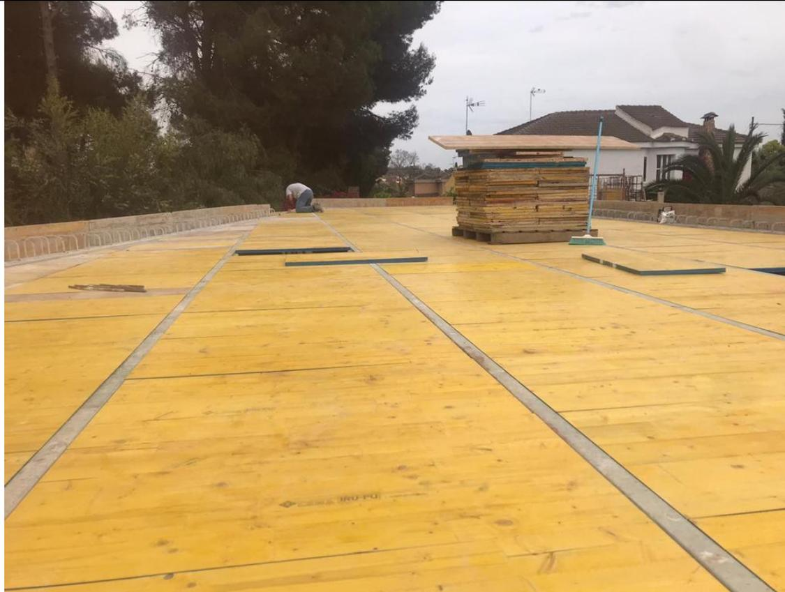
Figura 112: Encofrado forjado garaje. 2020. Fuente propia
