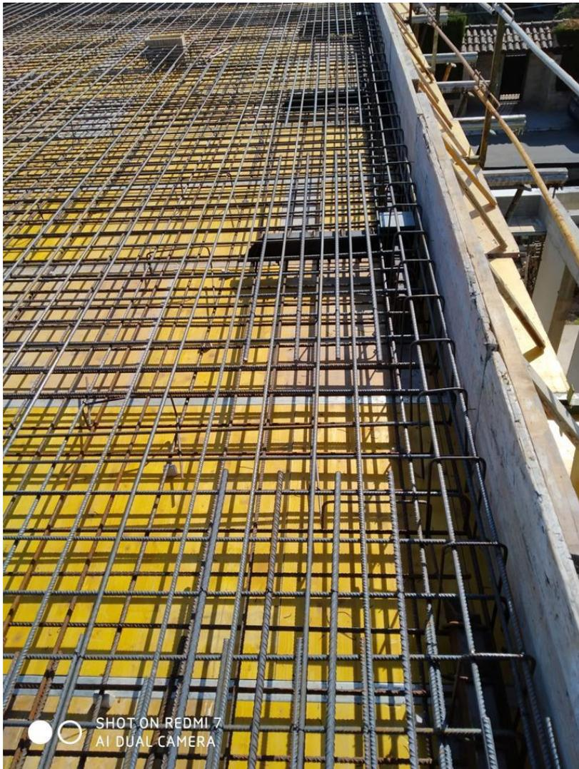
Figura 65: Armado de forjado vivienda a +7,30m. 2020. Fuente propia
