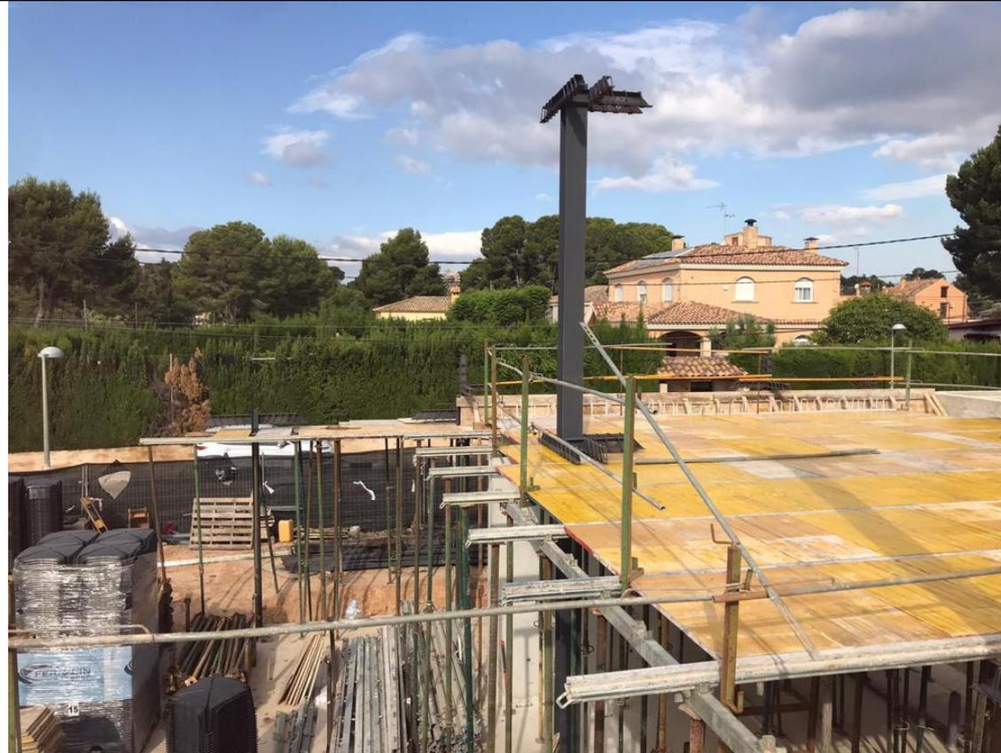
Figura 104: Protección de borde encofrado. 2020. Fuente propia
