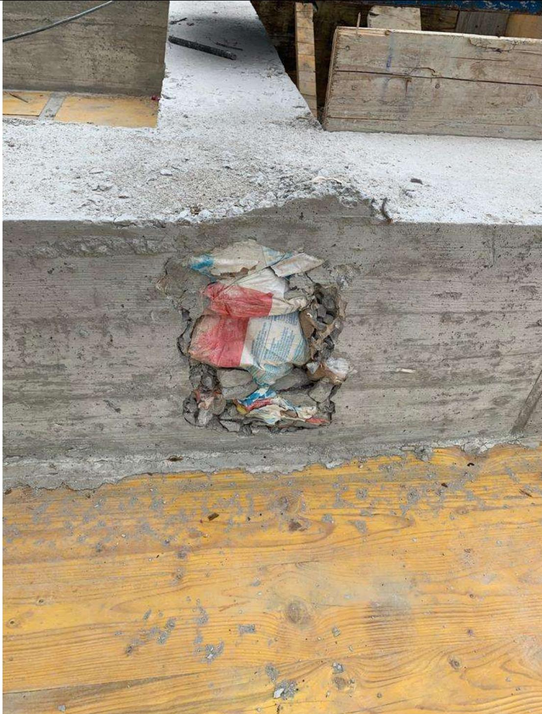
Figura 89: Relleno hueco con bolsas para entrada IPE. 2020. Fuente propia
