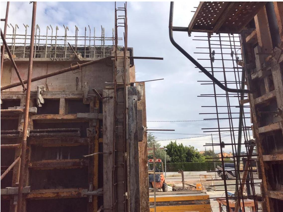
Figura 21: Muros encofrados de bunker desde dentro. 2020. Fuente propia
