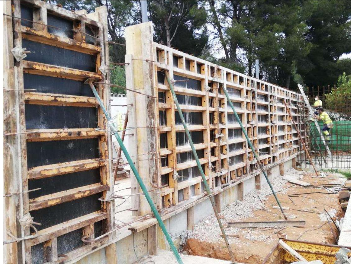
Figura 72: Encofrados de muro garaje. 2020. Fuente propia
