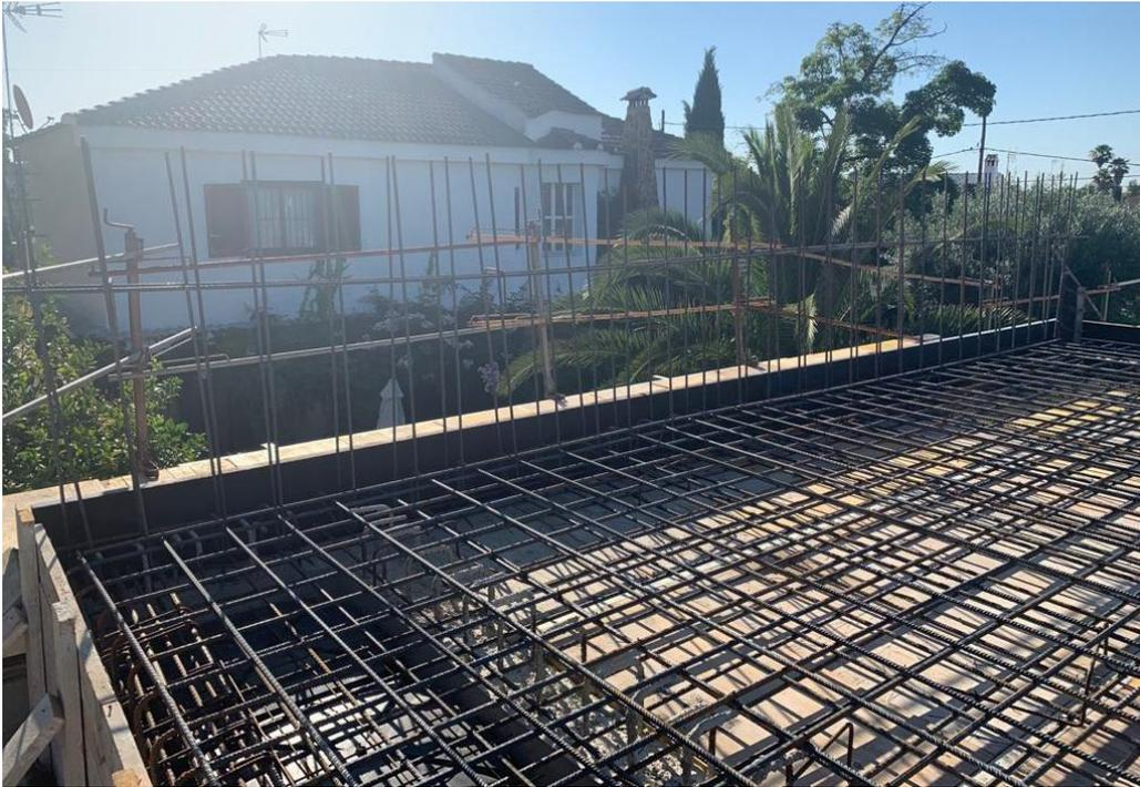
Figura 58: Esperas de forjado superior de vivienda en planta baja a +4,08m para muro tipo 5. 2020. Fuente propia
