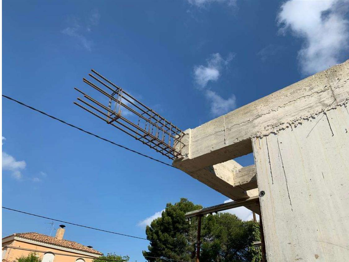
Figura 80: Esperas de viga 25x60. 2020. Fuente propia
