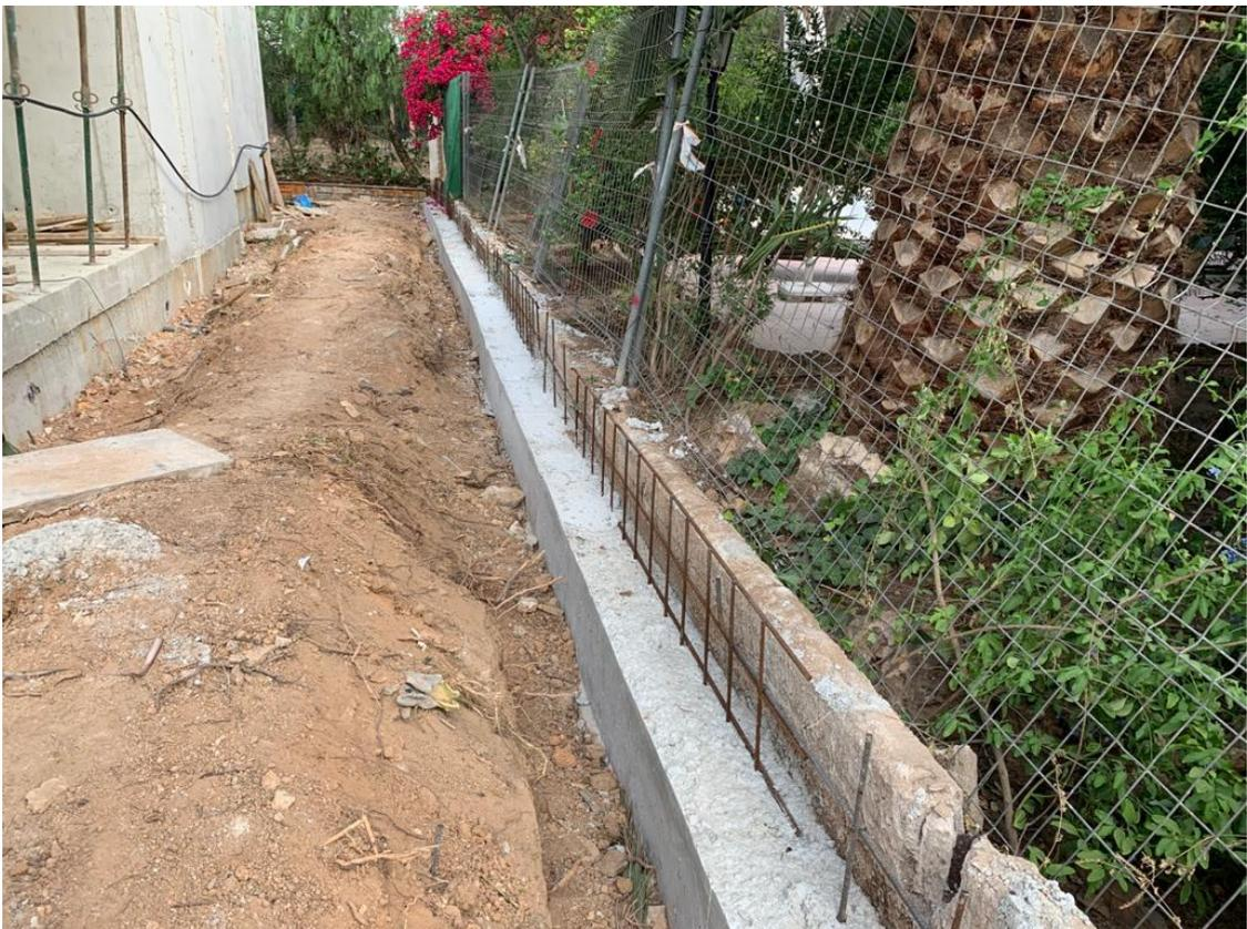
Figura 71: Cimentación muro perimetral. 2020. Fuente propia
