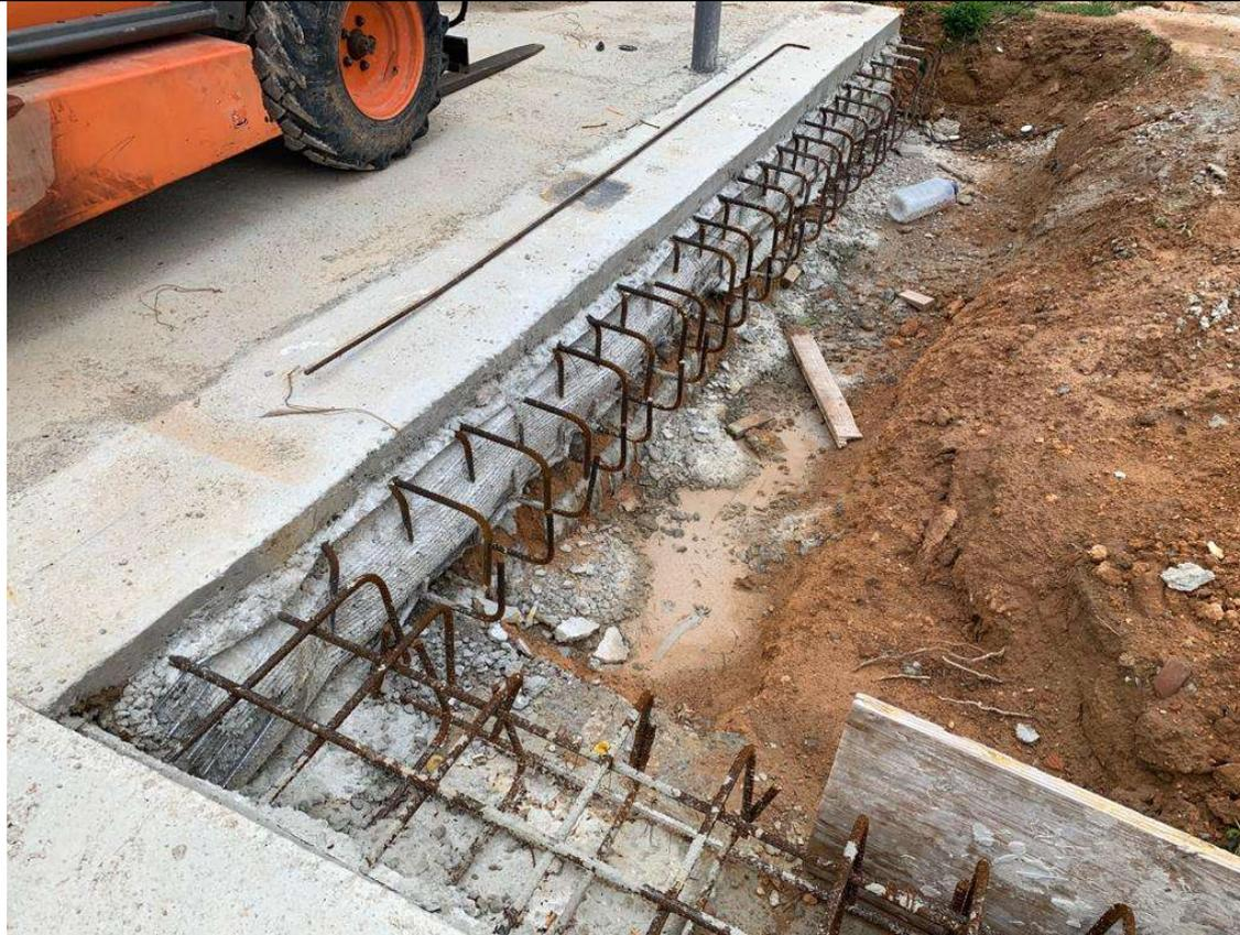
Figura 74: Esperas de losa de cimentación. 2020. Fuente propia
