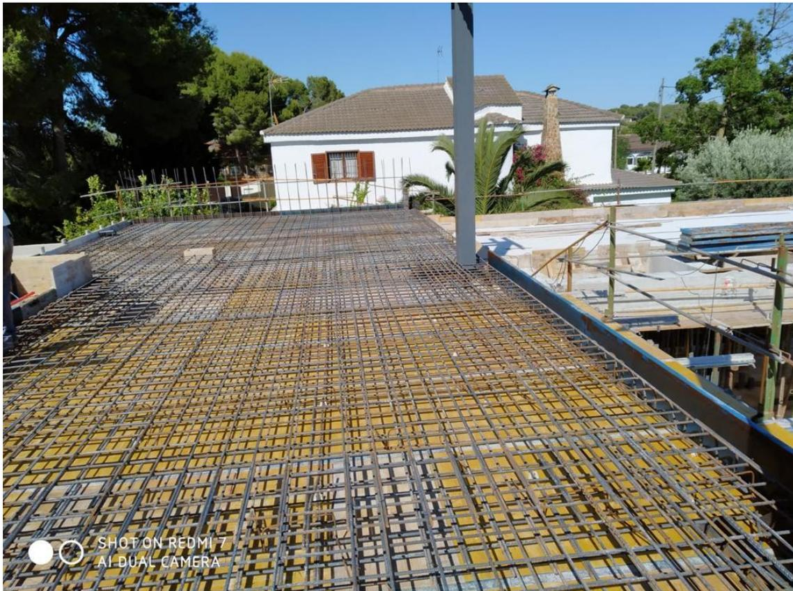
Figura 57: Encofrado y armado de forjado superior de vivienda en planta baja a +4,08m. 2020.
