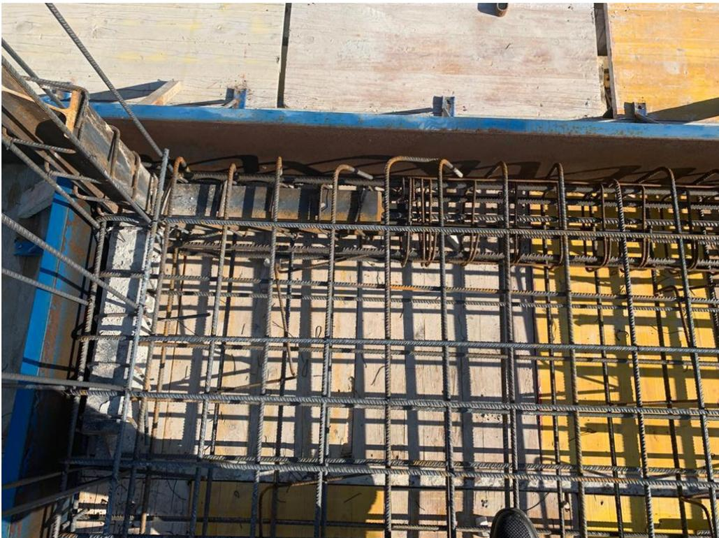
Figura 59: Encuentro de armado de viga de la parte de la escalera en forjado +4,08m, con la cruceta de pilar y esperas para muro tipo 5. 2020. Fuente propia
