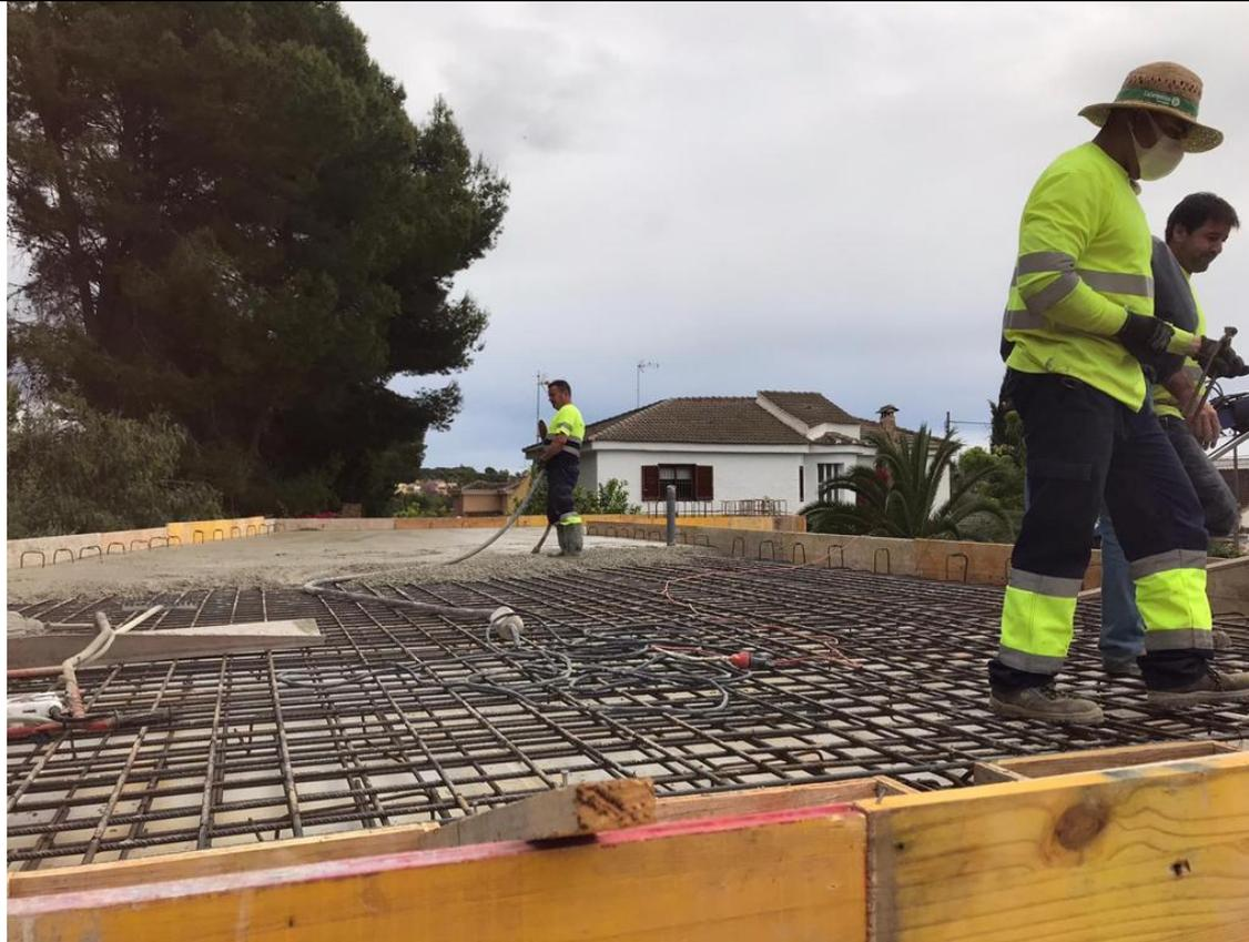
Figura 113: Hormigonado de losa. 2020. Fuente propia
