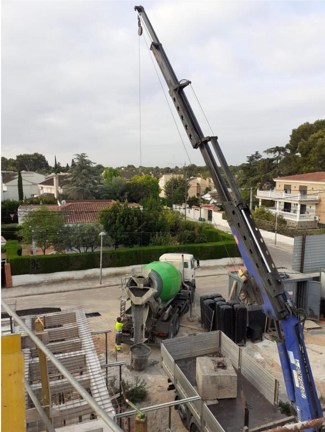
Figura 66: Descarga de hormigón en el embudo de hormigón. 2020. Fuente propia
