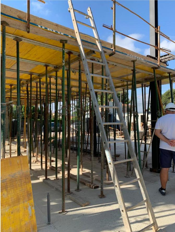
Figura 48: Encofrado de forjado superior de vivienda en planta baja a +3,56m. 2020. Fuente propia
