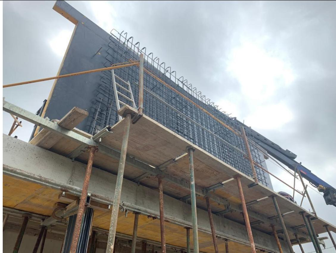
Figura 106: Protección de borde encofrado. 2020. Fuente propia
