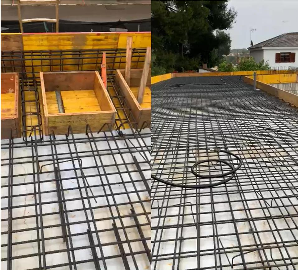
Figura 38: Encofrado y armado de forjado visto garaje. 2020. Fuente propia
