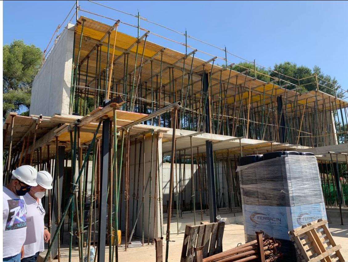
Figura 108: Protección de borde forjado. 2020. Fuente propia
