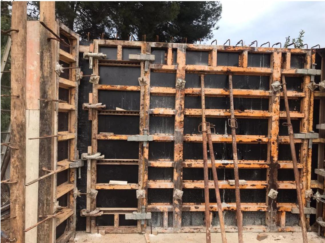
Figura 16: Encofrado muro tipo 1 garaje. 2020. Fuente propia
