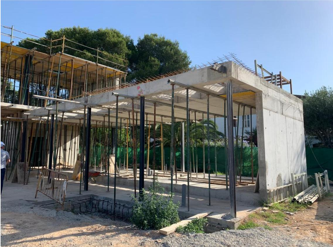
Figura 63: Forjado desencofrado vivienda a +3,56m y +4,08m. 2020. Fuente propia
