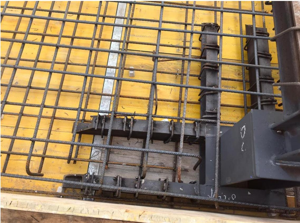
Figura 50: Encuentro armado de losa con crucetas UPN de pilares 1. 2020. Fuente propia
