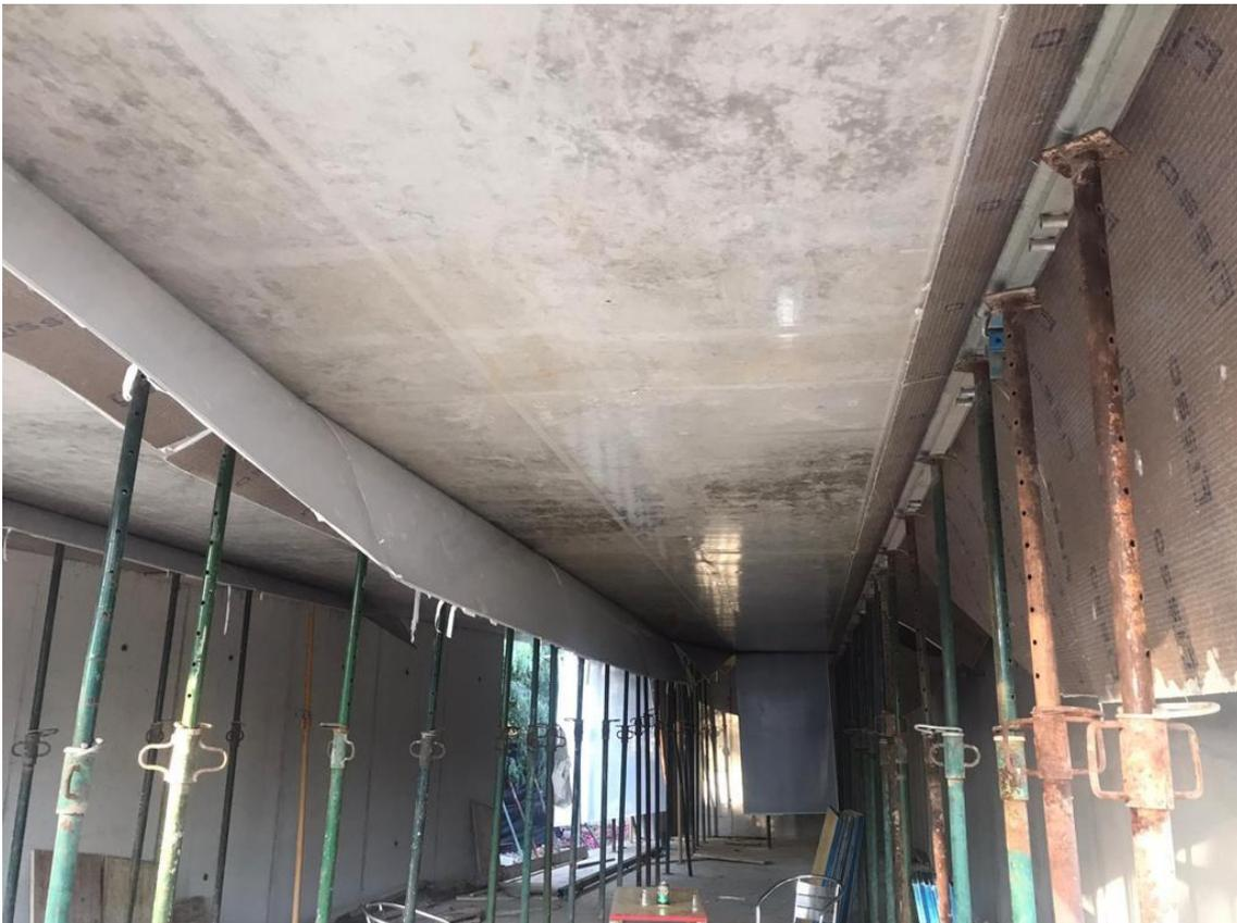
Figura 46: Forjado caravista en garaje desencofrado. 2020. Fuente propia
