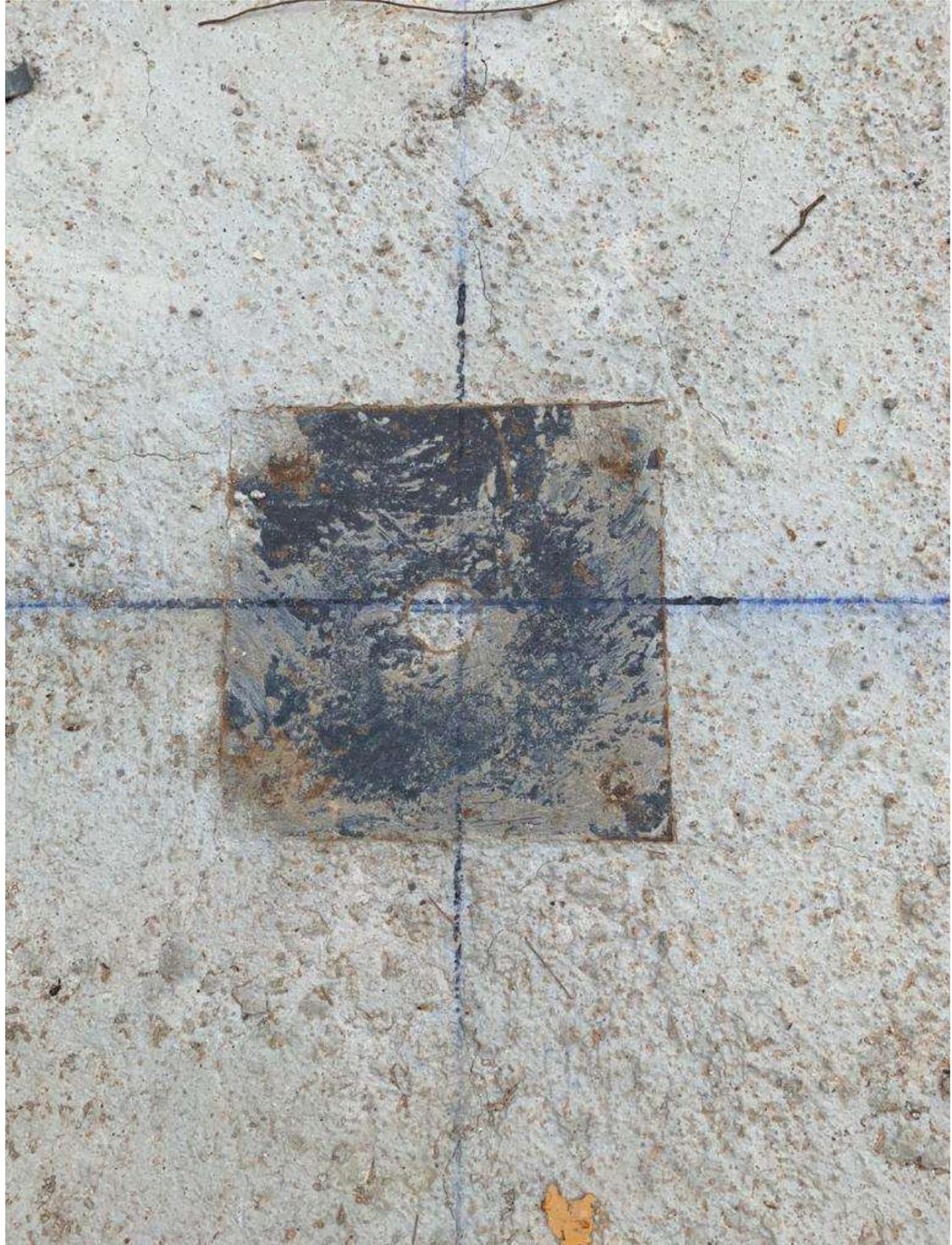
Figura 73: Placa de anclaje. 2020. Fuente propia
