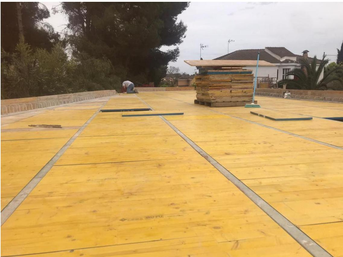
Figura 33: Encofrado forjado visto garaje. 2020. Fuente propia
