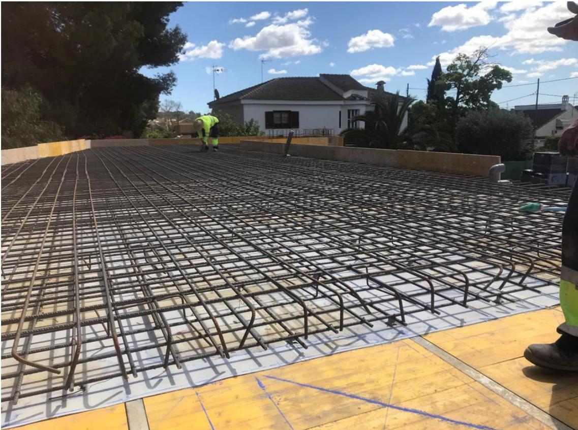
Figura 37: Encofrado y armado de forjado visto garaje y forjado bunker. 2020. Fuente propia
