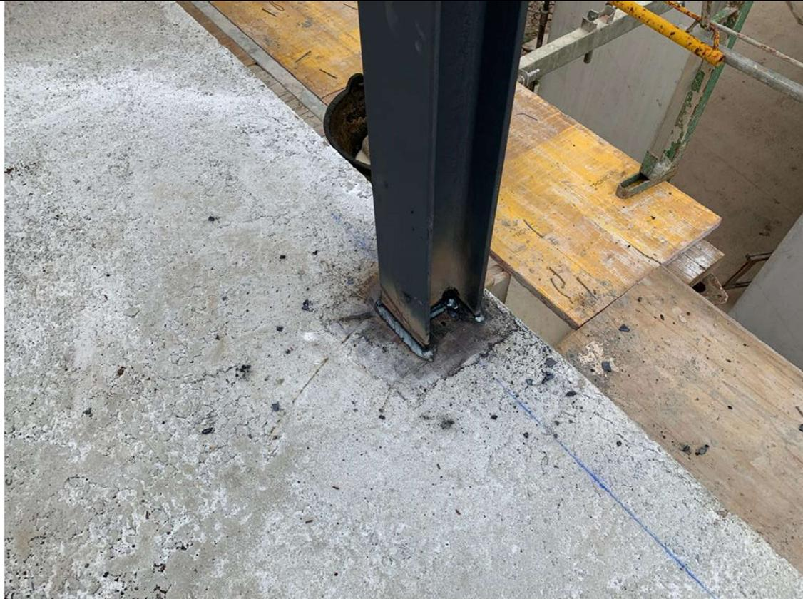
Figura 88: Soldado pilar HEB en placa. 2020. Fuente propia
