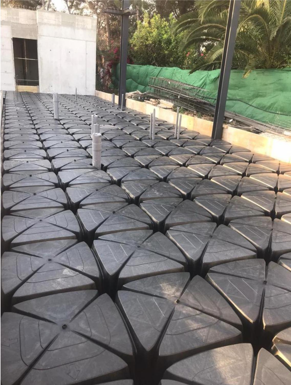
Figura 47: Encofrado de solera de hormigón con correcto Caviti. 2020. Fuente propia
