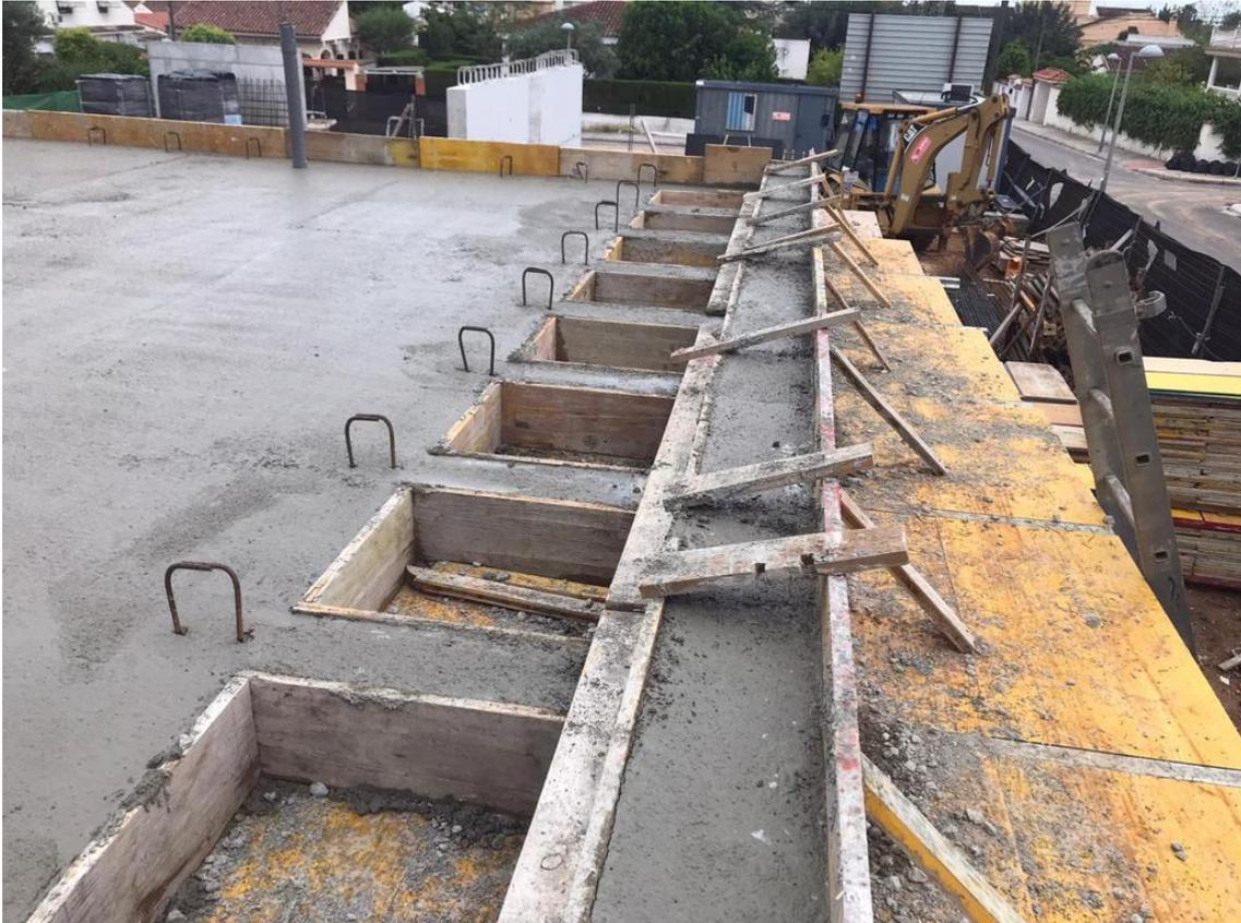
Figura 41: Viga 25x60 hormigonada en forjado garaje. 2020. Fuente propia
