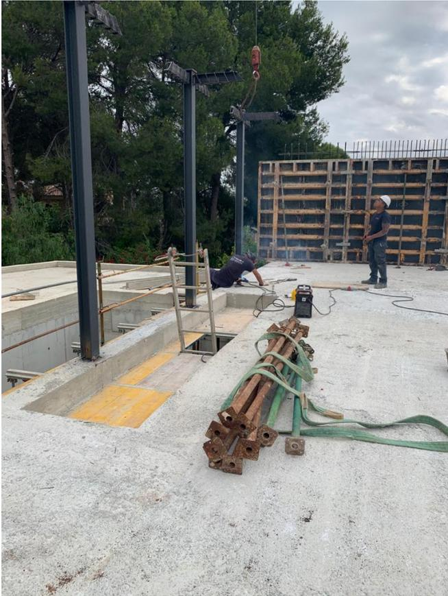
Figura 61: Colocación, fijado y soldado en las placas de anclaje ya dispuestas, de pilares HEB. 2020. Fuente propia
