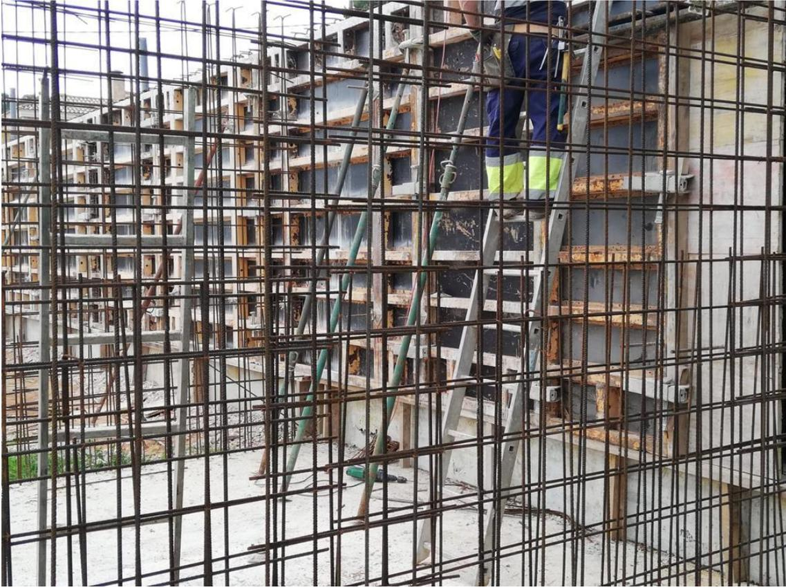
Figura 15: Encofrado muro tipo 2 garaje-bunker y armado de muro tipo 2 bunker. 2020. Fuente propia
