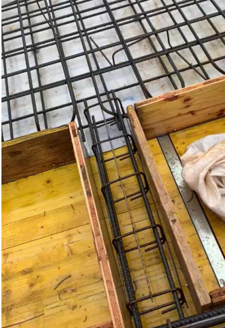
Figura 94: Armado de anclaje. 2020. Fuente propia
