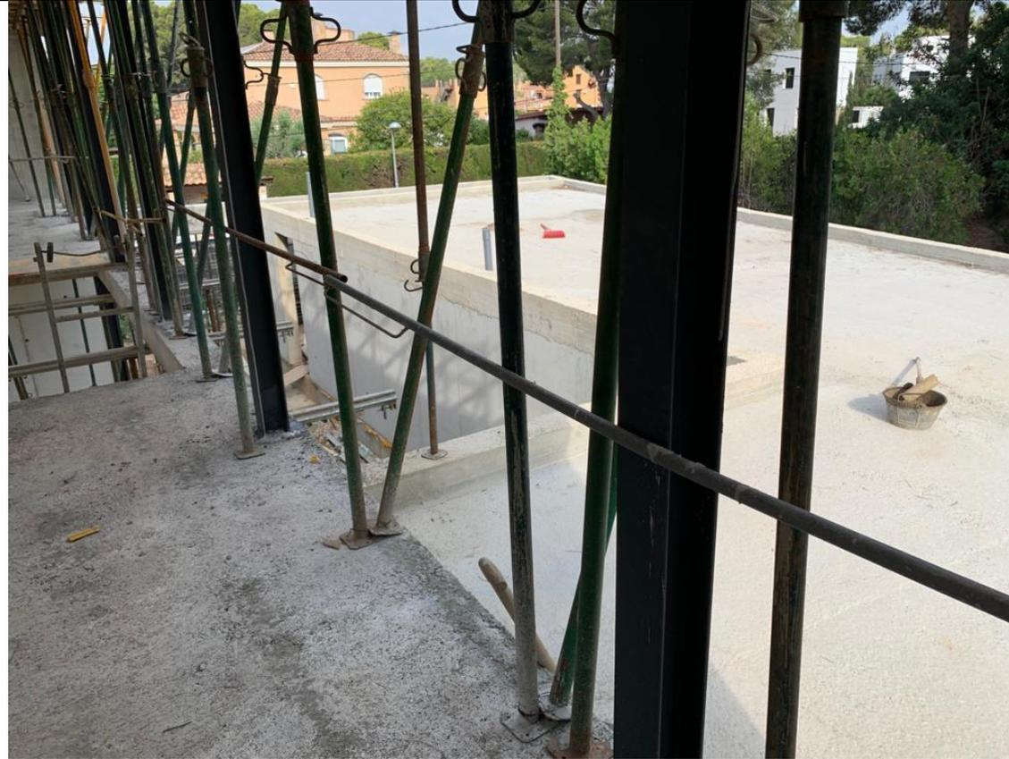
Figura 119: Protección de borde forjado. 2020. Fuente propia
