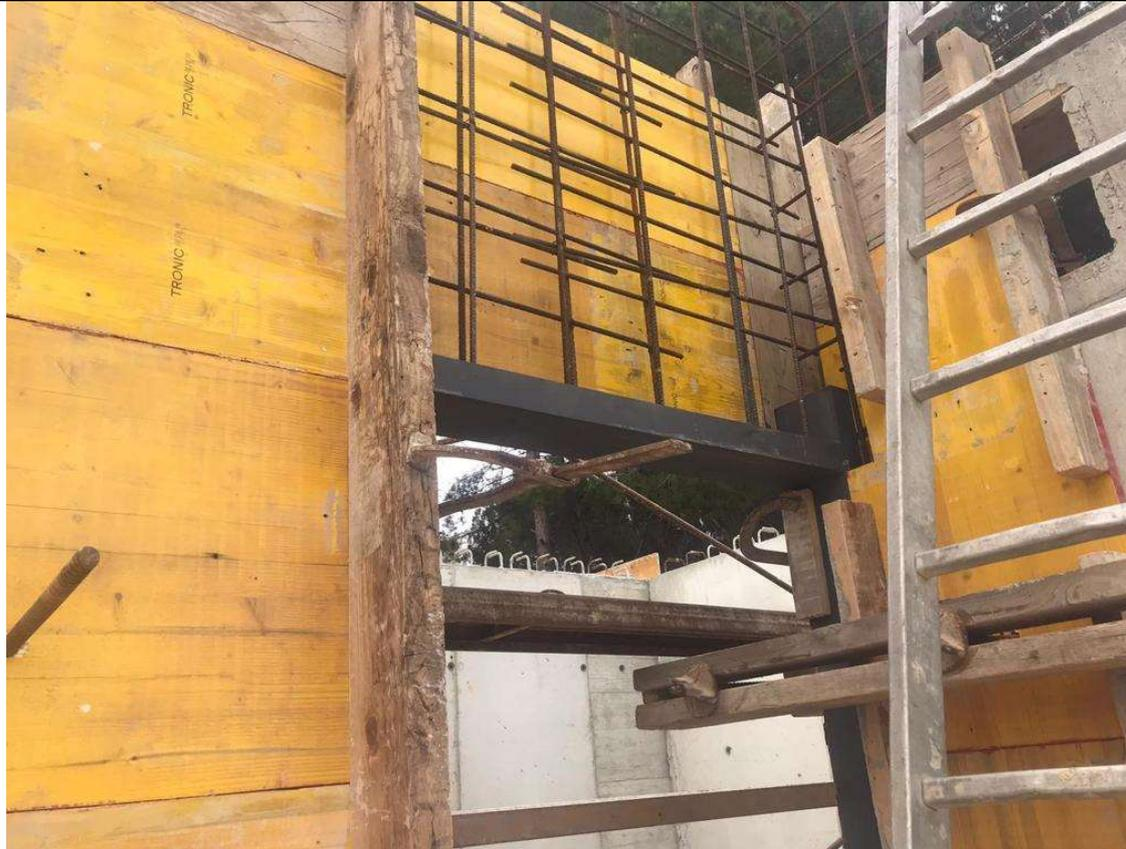
Figura 75: Soldado de armaduras en premarco bunker. 2020. Fuente propia
