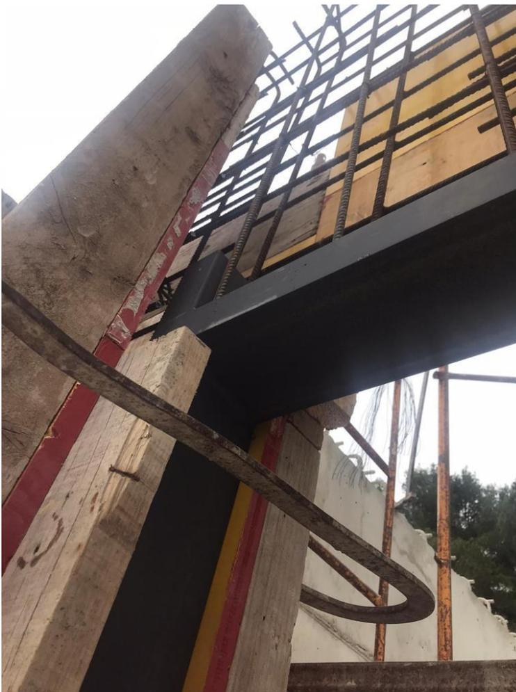
Figura 31: Premarco puerta acorazada en bunker. 2020. Fuente propia
