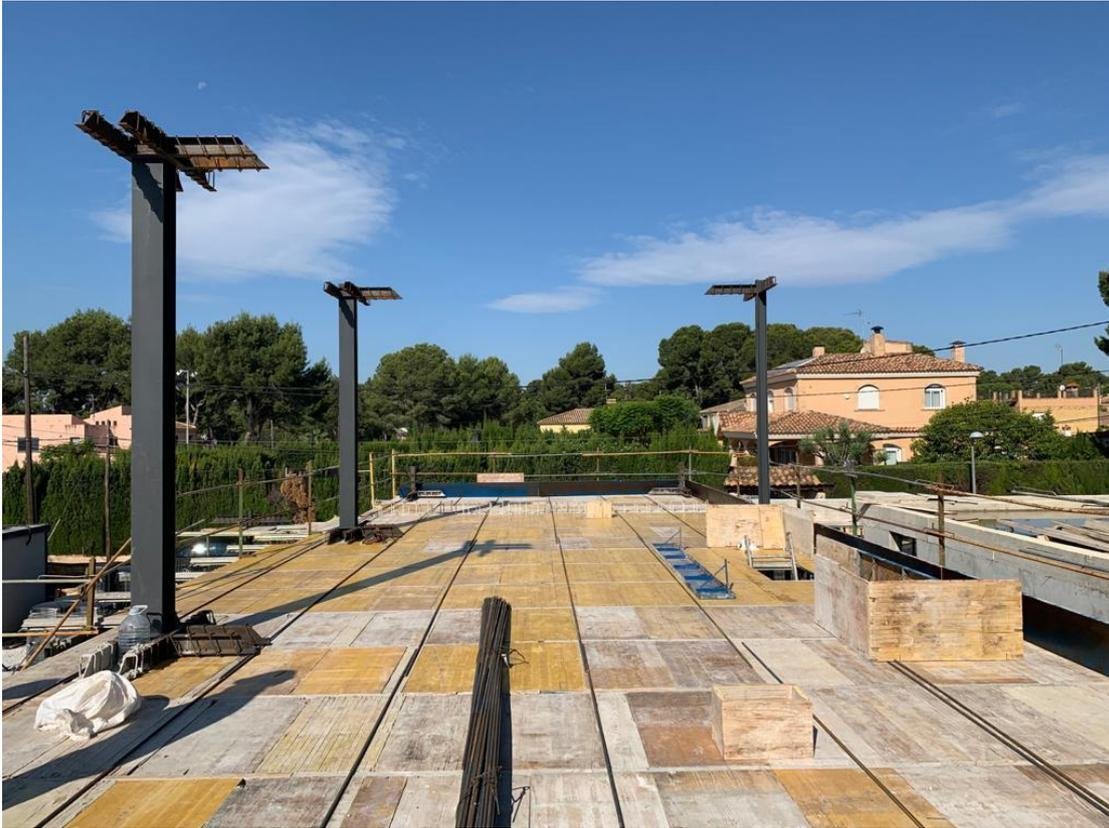
Figura 55: Encofrado de forjado superior de vivienda en planta baja a +4,08m. 2020. Fuente propia
