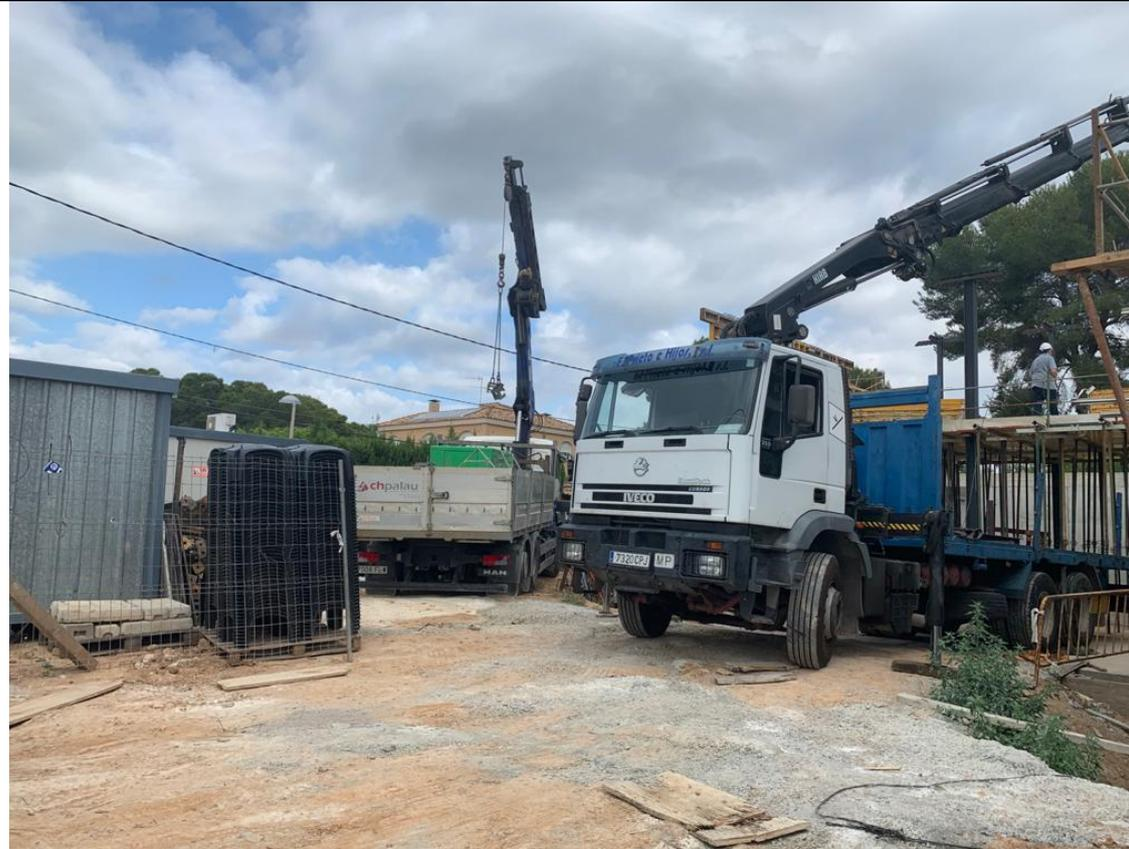
Figura 117: Solape de radios de acción de camiones grúa. 2020. Fuente propia
