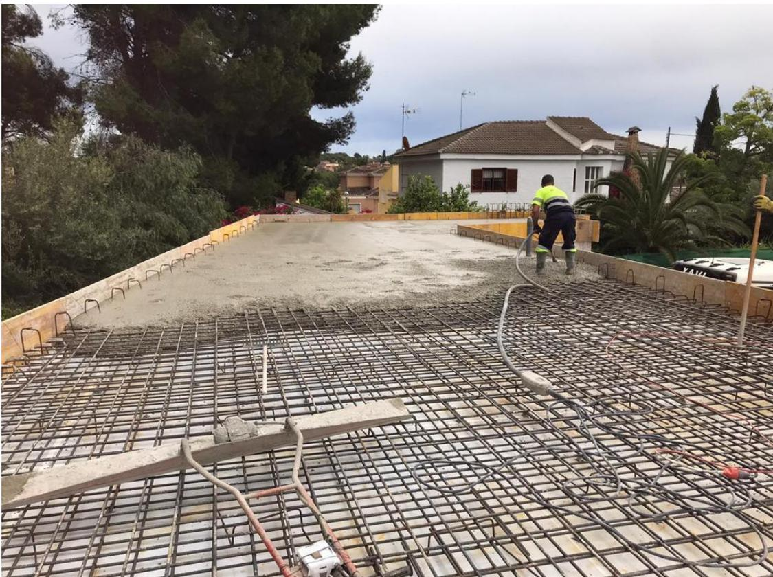
Figura 42: Hormigonado forjado visto garaje y forjado bunker. 2020. Fuente propia
