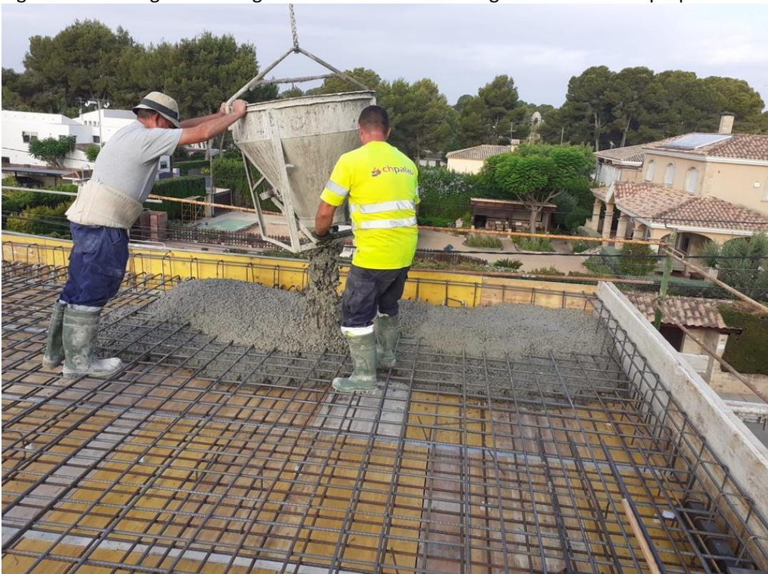
Figura 67: Hormigonado de forjado vivienda a +7,30m. 2020. Fuente propia
