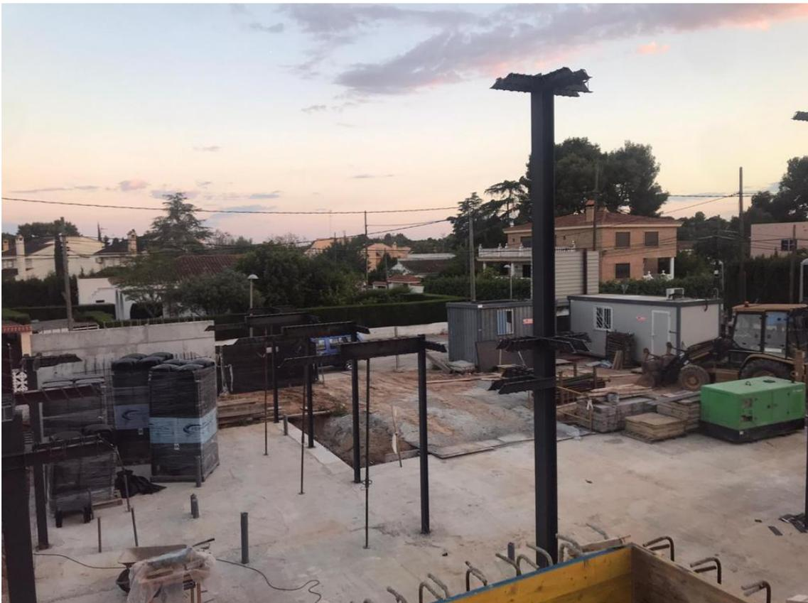
Figura 43: Foto general de la obra con pilares HEB desde forjado garaje. 2020. Fuente propia
