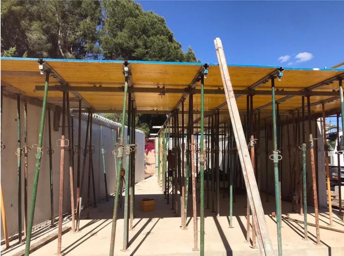
Figura 29: Encofrado de forjado visto vista 1. 2020. Fuente propia
