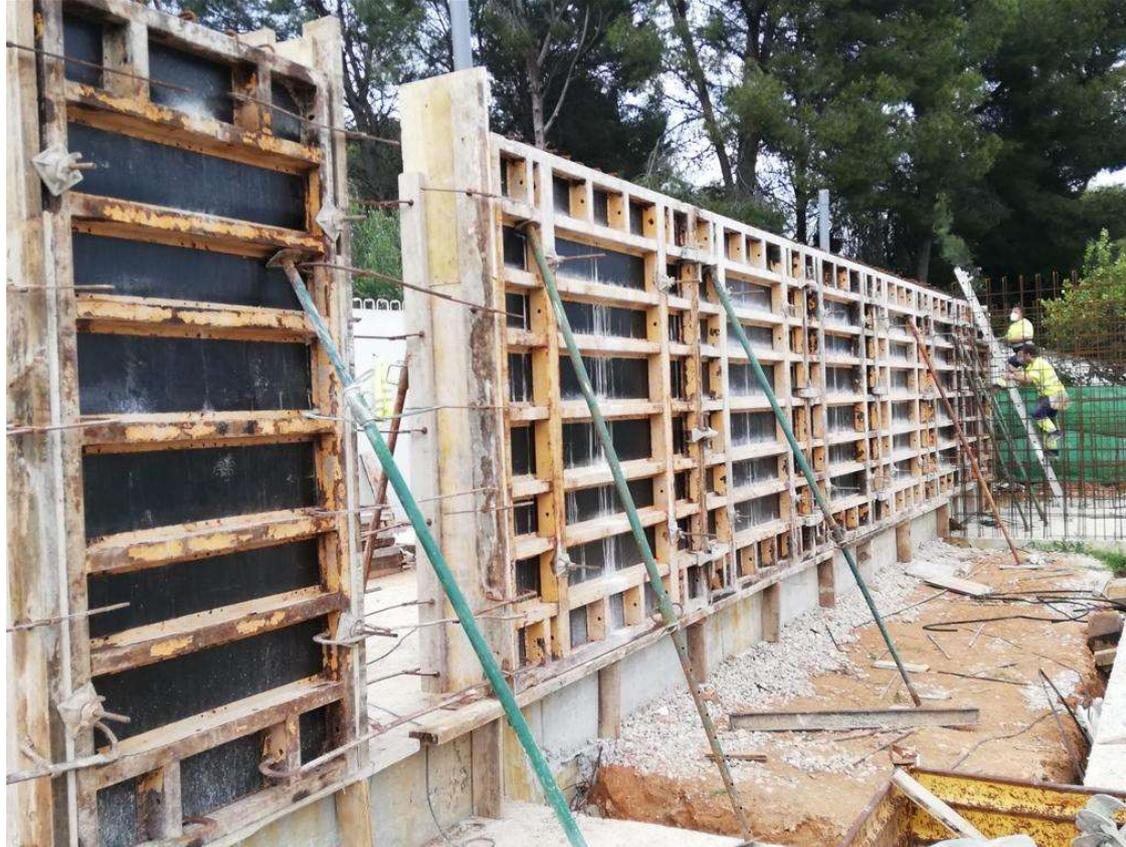
Figura 92: Encofrados de más de 2m de altura. 2020. Fuente propia
