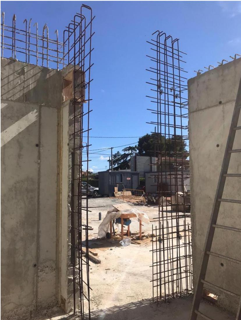
Figura 22: Muros desenclavados de bunker desde dentro. 2020. Fuente propia
