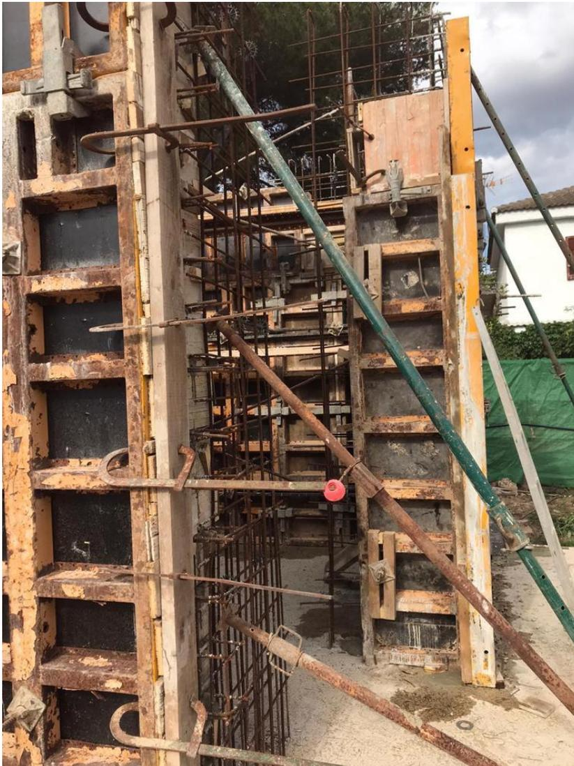
Figura 19: Muros encofrados de bunker desde fuera 1. 2020. Fuente propia
