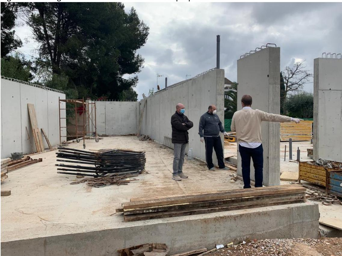
Figura 18: Garaje de edificio con muros desencofrados. 2020. Fuente propia
