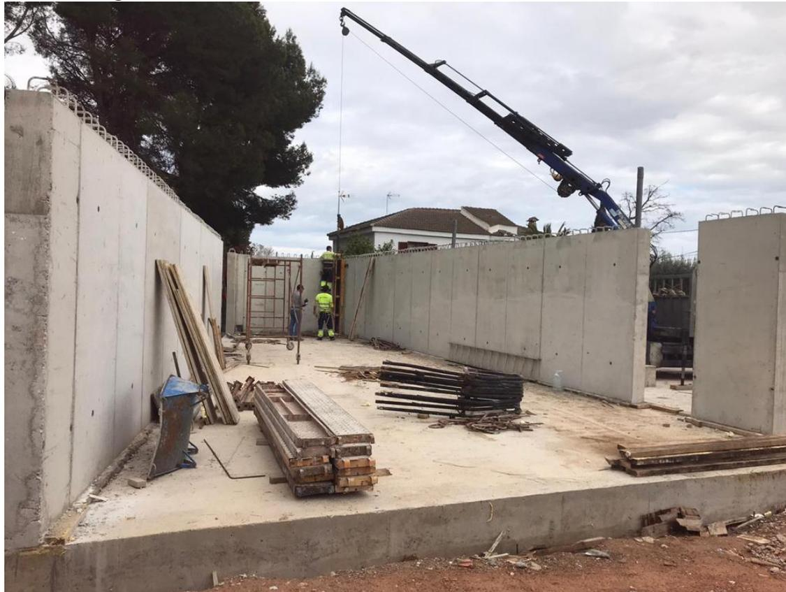
Figura 111: Operarios sin casco de seguridad. 2020. Fuente propia
