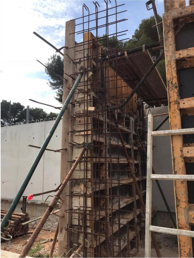
Figura 20: Muros encofrados de bunker desde fuera 2. 2020. Fuente propia
