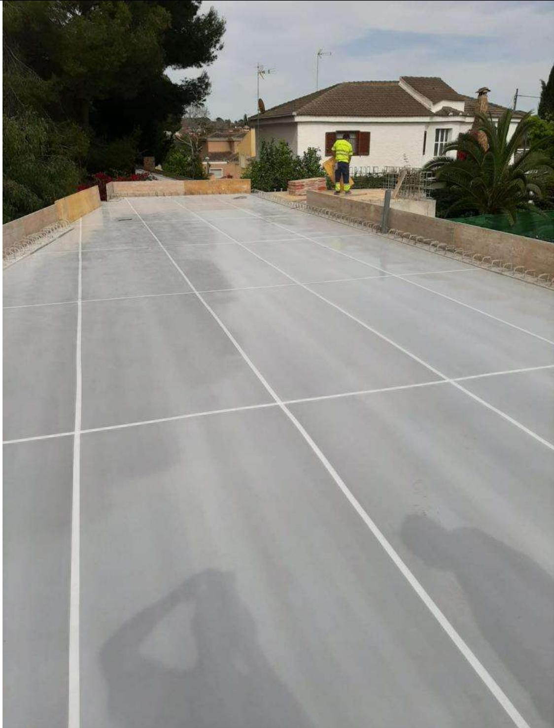
Figura 76: Uso de cintas y laminas; encofrado forjado garaje. 2020. Fuente propia
