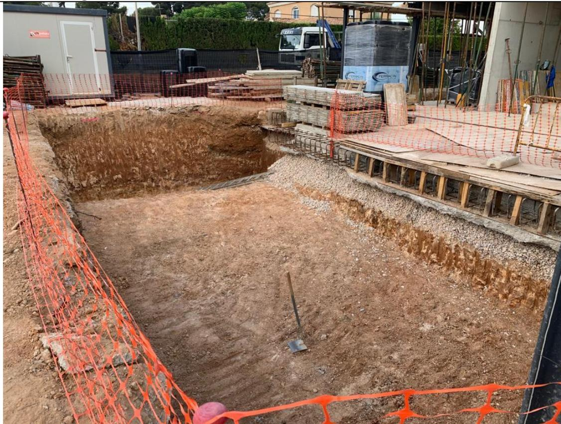
Figura 109: Vallado perimetral excavación. 2020. Fuente propia
