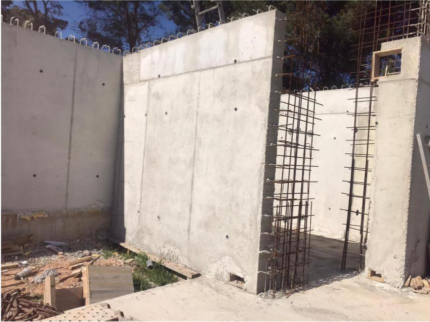
Figura 23: Muros desencofrados de bunker desde fuera. 2020. Fuente propia
