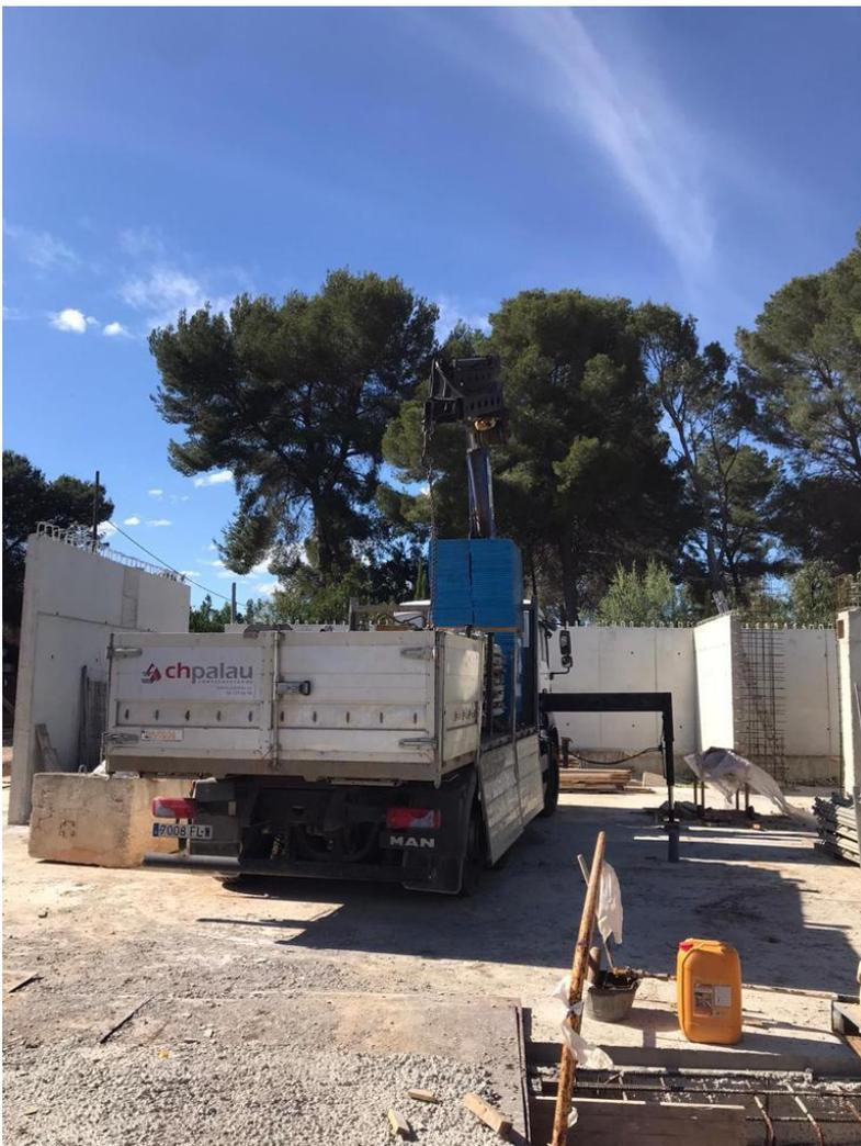
Figura 24: Camión grúa acopiando los nuevos encofrados. 2020. Fuente propia
