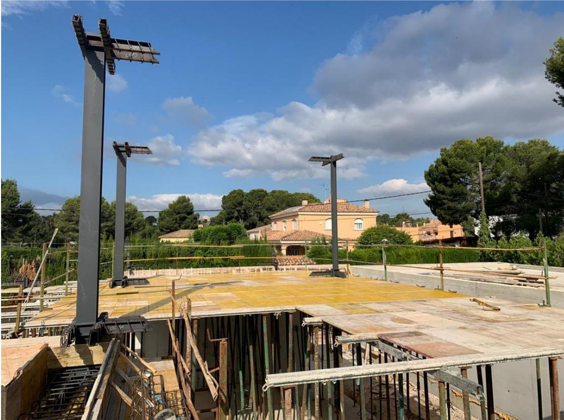
Figura 53: Encofrado de forjado superior de vivienda en planta baja a +4,08m. 2020. Fuente propia
