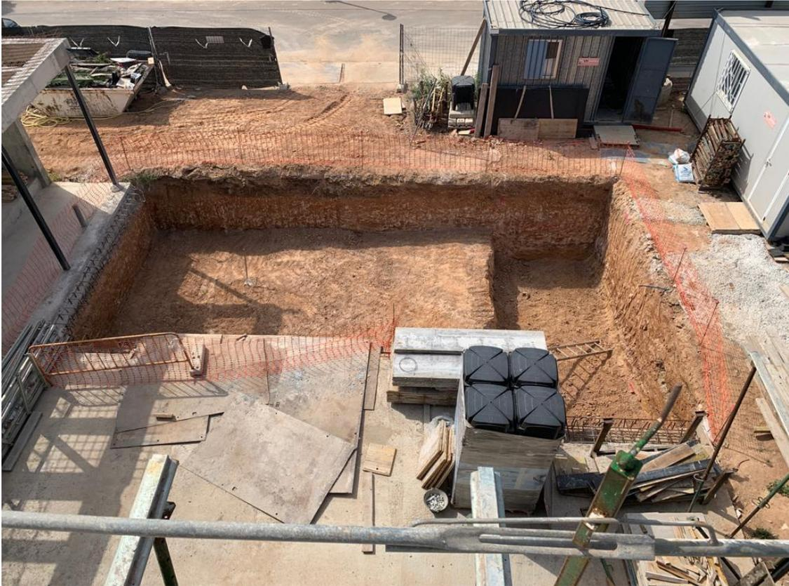
Figura 70: Excavado a cielo abierto de piscina e instalaciones. 2020. Fuente propia
