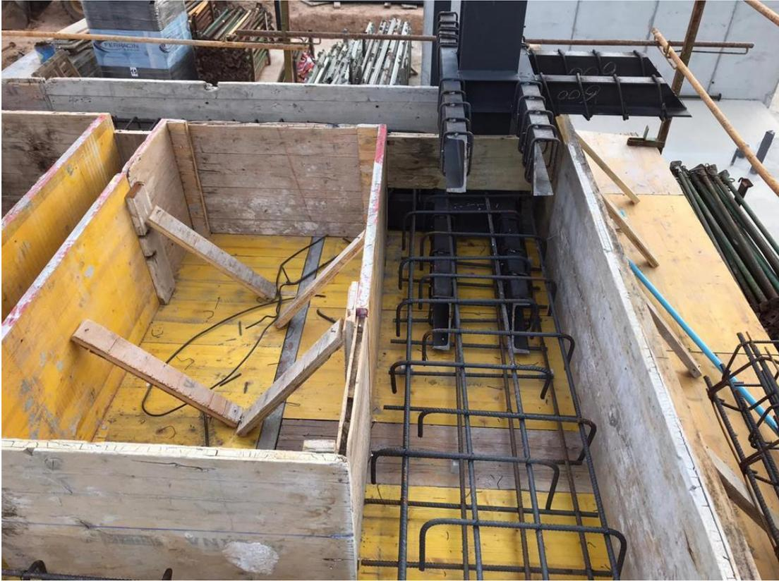
Figura 51: Encuentro armado de losa con crucetas UPN de pilares 2. 2020. Fuente propia
