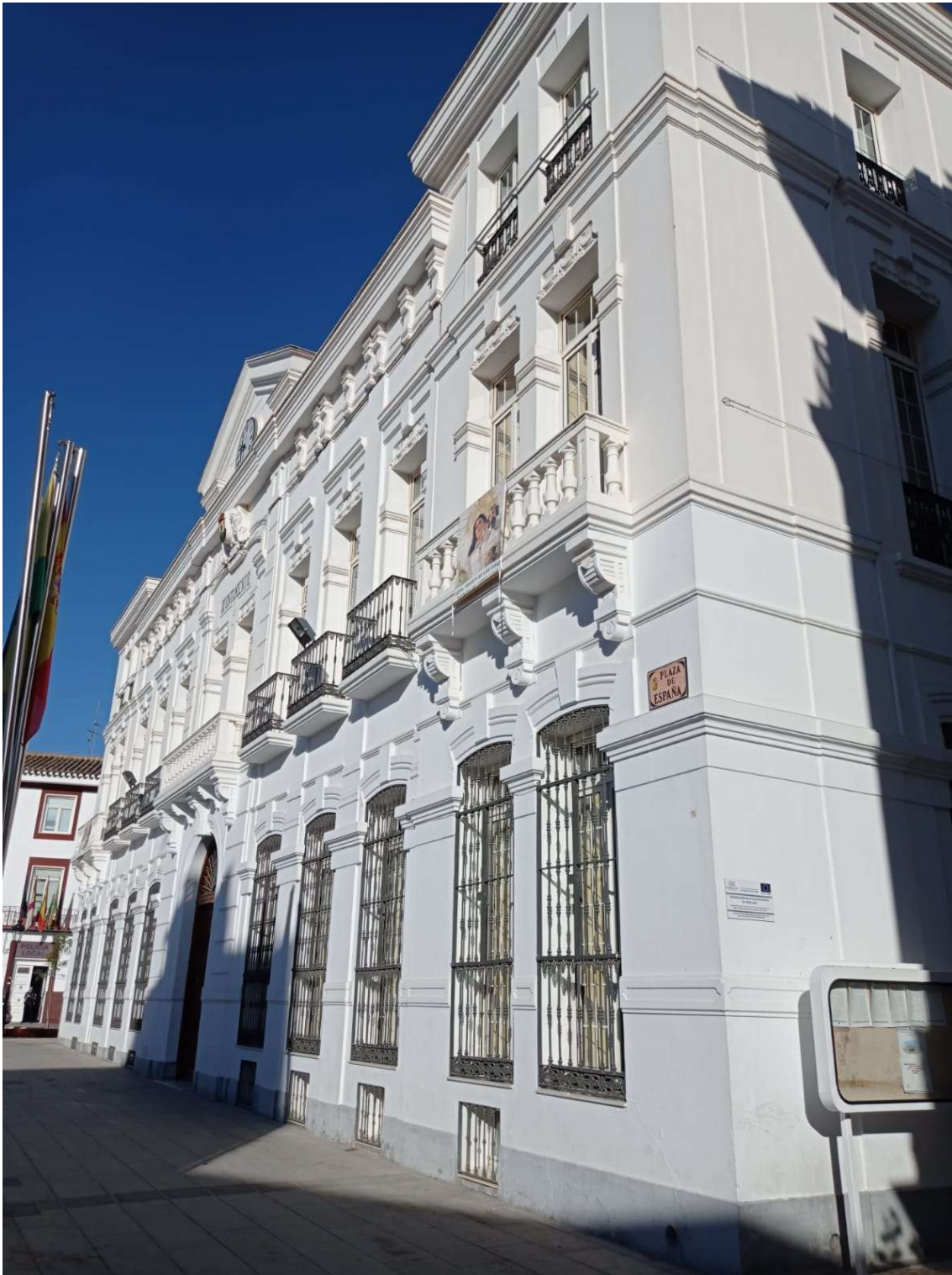
Imagen 7, Esquina de la fachada principal con la fachada derecha (Fuentes propios)
