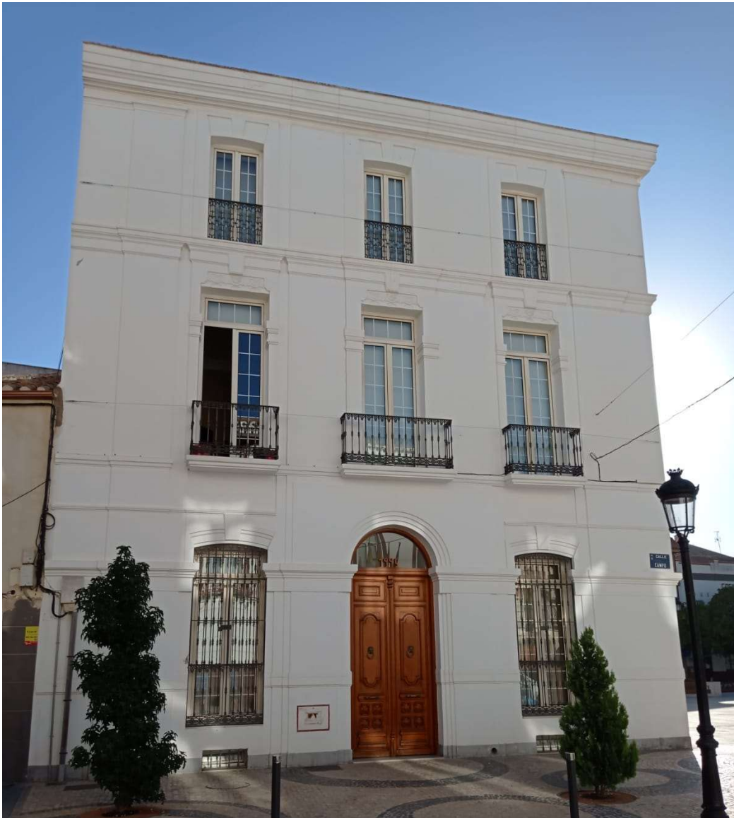
Imagen 4, Fachada Izquierda (Fuentes propios)
