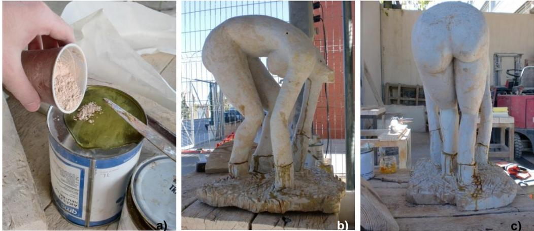
Figura 45. a) – c) proceso de mezcla de la resina y pegado de la figura.
