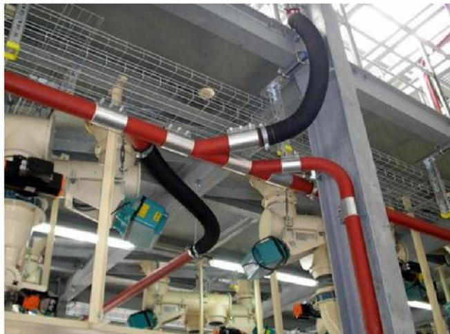
Figura 7 Ejemplo de instalación de conductos de aspiración centralizada por la empresa VAC-U-MAX donde se aprecia un conducto central donde convergen el resto de los conductos.
