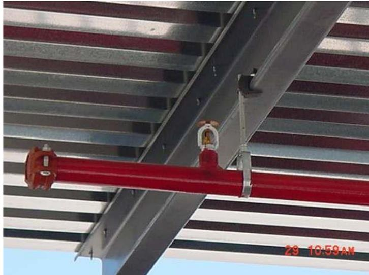
Figura 57 Ejemplo del soporte de tubería tipo anillo.
