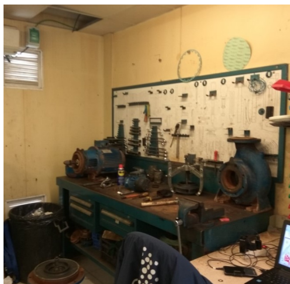
Ilustración 21 –Banco de Trabajo del Taller de la empresa mantenedora de climatización y ACS.
