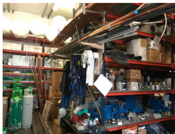
Ilustración 18: Almacén empleado por la empresa mantenedora de instalaciones climáticas y ACS.
