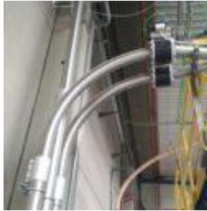
Imagen 5. Ejemplo de curvas para una línea de transporte neumático.
