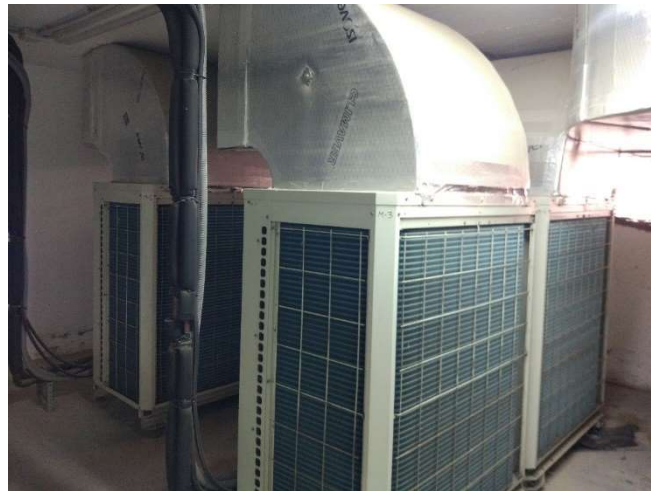
Ilustración 10: Unidades exteriores del sistema VRV
