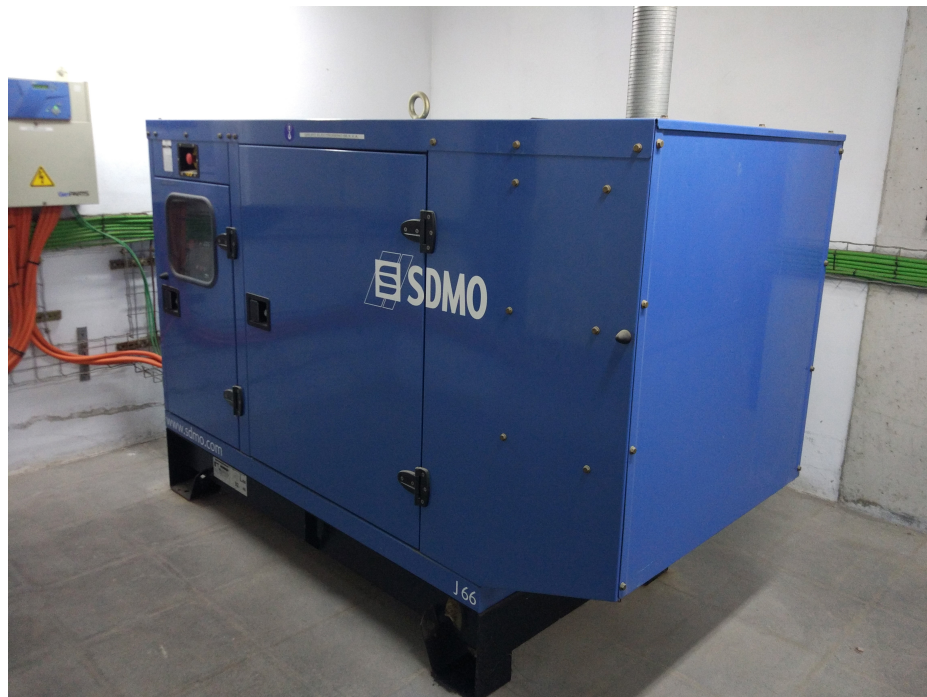
Ilustración 14: Grupo Electrónico SDMO
