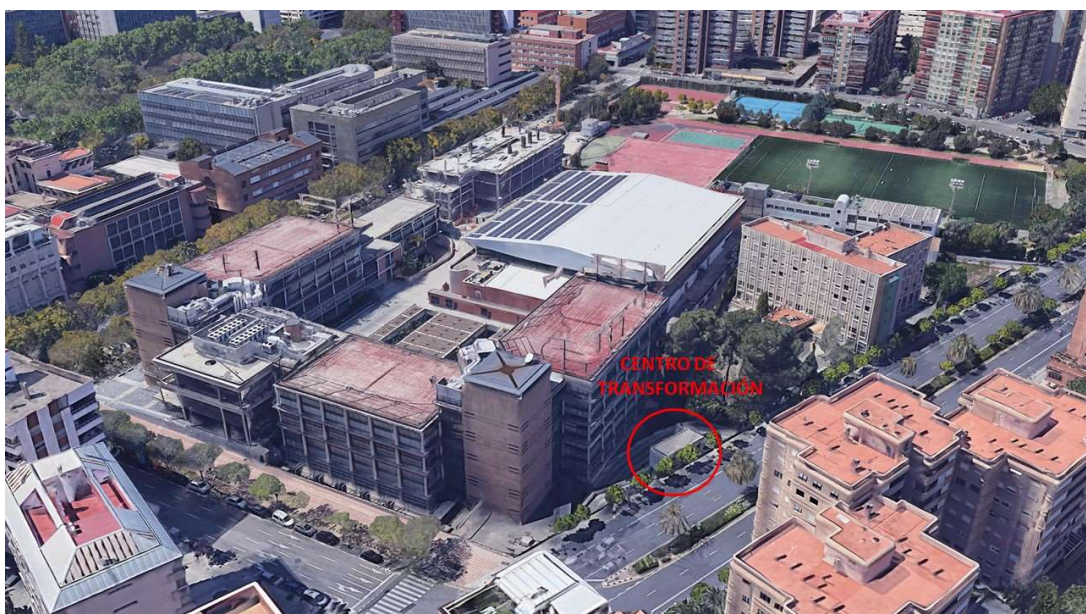
Ilustración 16: Centro de Transformación
