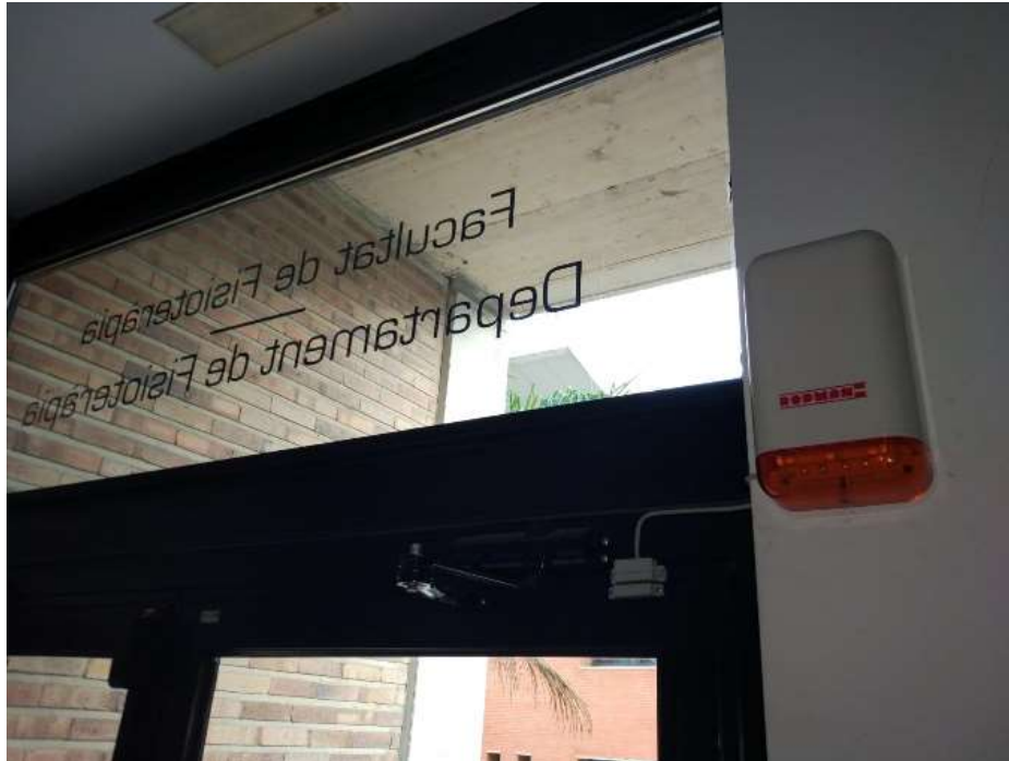
Ilustración 24: sistema anti intrusión
