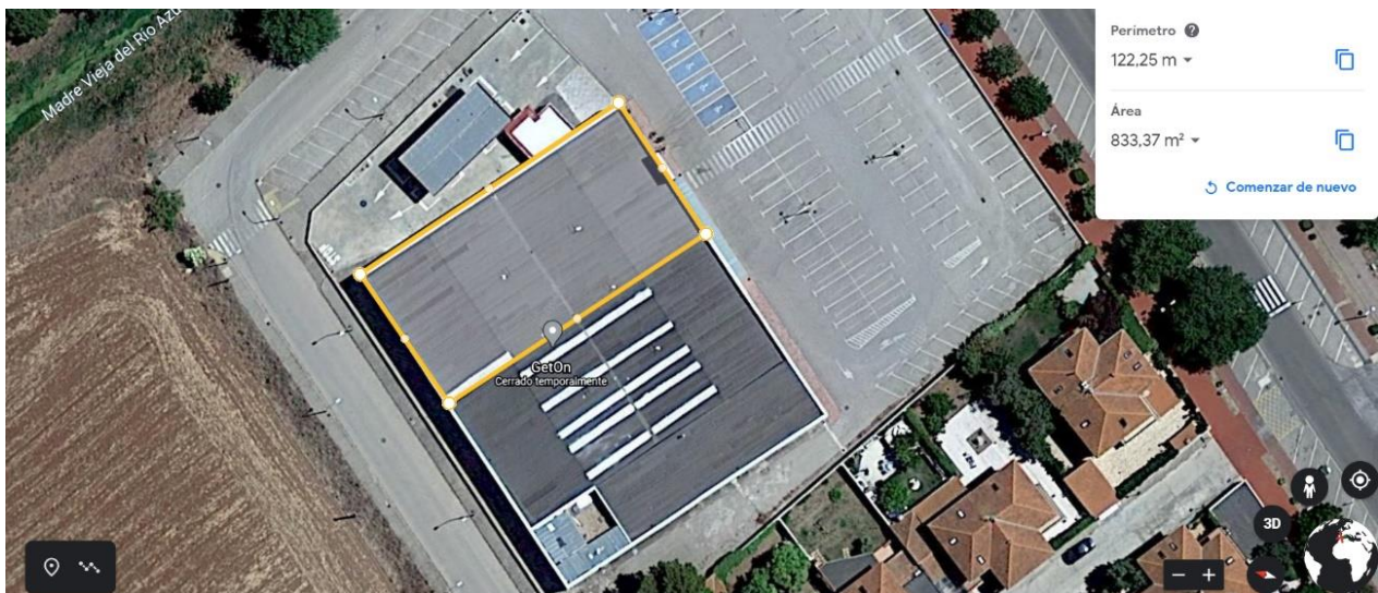
Figura 1: Superficie de la instalación fotovoltaica
