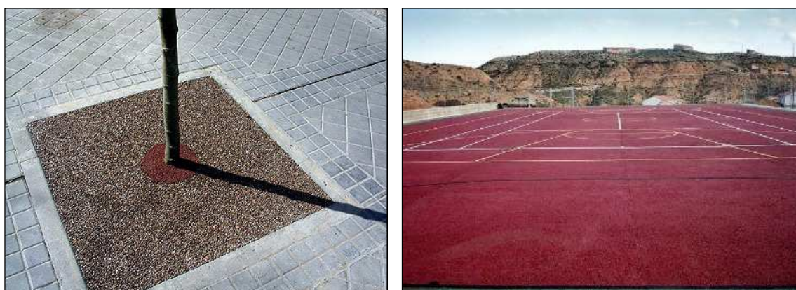
Figura II. 10. Pavimentos permeables ejecutados en alcorque (izquierda) y en instalación deportiva (derecha).
