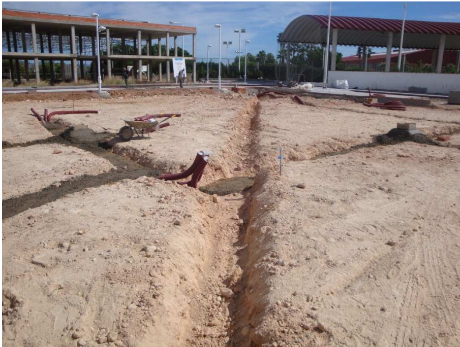
Figura III. 5. Construcción del dren inferior.
