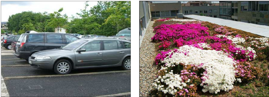
Figura I. 18. Aparcamiento ejecutado con pavimento permeable (izquierda) y cubierta ajardinada (derecha).
