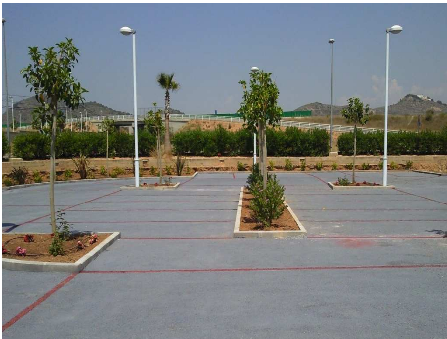
Figura III. 10. Aspecto final del aparcamiento ejecutado con hormigón poroso.
