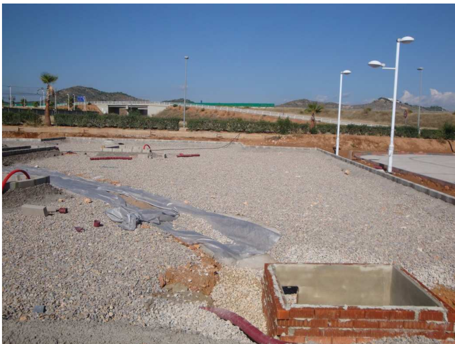
Figura III. 6. Vertido de la fina capa de gravas (ligeramente compactadas) sobre el terreno natural, y terminación del dren inferior.
