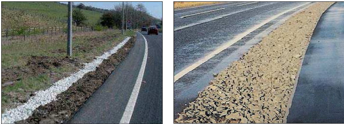
Figura I. 21. Drenes filtrantes paralelos a viales.
