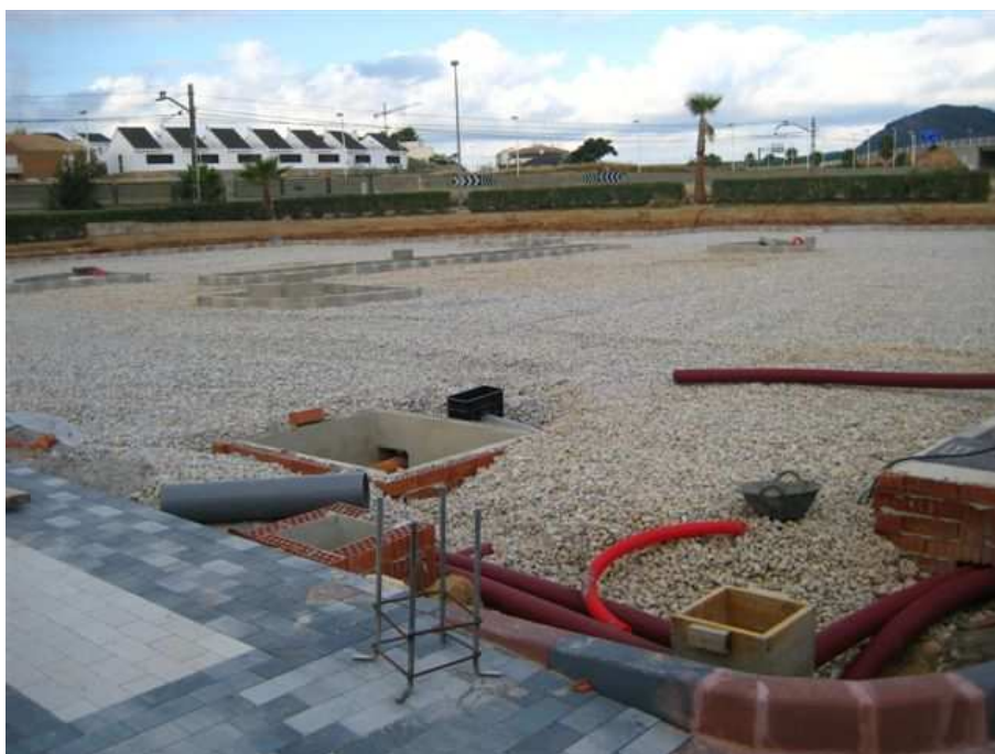
Figura III. 8. Colocación de sub-base granular sobre geotextil.
