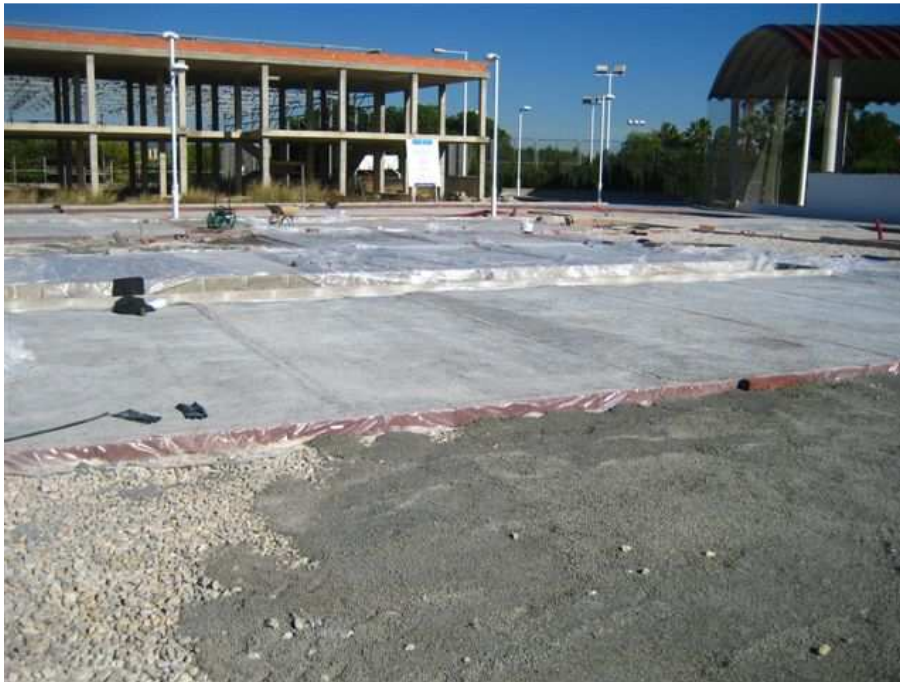
Figura III. 9. Vertido del hormigón poroso sobre la sub-base.
