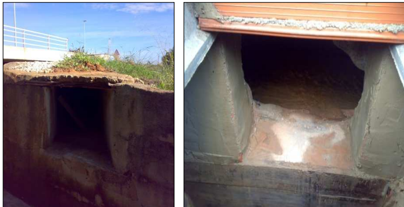
Figura I. 13. Aliviaderos en la red de saneamiento municipal de Alginet (Valencia).
