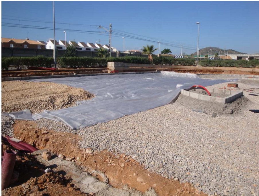
Figura III. 7. Extensión del geotextil sobre la capa de gravas compactadas.
