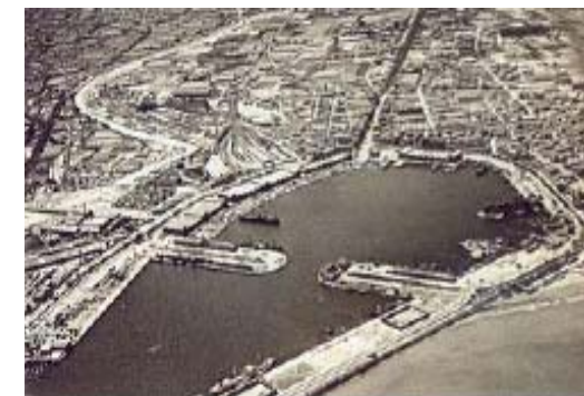
1. Estado del Puerto de Valencia y sus alrededores en 1946.
