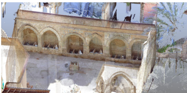
Figura 28. Nube de puntos del escaneado láser 3D tras la restauración de los arcosolios. Fuente: elaboración propia.
