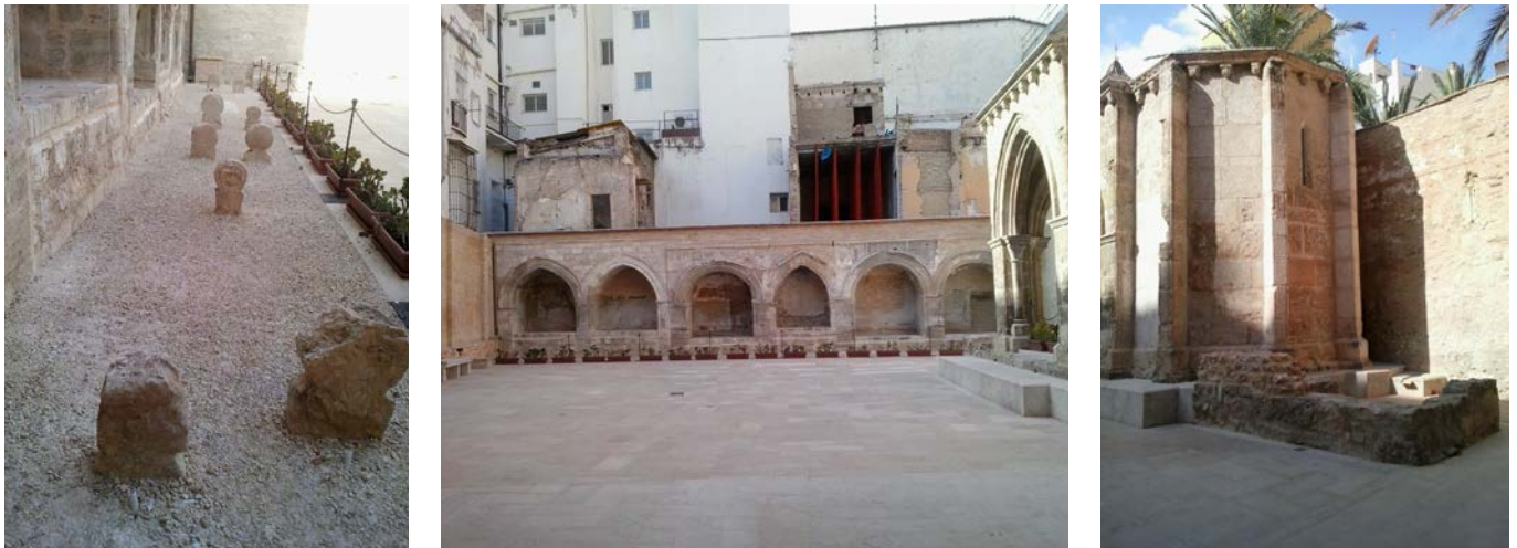
Figura 29. Tres vistas del patio sur tras la intervención. Fuente: elaboración propia.
