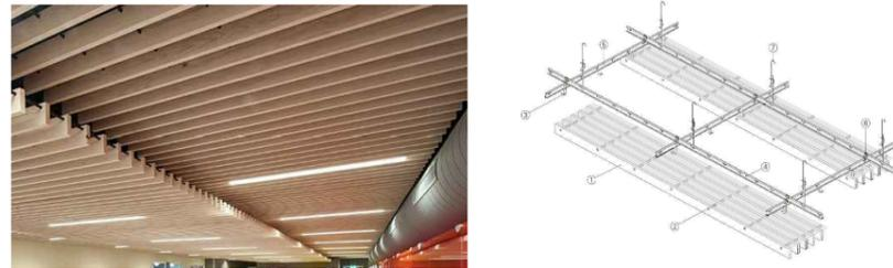
**FALSO TECHO GENERAL** Como solución del falso techo general de todo el espacio interior nos decantamos por un sistema lineal de bandas metálicas en color blanco. Buscamos que este plano de techo refleje la luz, no se muestre protagonista y permita ubicar en sus bandas las líneas de luminarias, rejillas de difusión de aire etc de manera ordenada en los espacios de naturaleza igualmente lineal.
