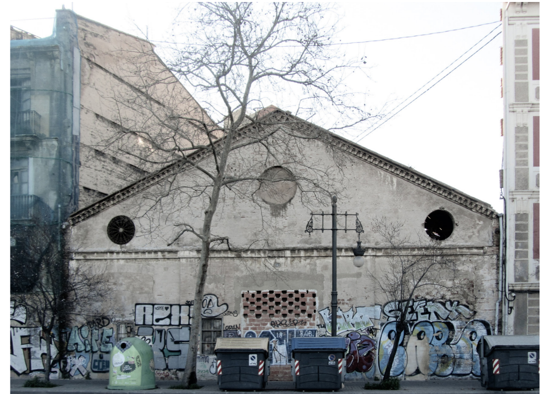
Imagen 54. Fachada frontal Fundición, Guillem de Castro, 142
