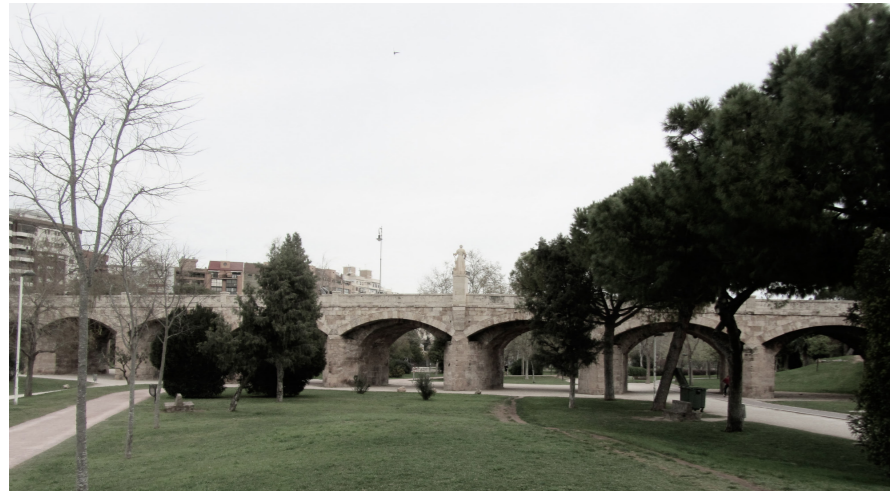
Imagen 5. Vista del Pont de Sant Josep desde el Antiguo cauce
