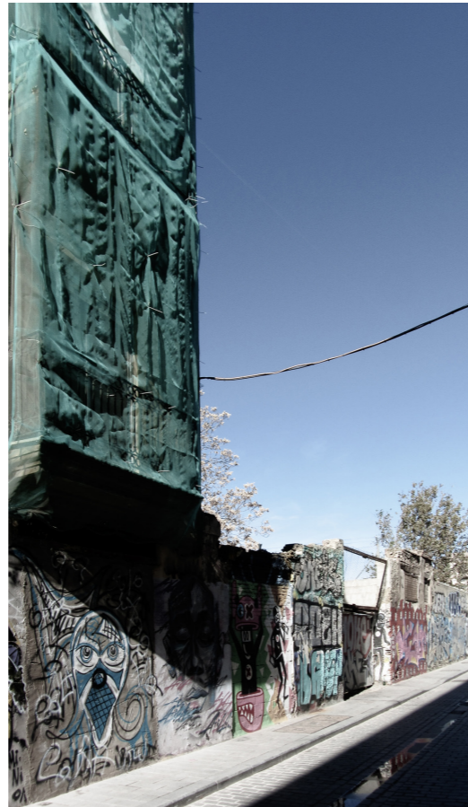
Imagen 15. Edificios abandonados de la C/Lliria
