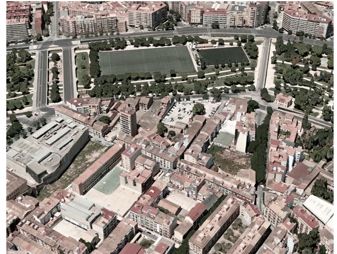
Imagen 55. Vista aérea del área de intervención
