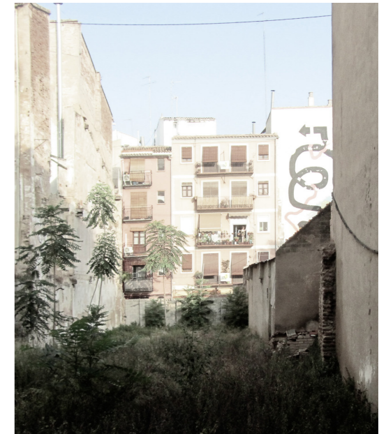
Imagen 4. Solar C/ Salinas (muralla árabe)
