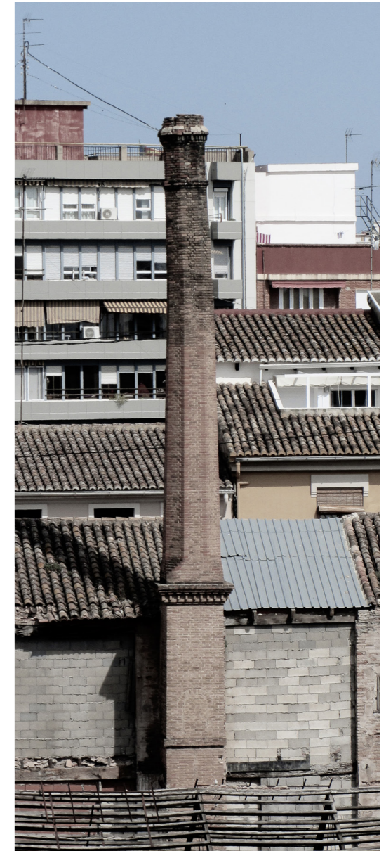
Imagen 52. Detalle de la chimenea
