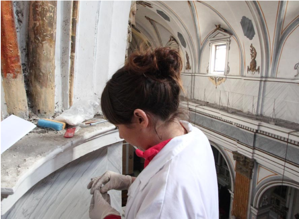
Fig 53. Elaboración del empaco con agua destilada.
