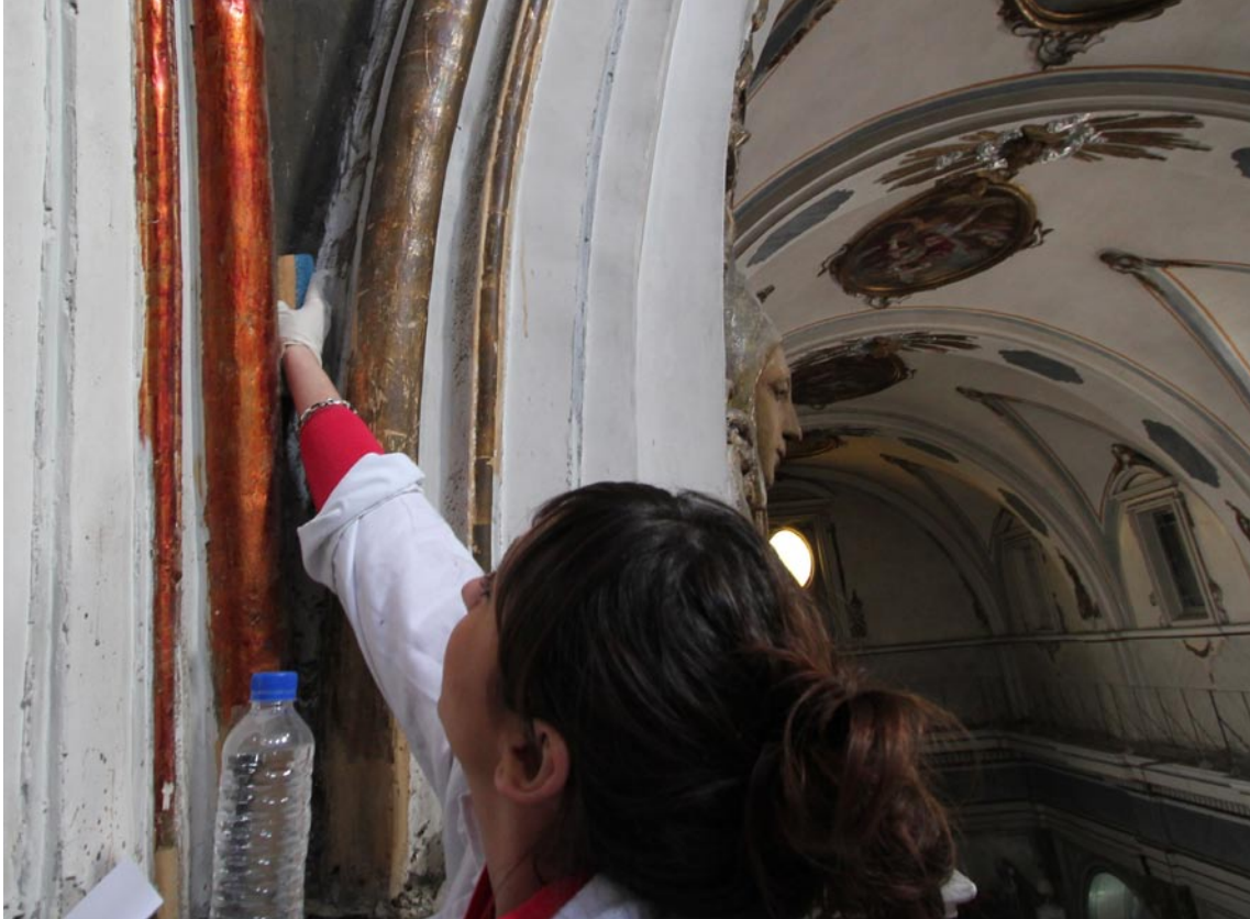
Fig 57. Limpieza mecánica con goma wishab.
