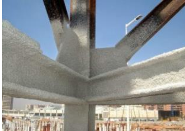
Ilustración 46.- Acabado superficial con capa de mortero de vermiculita (FUENTE: confort home)
