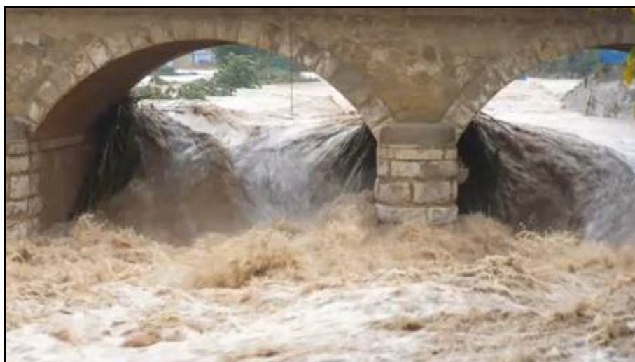
Fotografía 3. Detalle de las pilas en la Crecida en el Puente de Beniarbieg
