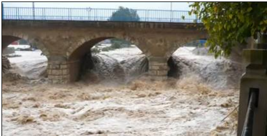
Fotografía 2. Vista 2 de la Crecida en el Puente de Beniarbieg
