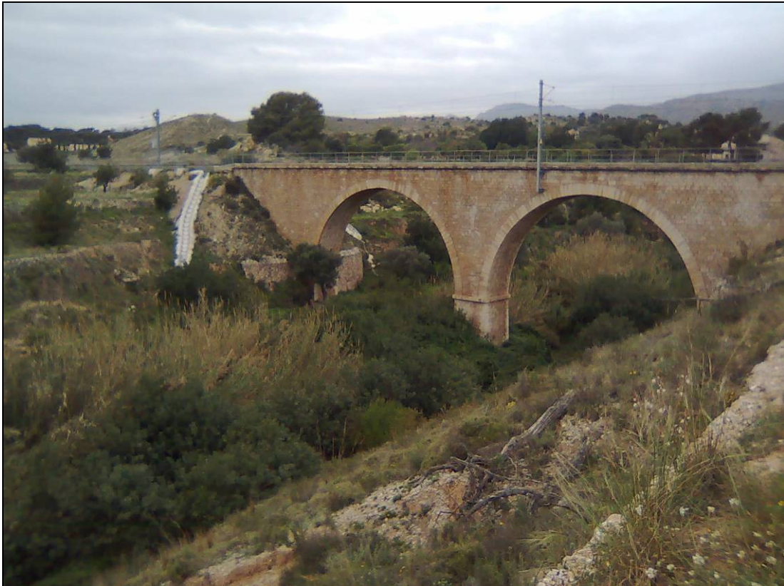
Fotografía 7. Puente sobre el Barranco Torres visto desde aguas arriba y aguas abajo
