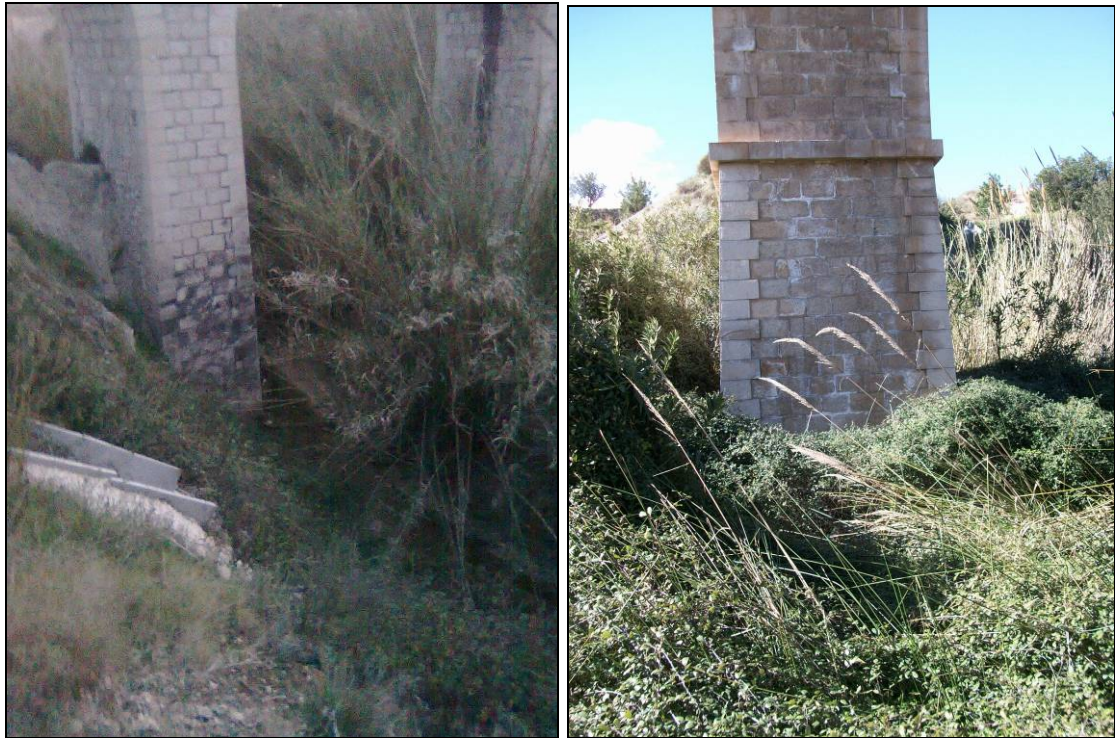
Fotografía 9. Detalle de pila del puente
