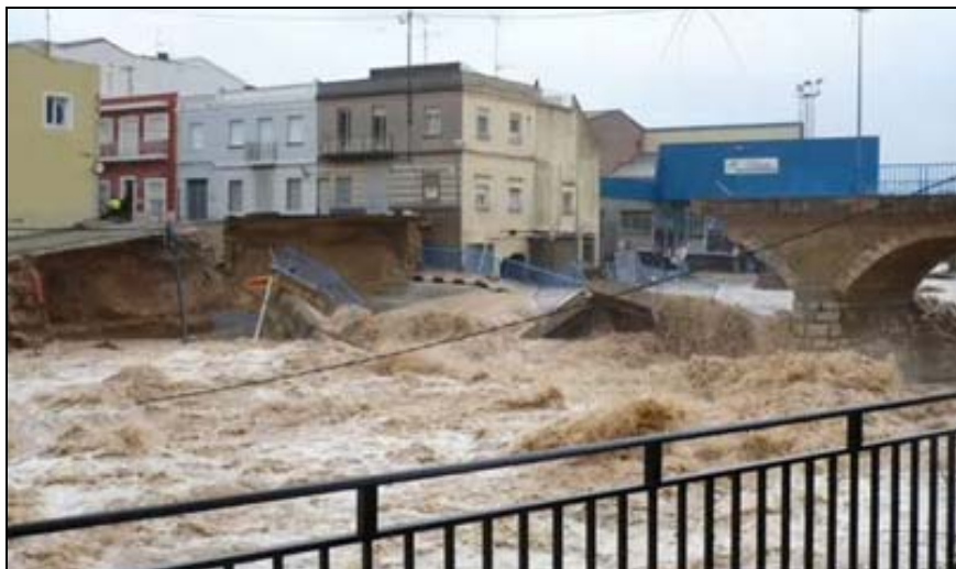
Fotografía 4. Vista 1 de la Crecida en el Puente de Beniariieg hundido
