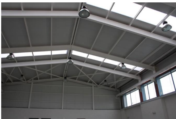
Ilustración 10. Panel sándwich y lucernarios (Fuente: catálogo MASTERPANEL)
