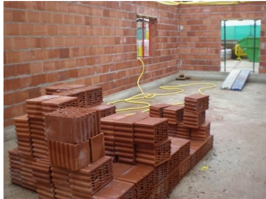
Ilustración 9. Bloques termoarcilla (Fuente: www.elmaestrodecasas.blogspot.com )
