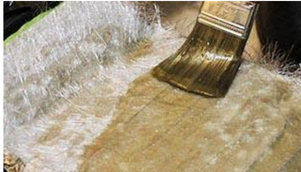
Fig 6.11 Aplicación Resina Epoxi
