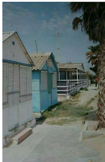
Fig. 20. Casitas La Patacona.
