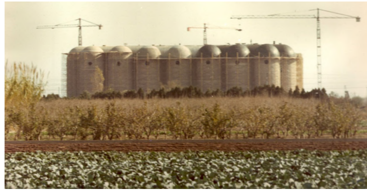
Fig. 26. Vista desde la huerta durante su construcción. Fuente: Juan Antonio Mompó.
