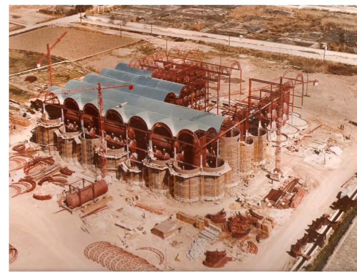
Fig. 29. Vista general durante su construcción. Fuente: Juan Antonio Mompó.
