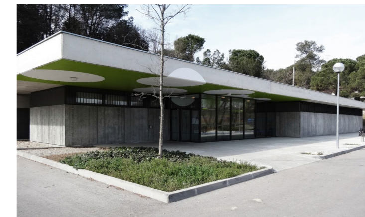
Fig. 6. Vista del acceso. Fuente: PMMT.
