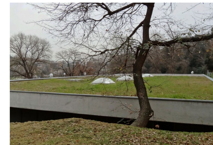
Fig. 7. Vista de la cubierta. Fuente: PMMT.
