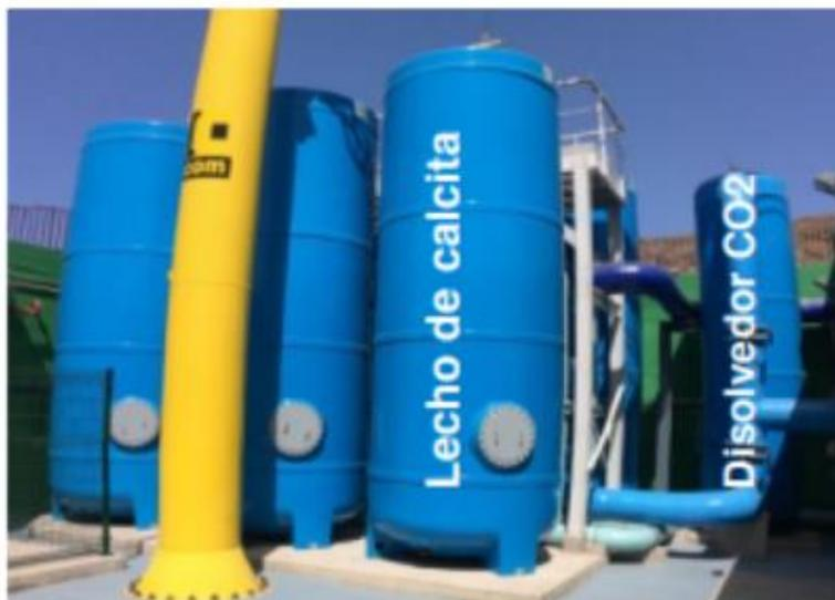
Figura 20. Lecho de calcita con disolvente de  $\text{CO}_2$  [11].
