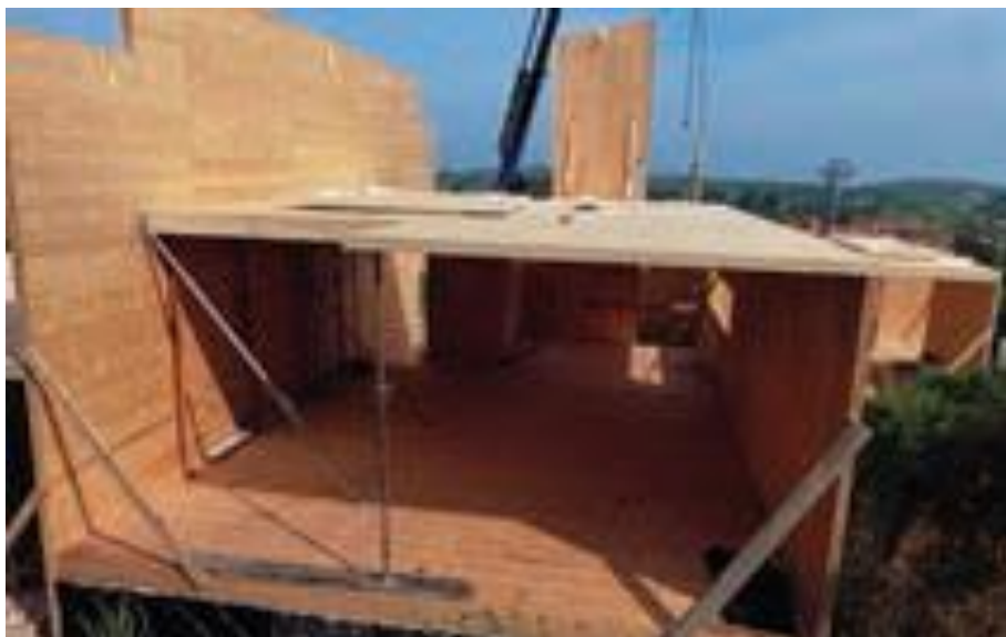
Ilustración 7. Construcción con paneles estructurales
