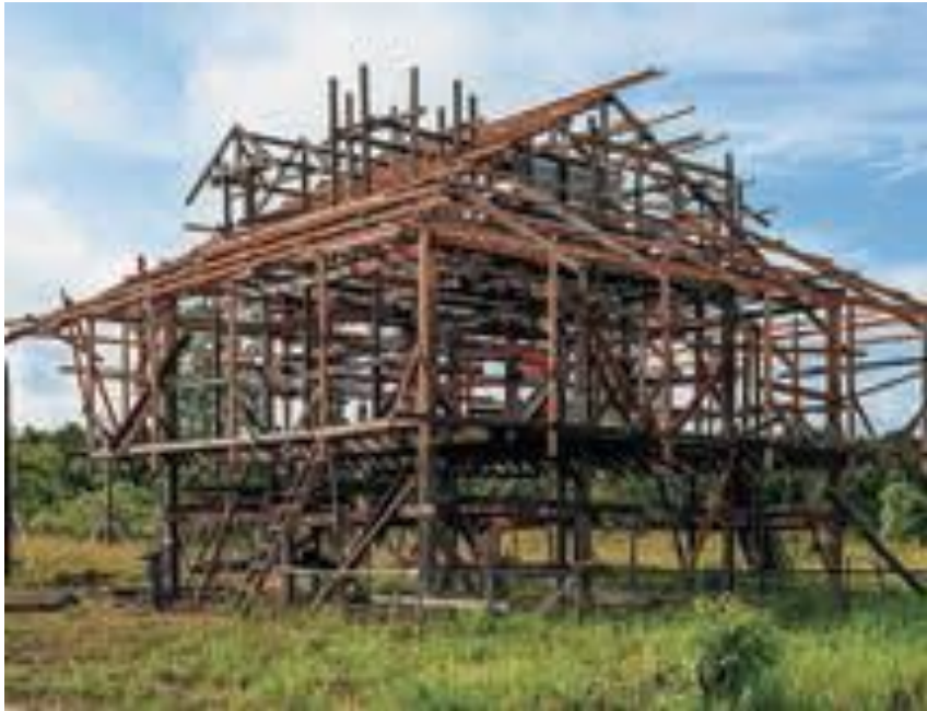
Ilustración 5. Edificación por entramado pesado de la época migratoria europea hacia Norteamérica
