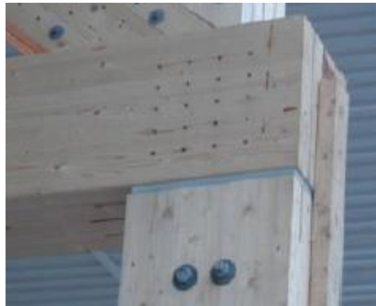
Figura 23. Unión pilar-viga
