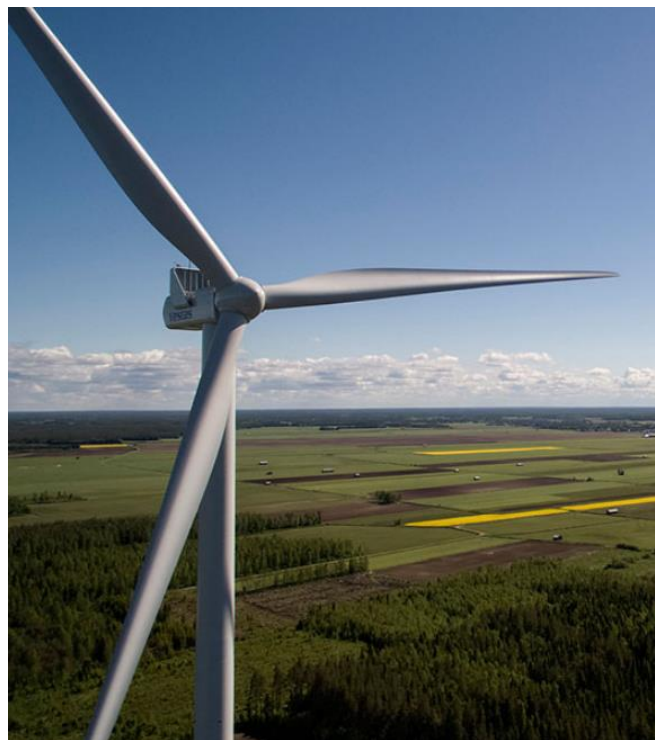
Figura 24. Aerogenerador Vestas V136 (3,45 MW).
