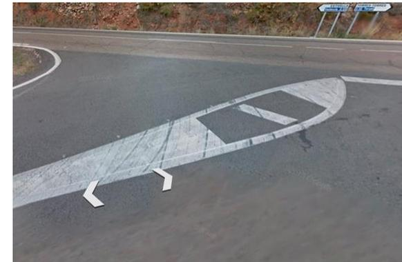
Figura 18 Señalización horizontal Isleta de separación
