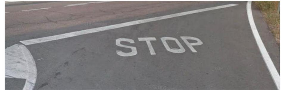
Figura 17 Señalización horizontal Línea de detención
