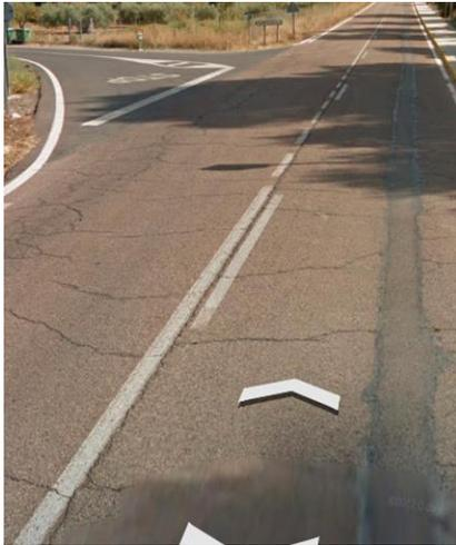
Figura 19 Señalización horizontal, Líneas discontinuas
