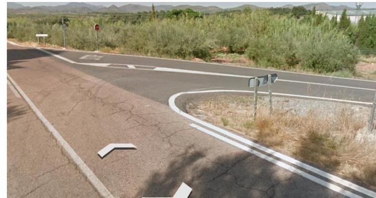
Figura 29 Foto intersección sin sistemas de contención
