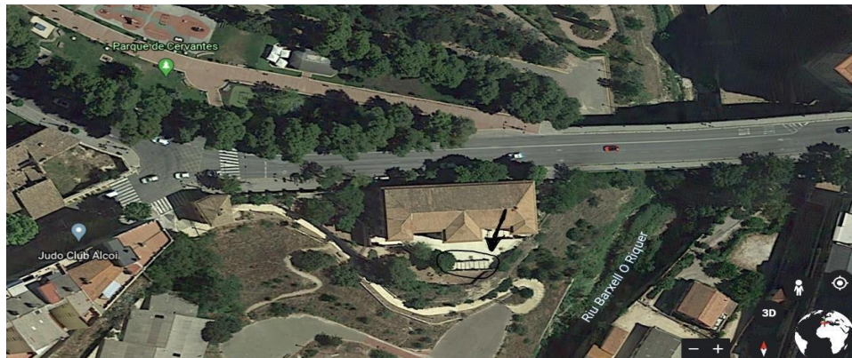
Figura 2. Situación real de la estructura en Centro Cervantes Joven, Alcoi.
