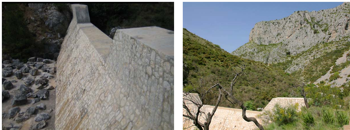
Fotos 17 y 18. Dique (a cota 520m.) en el bco. de Malafí, en el T.M. de Tollos
