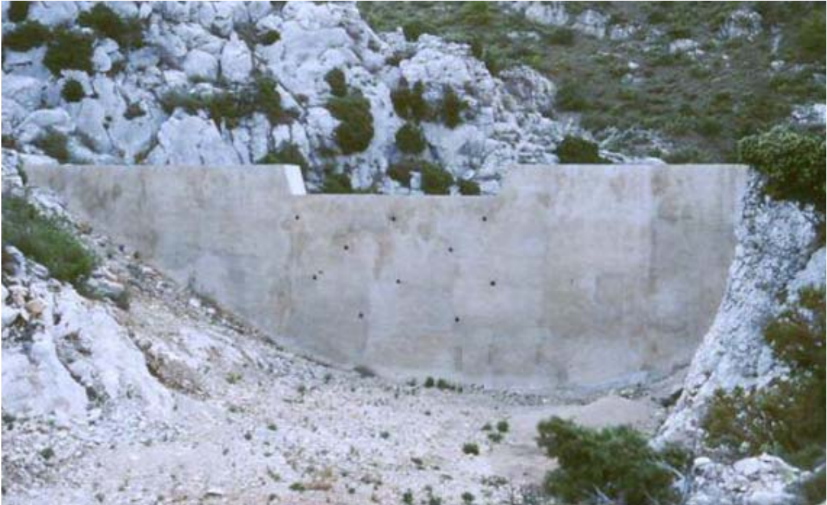
Foto 13. Dique (desde aguas arriba) en el río Castell, en T.M. de Castell de Castells
