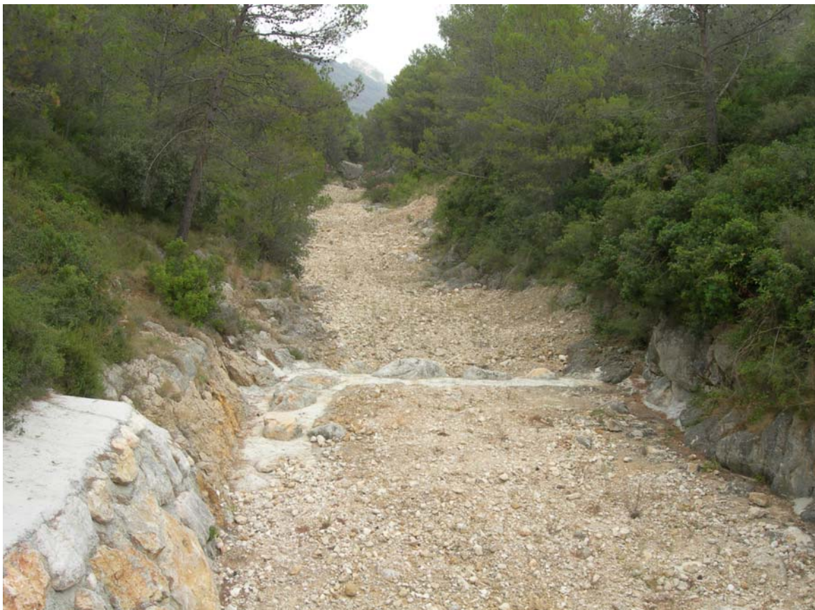
Foto 22. Río Jalón, aguas abajo del dique anterior
