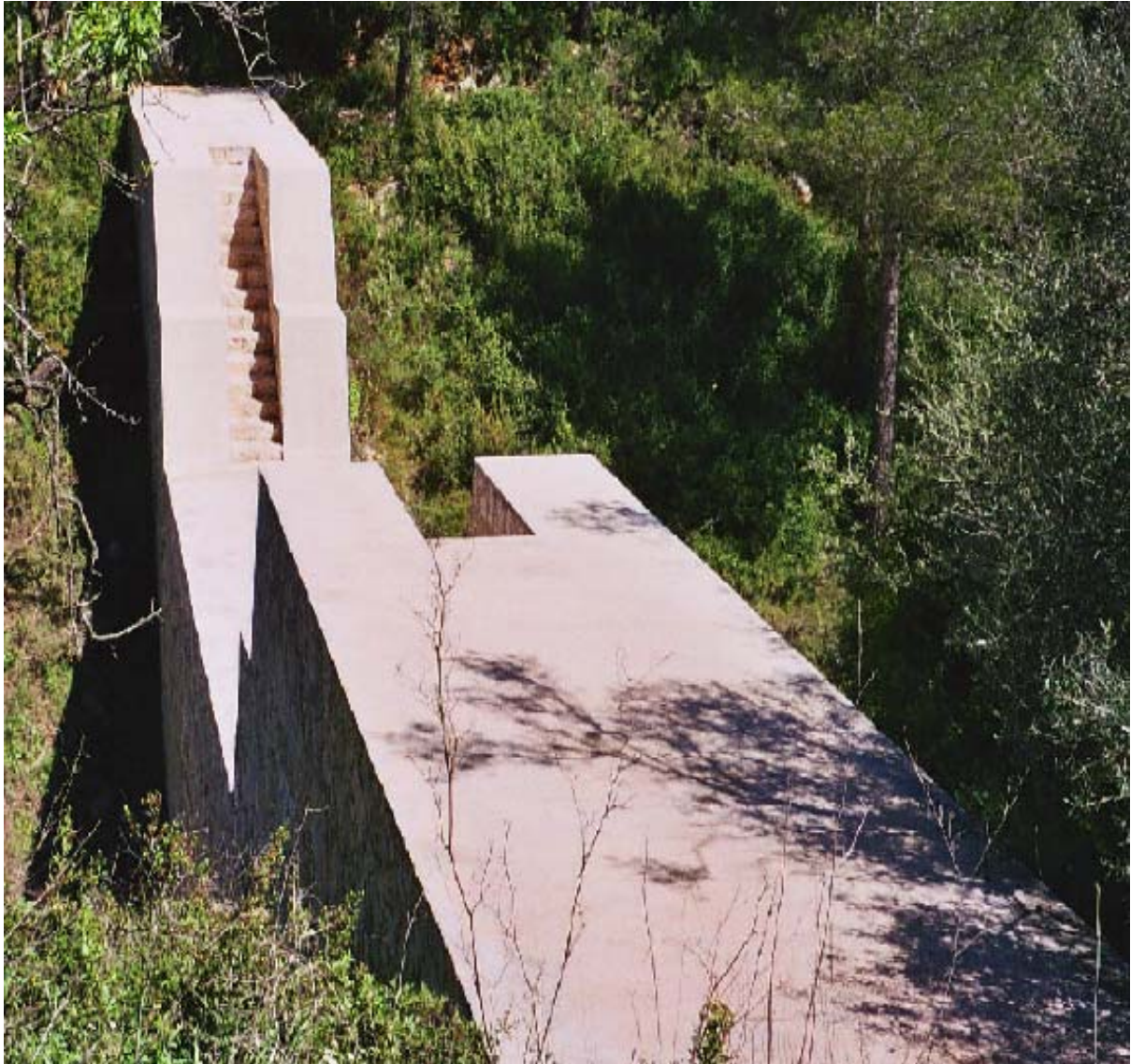
Foto 20. Dique en el río Jalón, a su paso por el T.M de la Vall de Laguar
