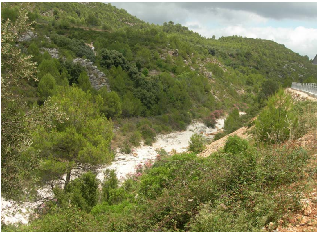
Foto 37. Emplazamiento propuesto para la hidrotecnia nº.1 en el río Jalón, entre la confluencia de los bcos. Castell y Malafí, y el dique ya construido en Vall de Laguar (aguas arriba de este)
