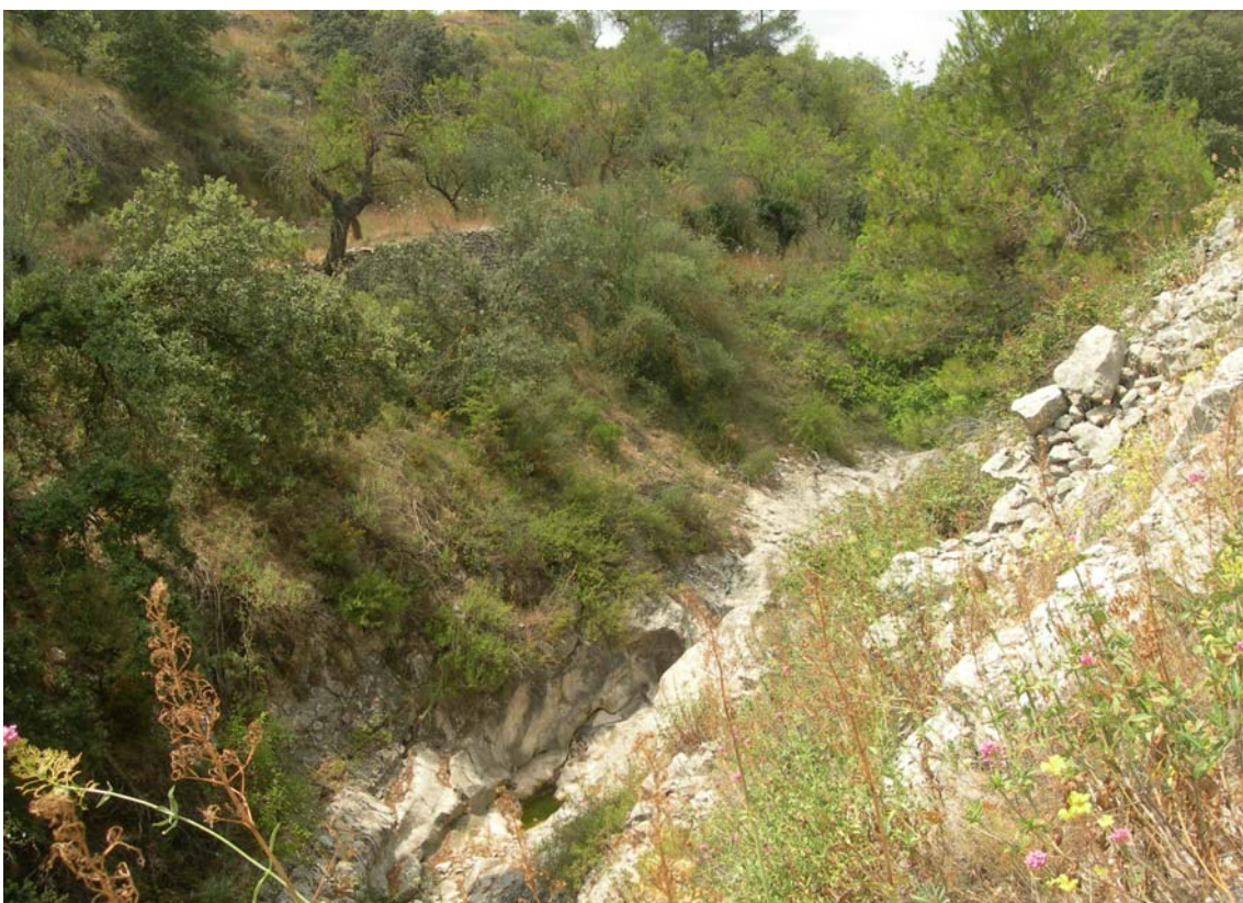
Foto 34. Emplazamiento propuesto para la hidrotecnia nº.2 en el barranco del río Castell
