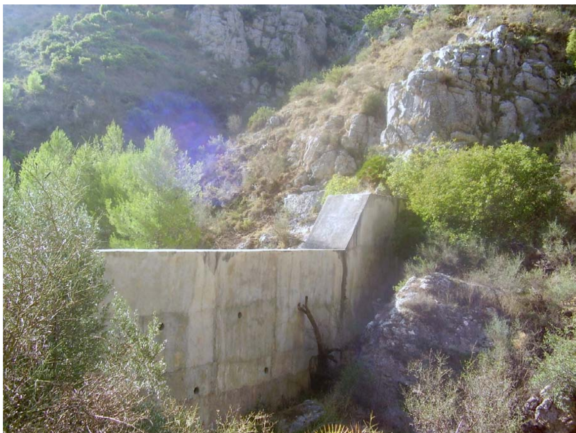
Foto 19. Dique (a cota 460m.) en el barranco de Malafí, en T.M. de Castell de Castells
