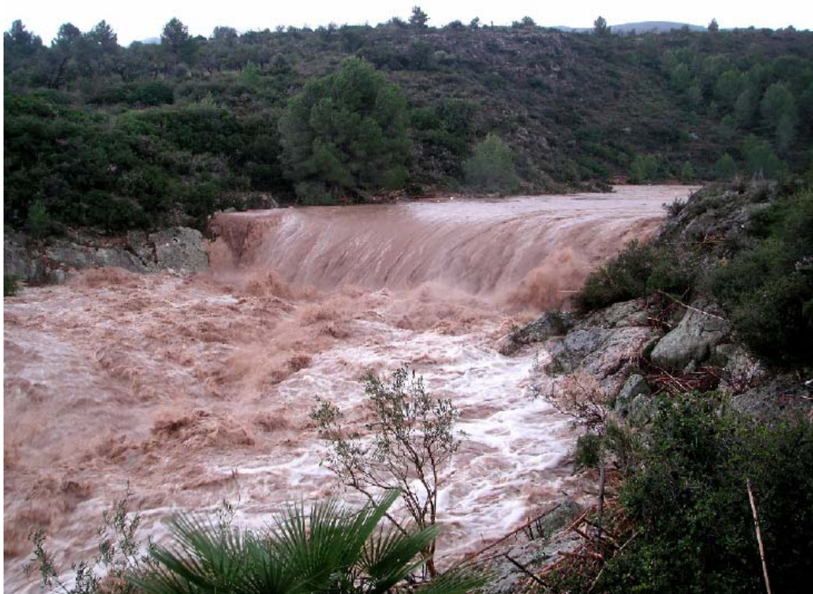
Foto 24. Dique de Gata de Gorgos, en el episodio de lluvias torrenciales del 12/10/2007
