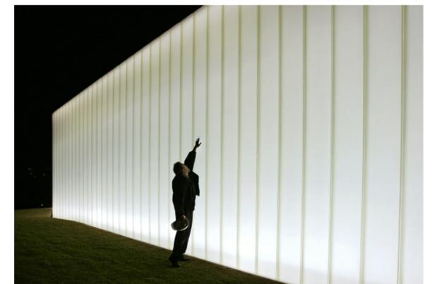
Esta piel consiste en dos piezas de U-glass en forma de U que poseen una resistencia estructural suficiente como para liberarla de montantes, mientras que los travesaños metálicos de la marca Technal se disponen en los frentes de los forjados o en perfiles tubulares metálicos horizontales en las dobles alturas, dimensionados para dotar de rigidez al conjunto.
