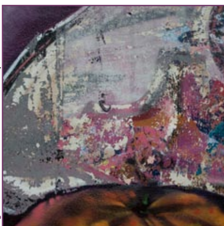
Fig. 15. Detalle de uno de los arranques fallidos
