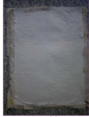
Tras Consolidación y aplicación de telas. Reverso
