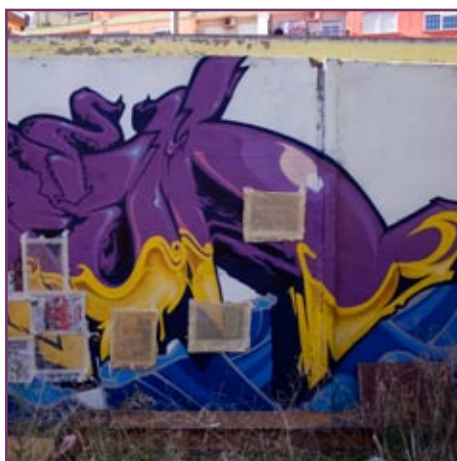
Fig. 33. Detalle en pieza Miedo12, telas aplicadas
