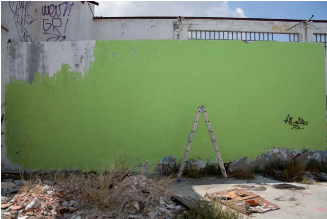
Primero. Aplicación del 'Blanqueo' (capa de pintura plástica como imprimación)
