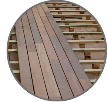
Los recorridos **exteriores** que se encuentran en las partes traseras de las viviendas unifamiliares se desarrollan mediante un suelo técnico elevado de madera, manteniendo una distancia entre el pavimento natural y la madera.
