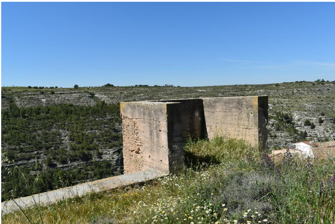
Imagen 27. Tramo Sur. Torre F y coronación lienzo 9. Fuente: Autora.
