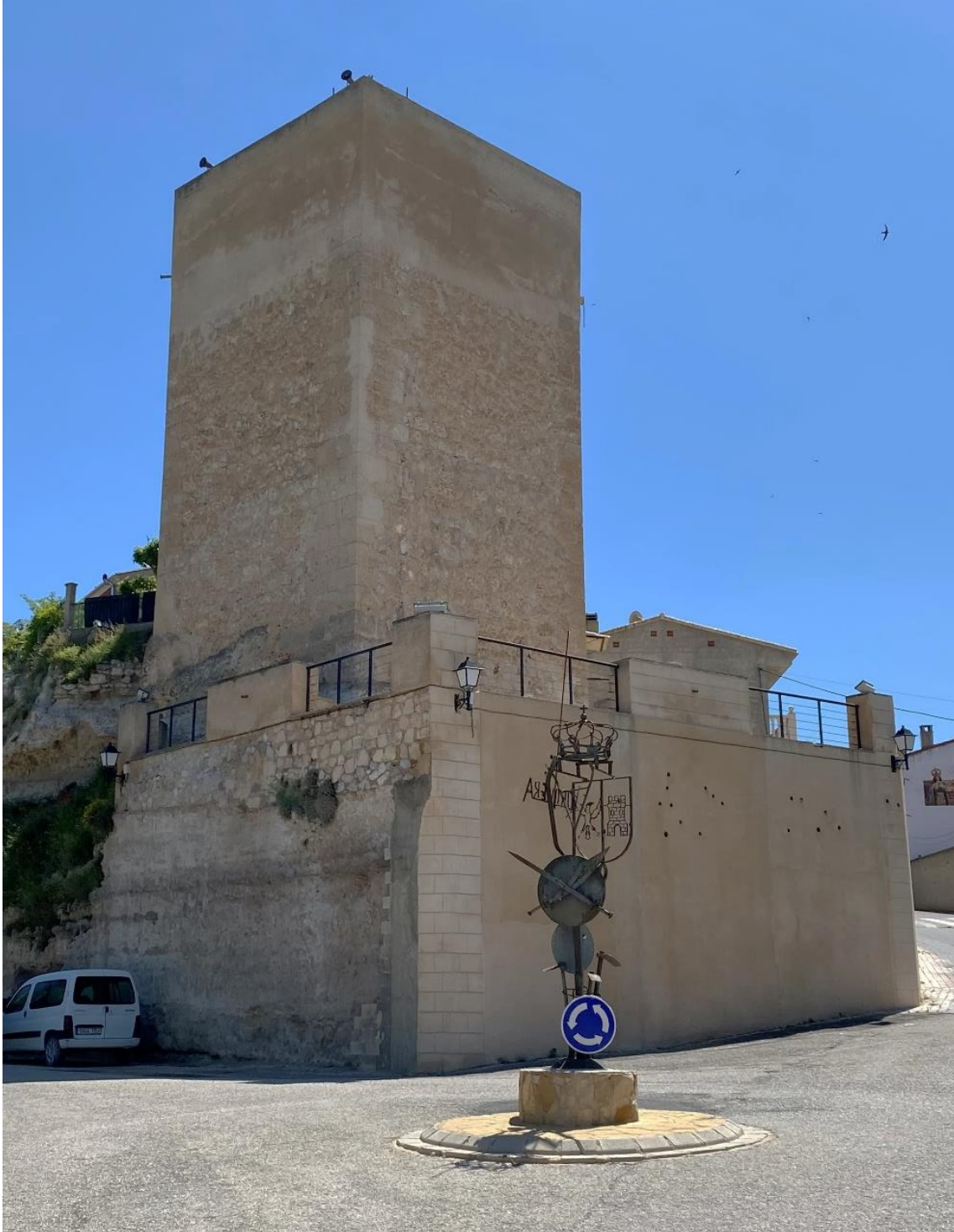
Imagen 10. Torre Blanca. Fuente: Autora.
