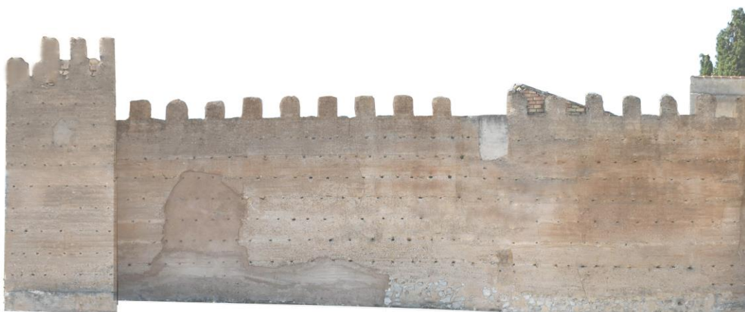
Imagen 115. Alzado restaurado, torre A y lienzo 1. Fuente: Autora.
