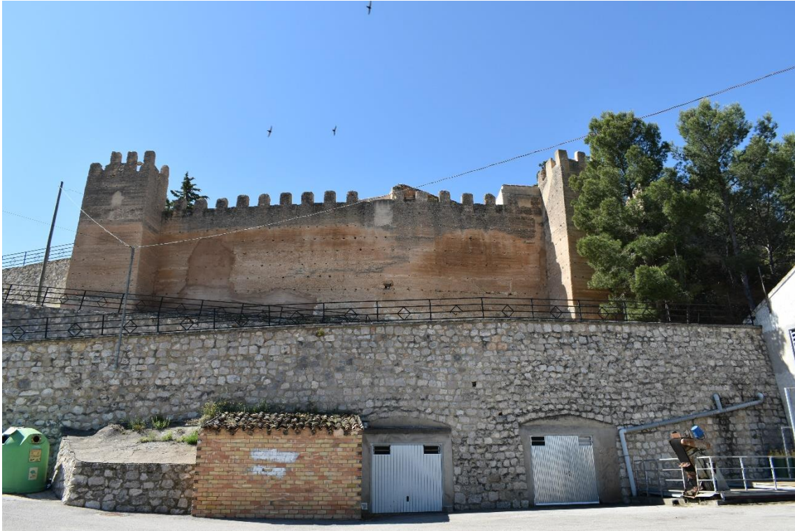
Imagen 15. Tramo Norte. Torre A, lienzo 1 y torre B. Fuente: Autora.
