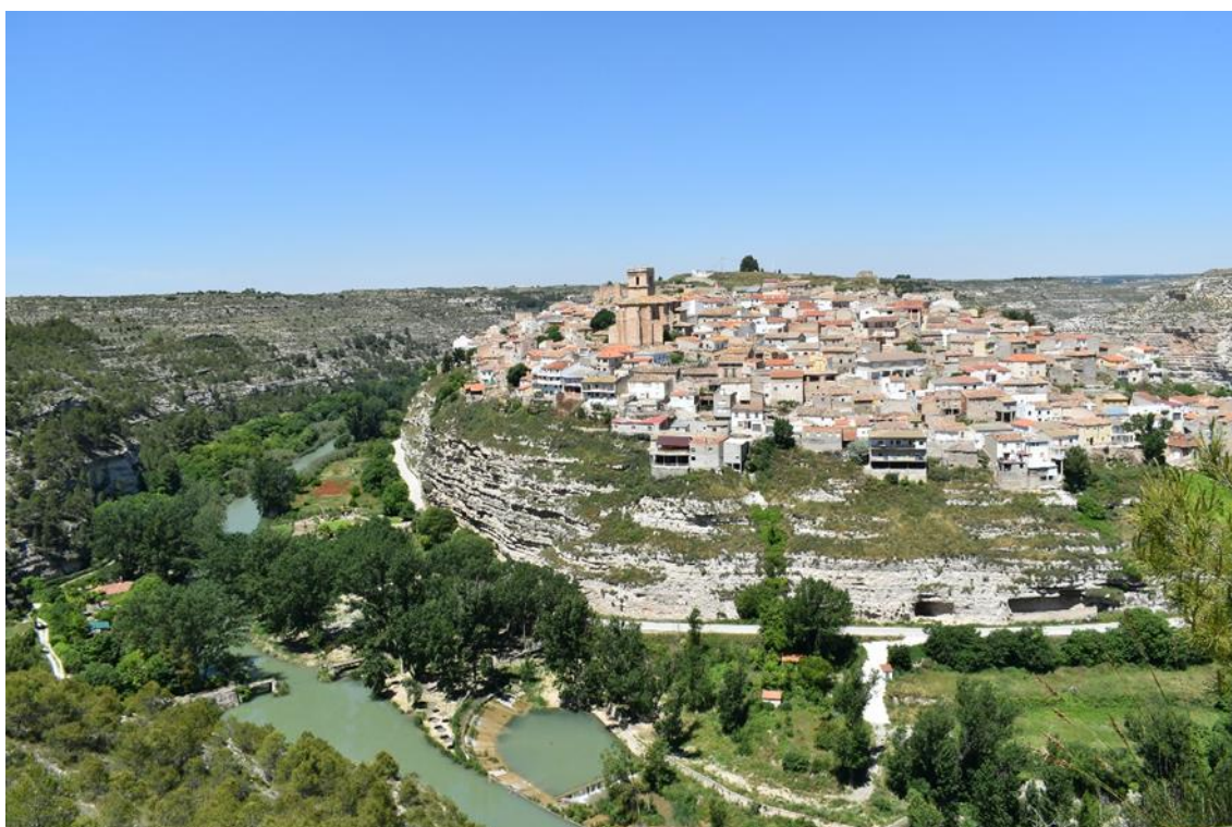
Imagen 4. Vista general Este de Jorquera. Fuente: Autora.
