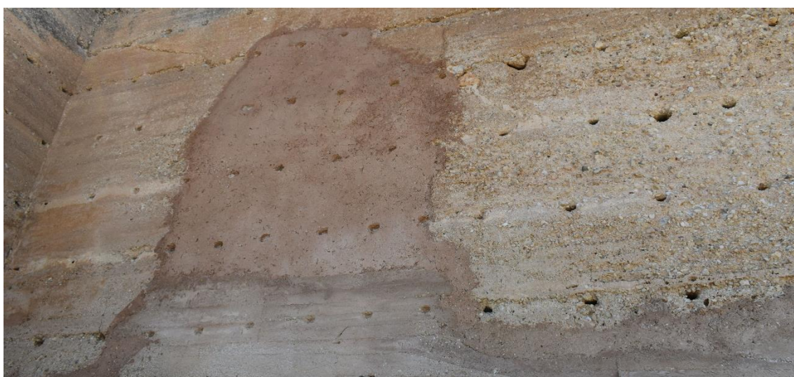
Imagen 60. Detalle 1.3. Sellado de perforaciones, previa limpieza, cepillado y picado lienzo 1. Fuente: Autora.
