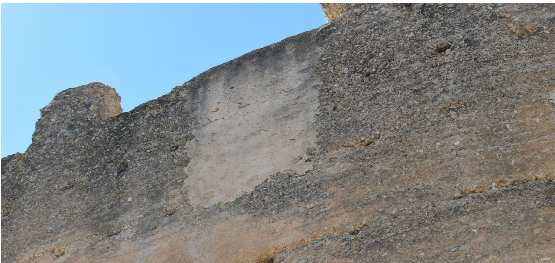
Imagen 61. Detalle 1.4. Rellenado de saetera en la línea de almenado del lienzo 1. Fuente: Autora.
