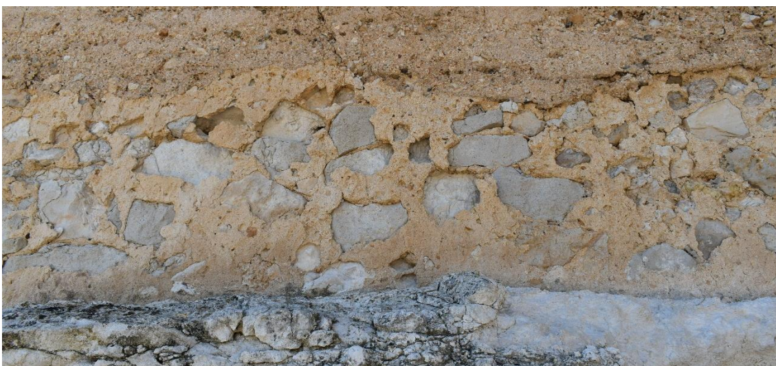
Imagen 62. Detalle 1.5. Recalce de mampostería con previa excavación en la base del lienzo 1. Fuente: Autora.
