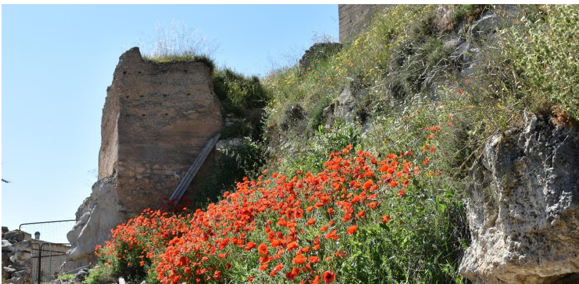
Imagen 77. Detalle 4. 4. Consolidación de los restos de la torre H. Fuente: Autora.
