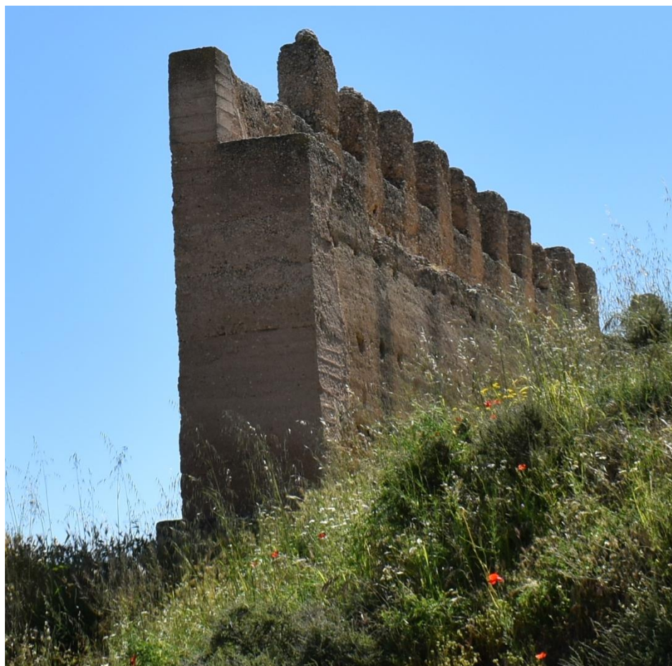
Imagen 74. Detalle 4. 1. Restauración y recrecido del lienzo 12 igualando el grosor original 1,15 m. Fuente: Autora.
