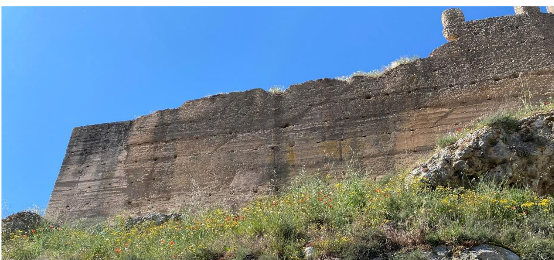
Imagen 76. Detalle 4. 3. Restauración del lienzo 12 , recrecido hasta el grosor original y tapado de mechinales. Fuente: Autora.
