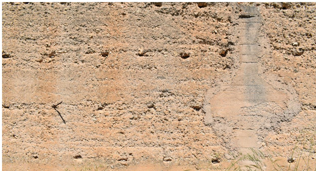
Imagen 70. Detalle 2.4. Rellenado de grietas previa limpieza, cepillado y picado. Consolidación con varillas. Fuente: Autora.
