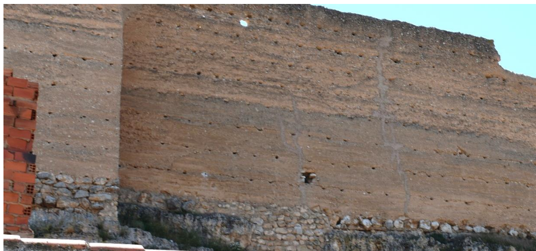
Imagen 69. Detalle 2.3. Excavado para recalde de la base y restauración de mampostería con mortero de cal. Fuente: Autora.
