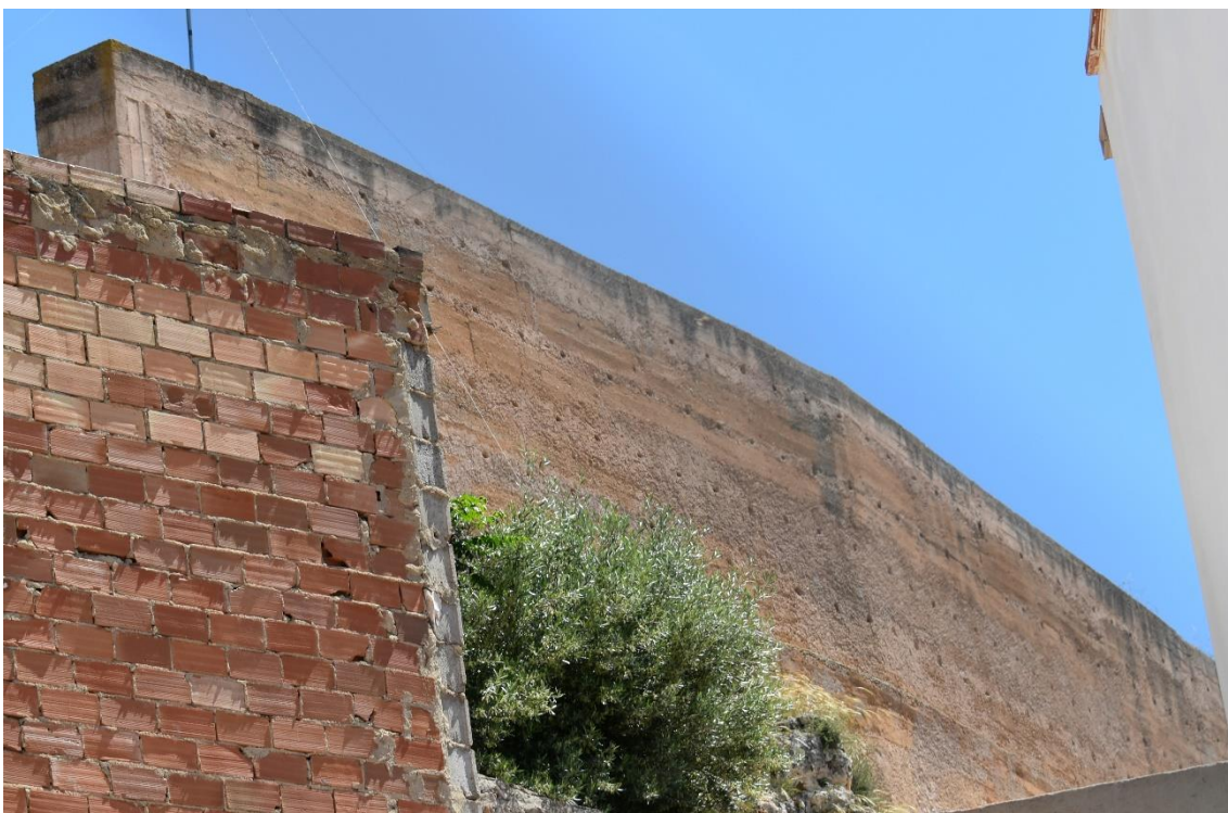
Imagen 72. Recalce y restauración de mampostería en base de la muralla con hormigón de cal, excavado a mano y encofrado remetido. Rellenado de grietas con previa limpieza, cepillado y picado. Fuente: Autora.
