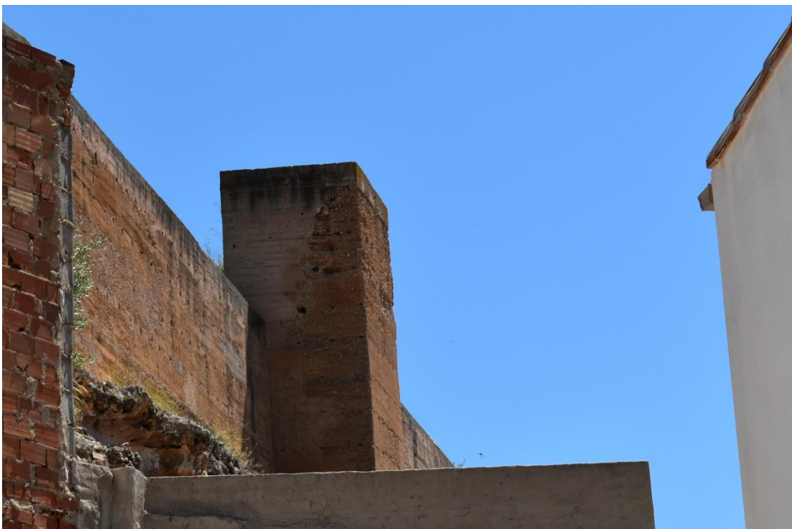
Imagen 73. Cajeados y zunchados para la coronación de las torres. Restauración de lienzos existentes y reconstrucción de los desaparecidos con espesor 1,15 metros hasta límite inferior de almenas, acabado hormigón de cal, piedra y arena parda. Fuente: Autora.
