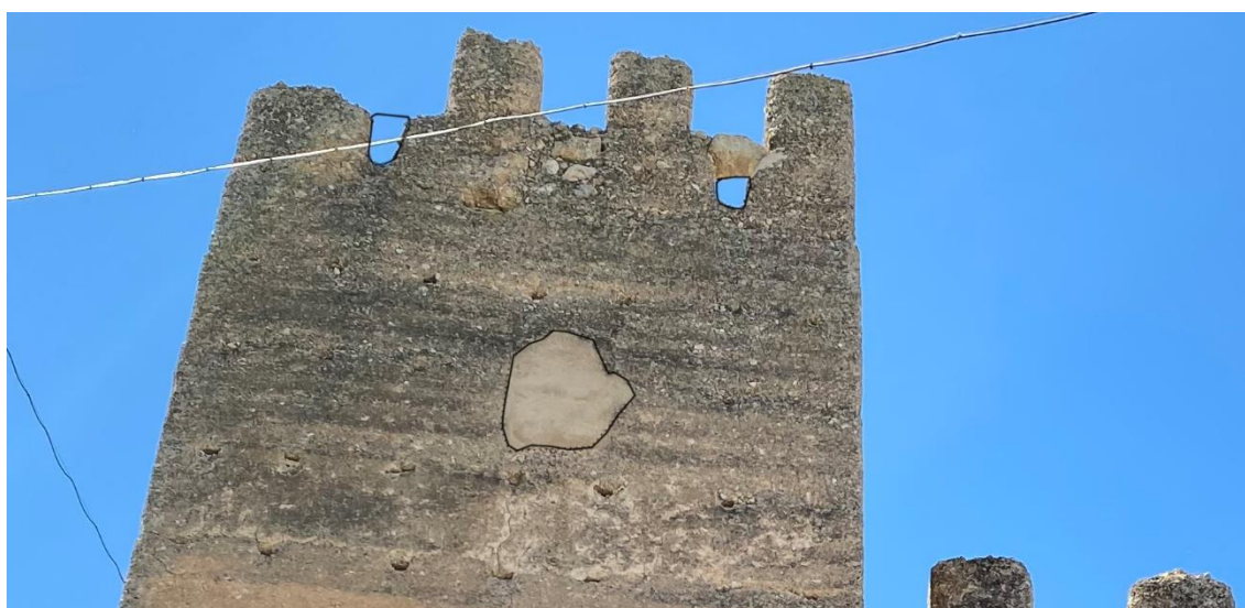
Imagen 50. Saetera de la Torre A en el tramo Norte. Perforaciones en los muros donde en época carlista eran utilizadas para defenderse frente al enemigo con flechas. Fuente: Autora.
