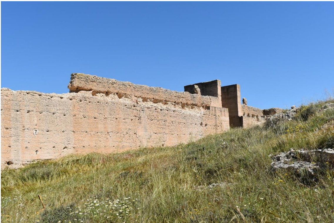
Imagen 23. Tramo Noroeste, vista interior. Fuente: Autora.
