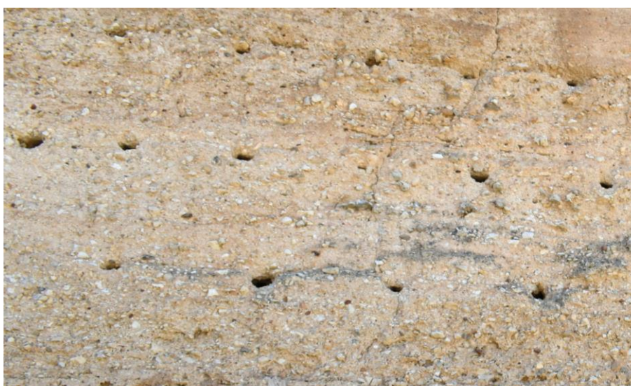
Imagen 108. Detalle de la erosión superficial del lienzo 1. Fuente: Autora.
