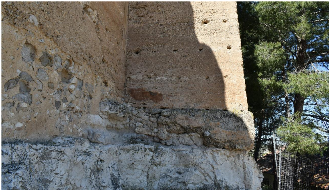
Imagen 52. Basamento Torre B del tramo Norte. Fuente: Autora.
