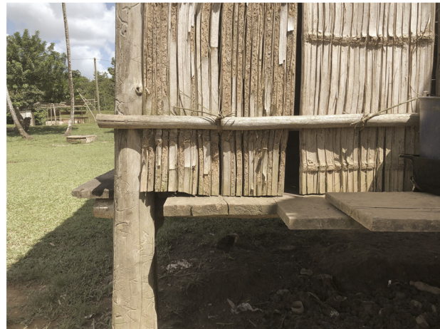
Detalle de unión de paneles de bambú. Comunidad: Santa María
