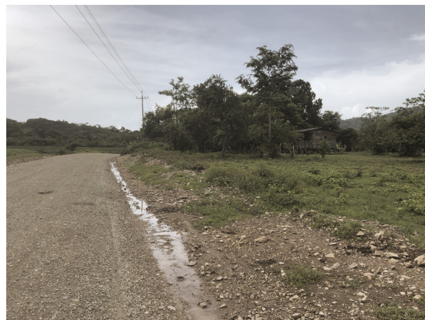
Estado actual de la carretera. Comunidad: Sakalwas
