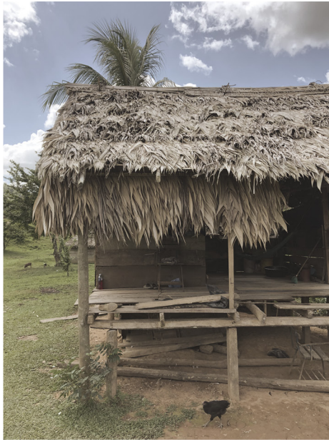
Vivienda tradicional Mayagna, con cubierta de Suita. Una de las últimas que viviendas que quedan en la reserva. Comunidad: Santa María
