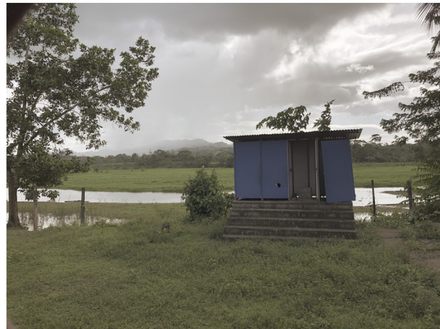
Letrina en zona inundable. Comunidad: Sakalwas
