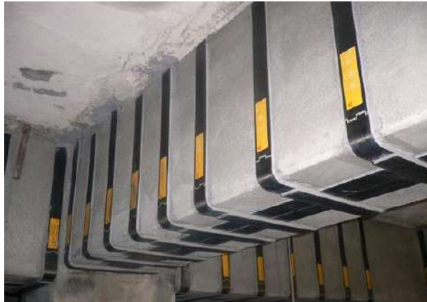
Figura 67. Refuerzo de una viga de hormigón armado con fibra de carbono.
