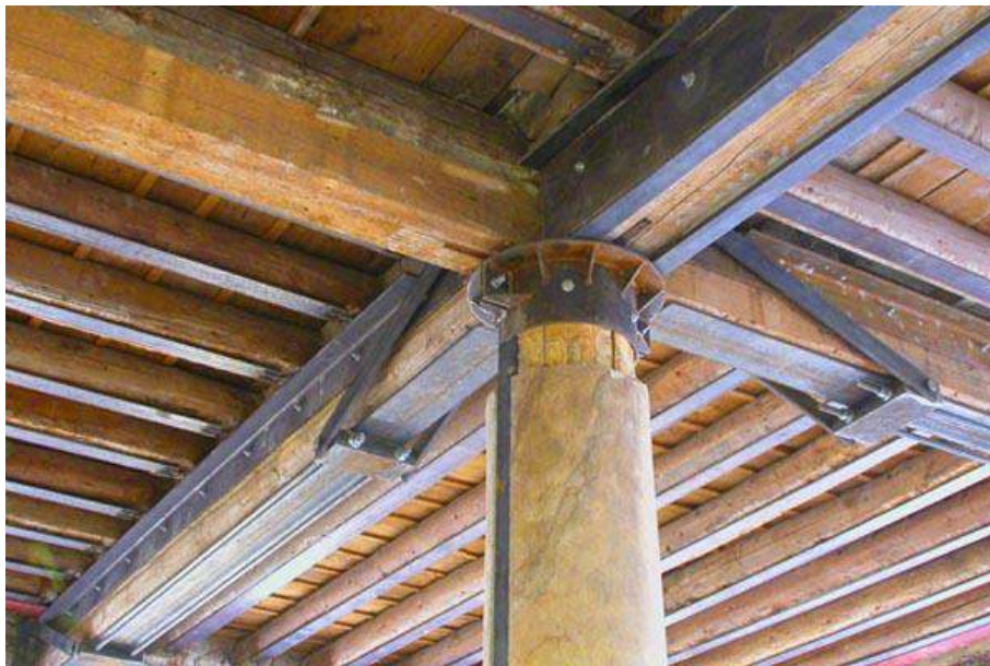
Figura 64. Refuerzo por la cara inferior de un forjado de madera.
