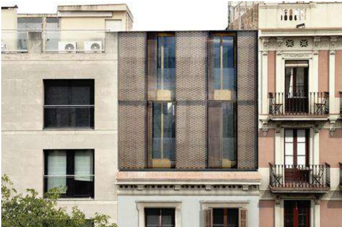
Figura 50. Edificio en la calle Enric Granados 69. Barcelona.
