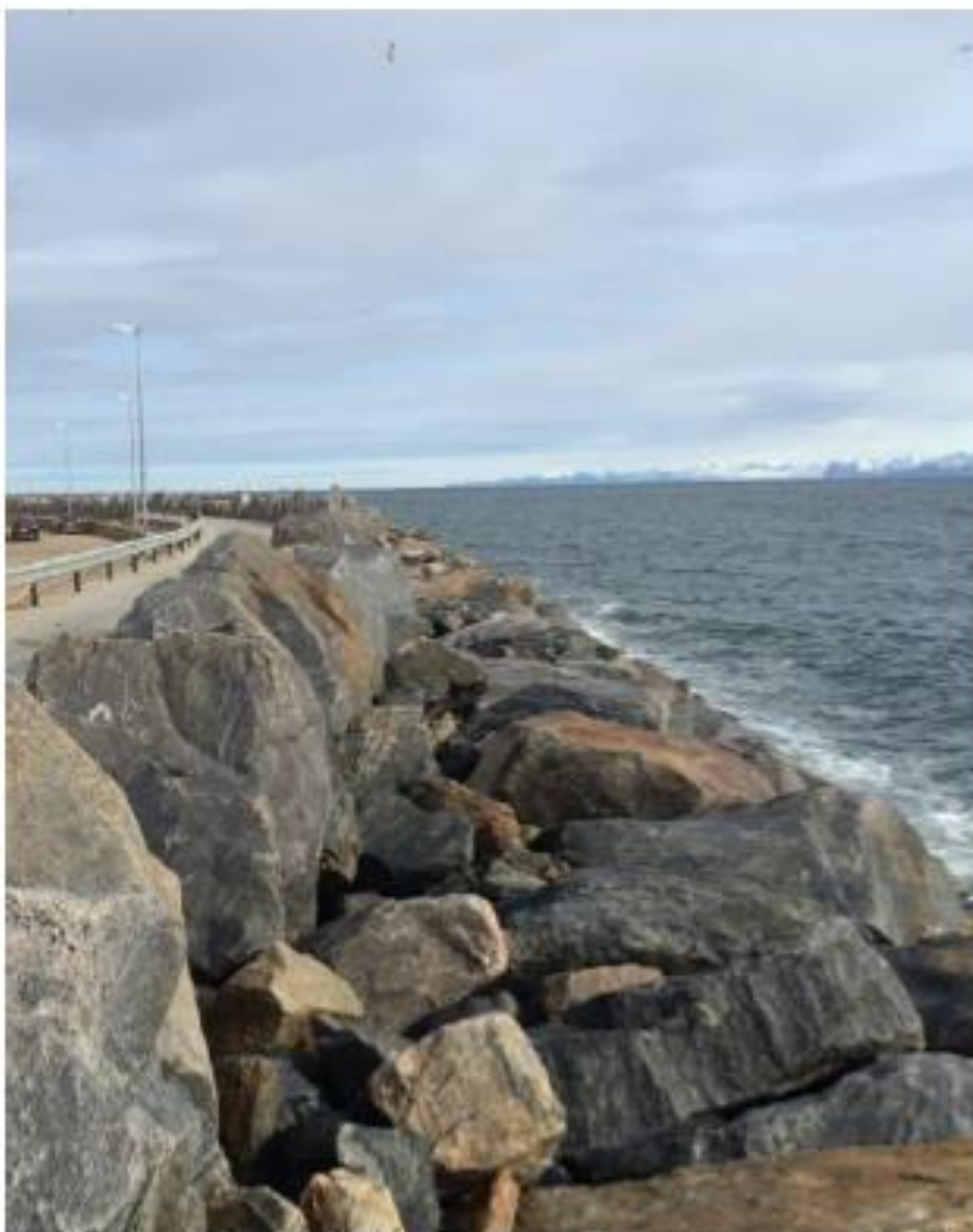
Imagen 8: Dique este del Puerto de Andenes (Norconsult, 2016)
