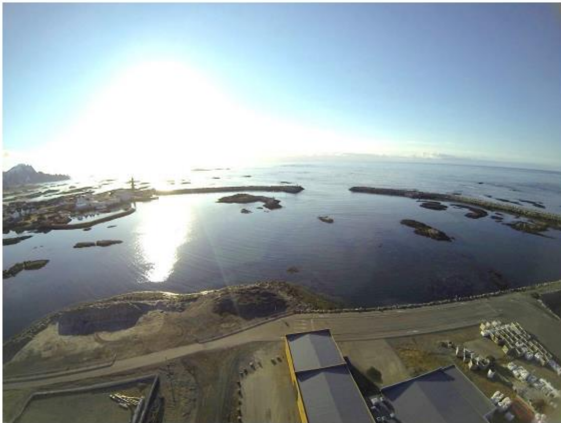
Imagen 17: Fotografía de Dron de la zona Oeste del Puerto (Norconsult, 2016)
