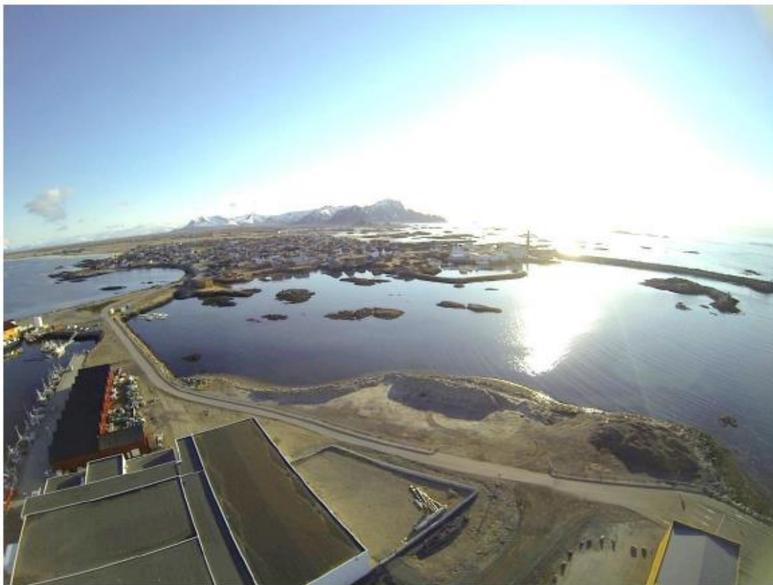
Imagen 16: Fotografía de Dron de la zona central del puerto (Norconsult, 2016)
