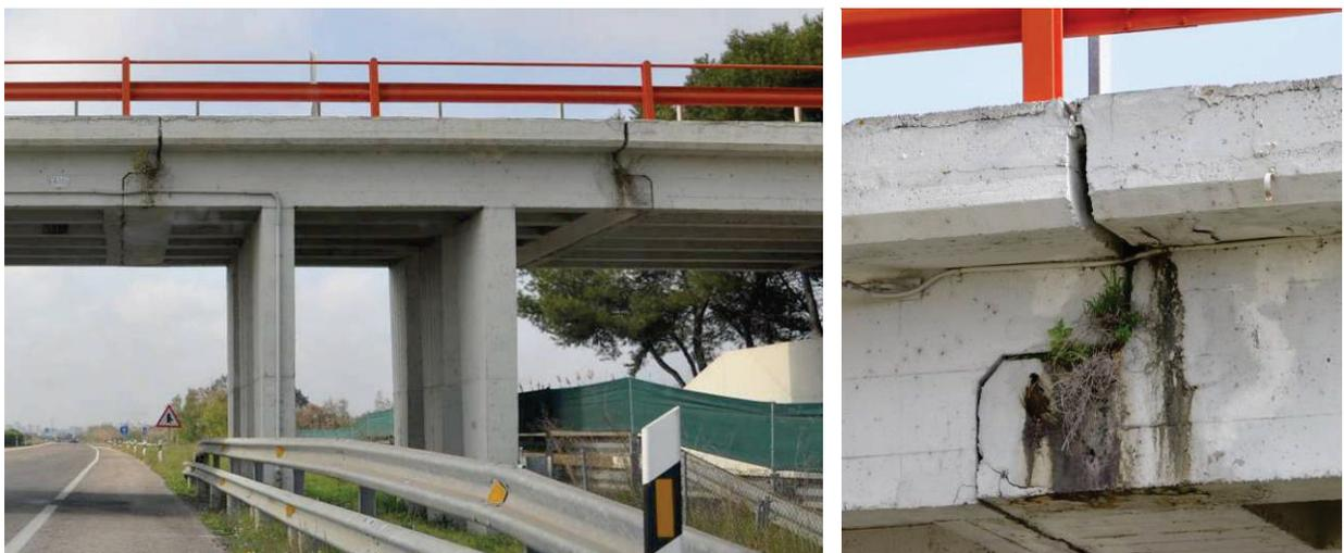
*Fotografía I.1: Apoyos a Media Madera en paso superior de carretera CV-500 en el Saler, con acumulación de humedad y crecimiento de plantas*
