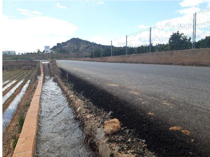
Figura 44. Acequia en el lado derecho
