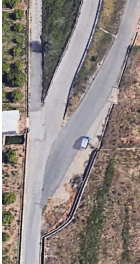
Figura 21. Intersección en Y (Fuente: Google Earth)
