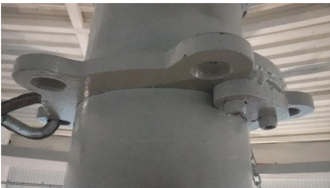
Abrazadera pilar para enganche par 2 línea de vida y los 2 cables superiores
