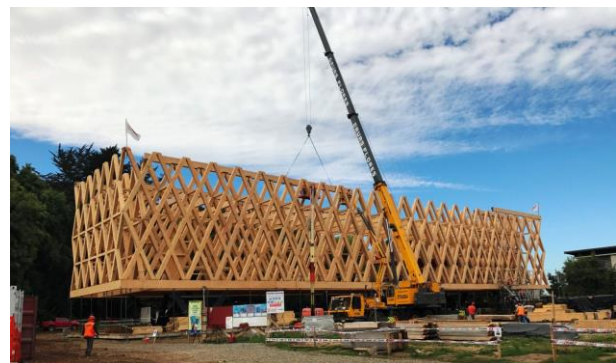
Figura 83. Grúa móvil para izado de grandes piezas
