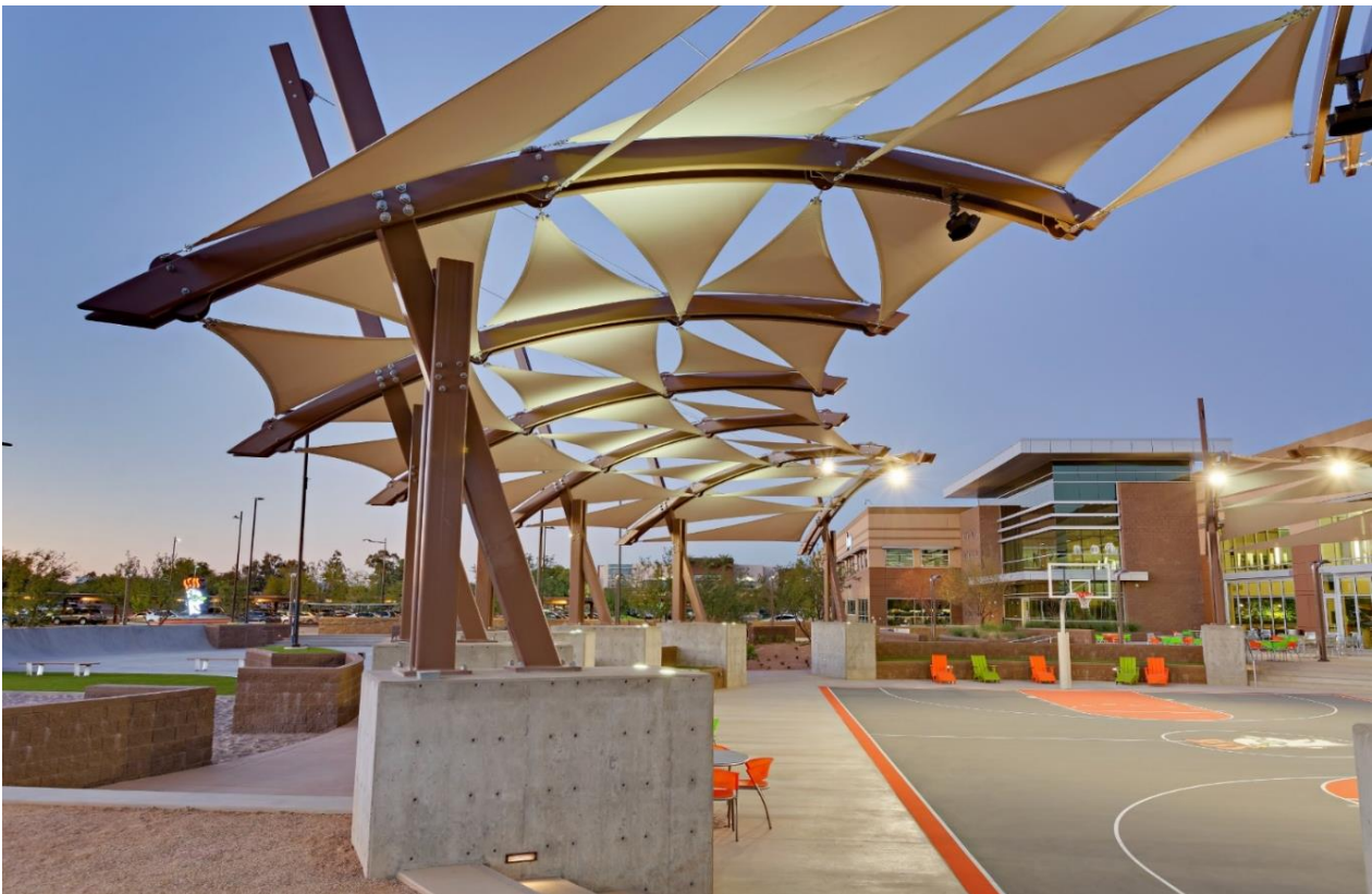
Figura 74. Estructura con cubierta de poliéster con recubrimiento de PVC. Fabricante: Giofex
