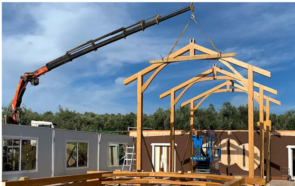
Figura 81. Montaje de estructura de madera
