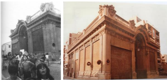
Figura 5 Estado del edificio Sindicat Arroser de Alfagar en los años 80
