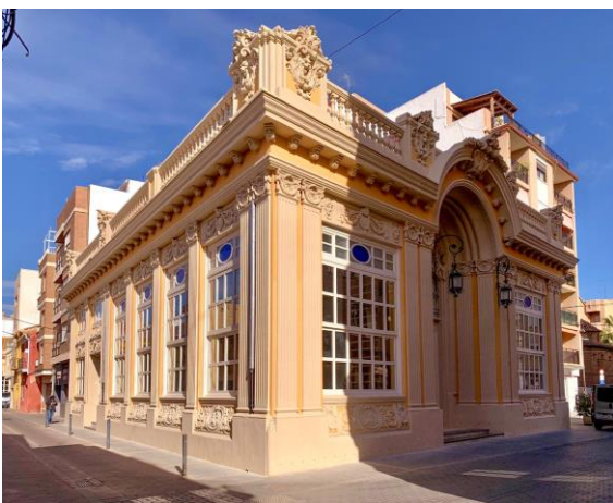
Figura 10 Fotografía del estado actual de la fachada antes y después de su intervención.
