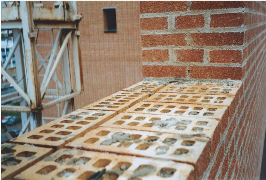
*Foto 2.1. Fábrica resuelta con una hoja exterior de pie y medio de ladrillo*
