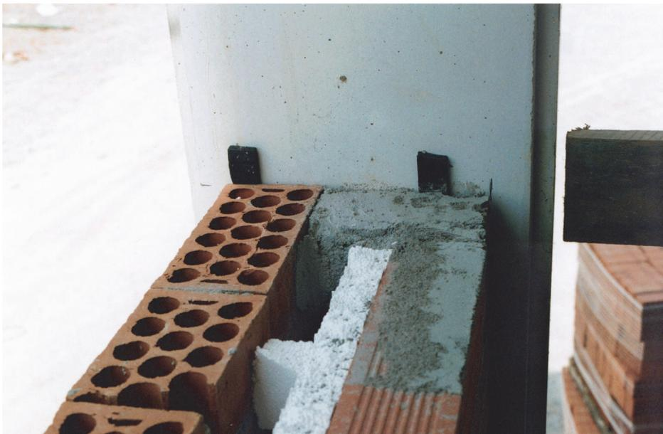
Foto 1.2. Composición de un cerramiento multicapa
