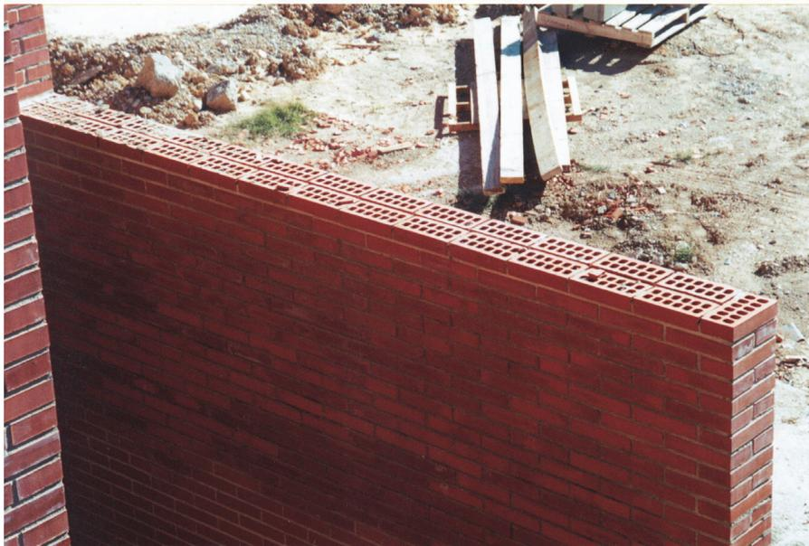
*Foto 2.2. Fábrica resuelta con muro doblado*
